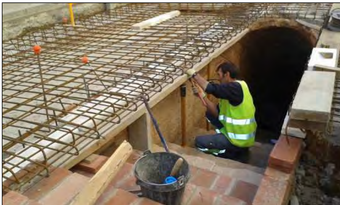
Foto 103: Tram 1. Procés de l'obra. Encofrant per a formigonar.
