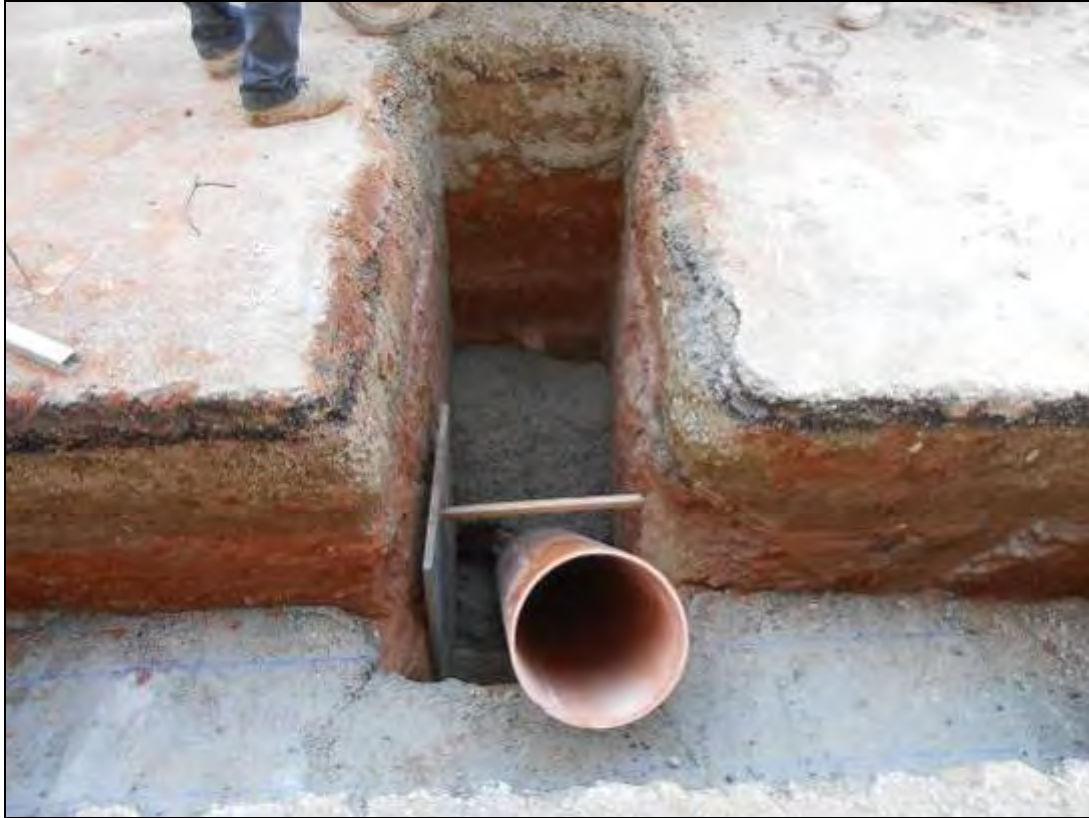
Foto 167: Tram 3. Vista del tub per a l'embornal amb el tauló per a tapar la galeria i el formigó.
