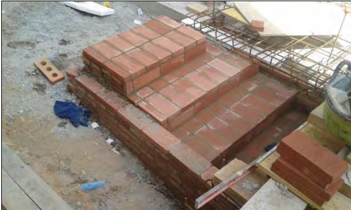
Foto 102: Tram 1. Construcció d'escales per a l'accés al refugi.
