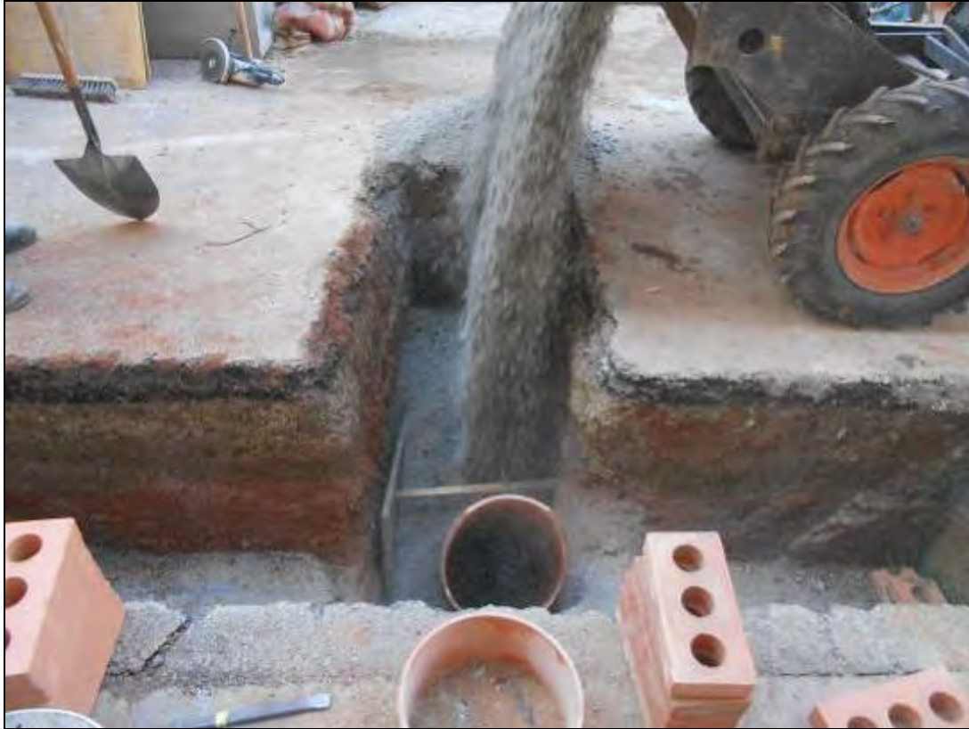
Foto 169: Tram 3. Tapant la rasa amb el formigó.
