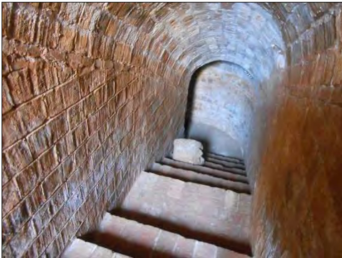
Foto 273: Accés al refugi.
