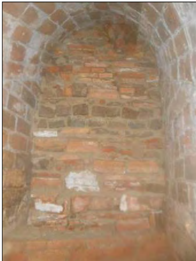
Foto 379: Accés tapiat al tram final.
