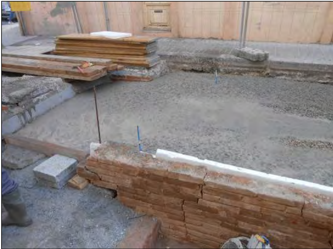
Foto 86: Tram 1. Procés de l'obra.
