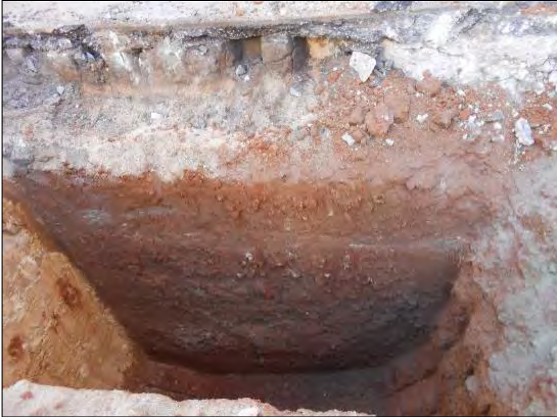
Foto 4: Tram 1. Rasa per al col·lector.
