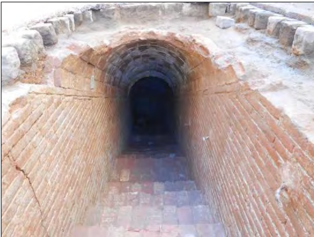
Foto 267: Accés al refugi.
