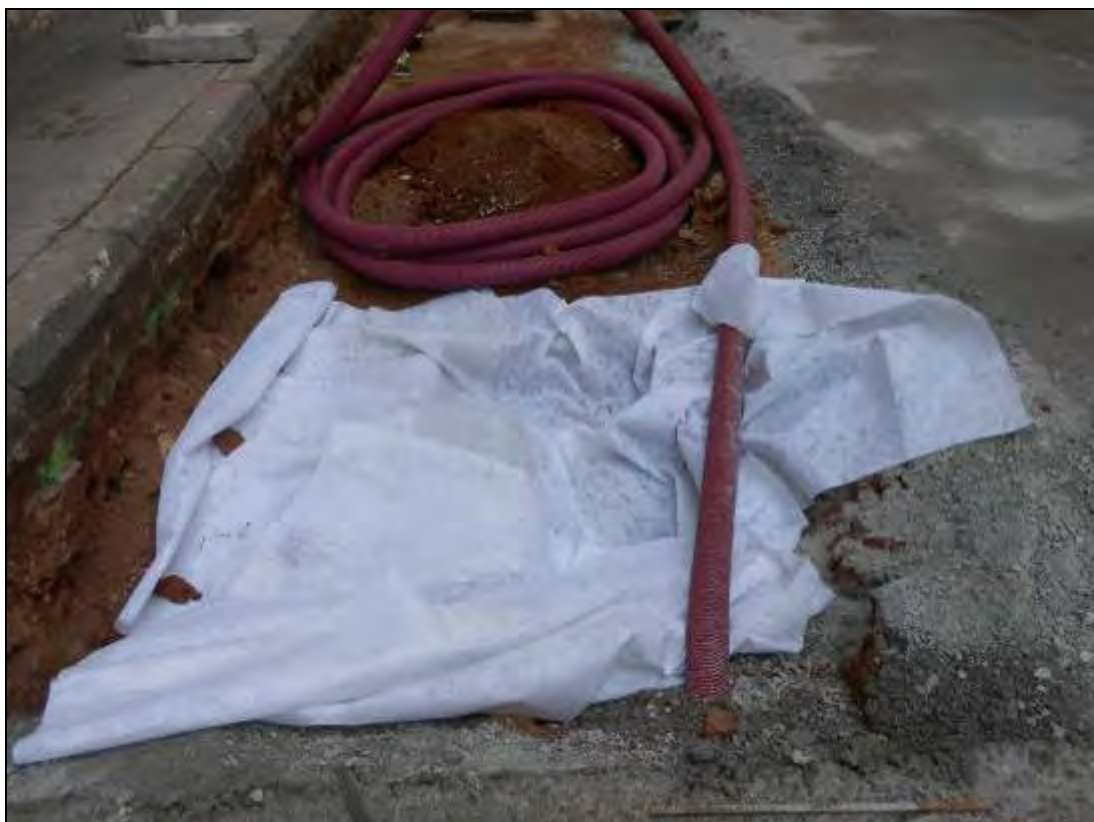
Foto 208: Tram 4. Es cobreix l'estructura (UE: 200) amb tela geotèxtil.
