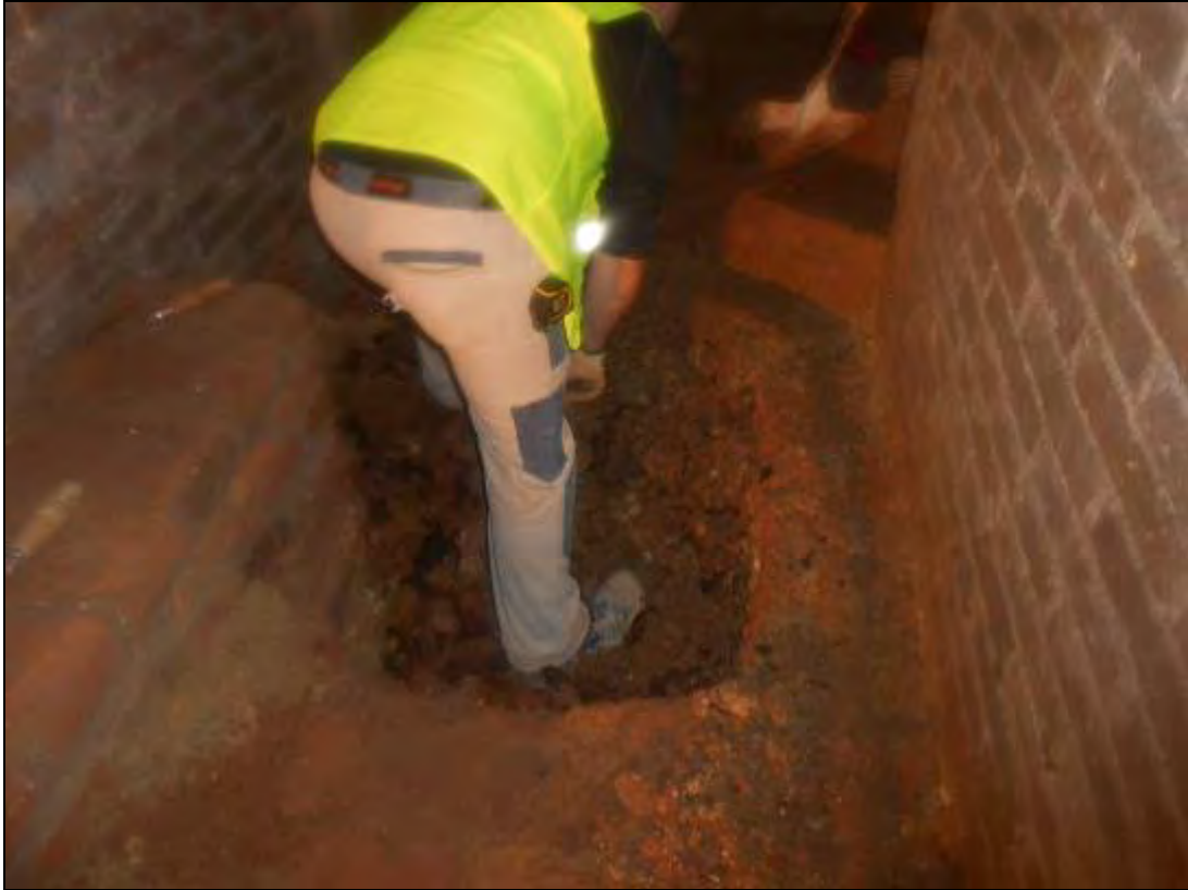
Foto 380: Excavació del Retall UE: 104.
