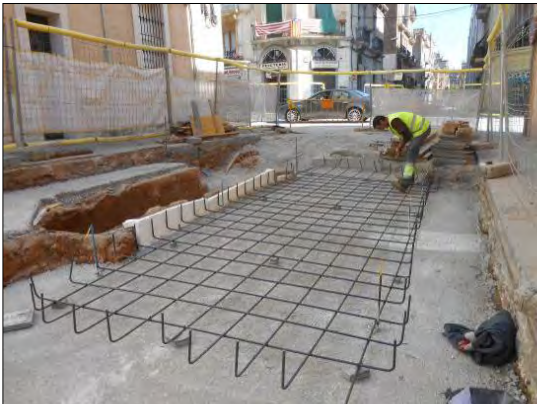
Foto 89: Tram 1. Es posa la malla de ferro.
