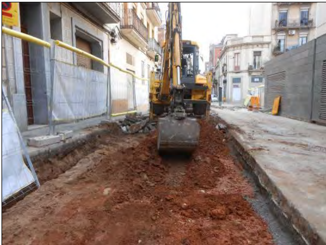
Foto 142: Tram 2. Seguiment de les obres. Rebaix del carrer.
