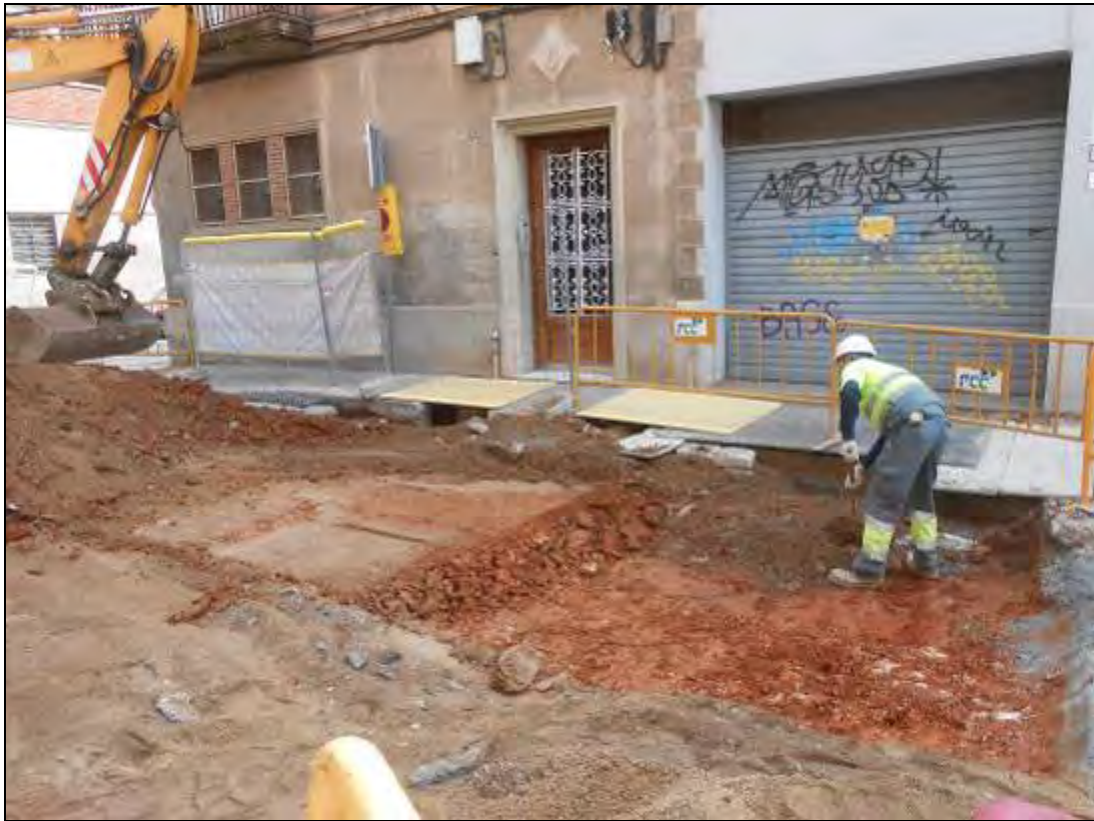
Foto 217: Tram 4. Obres entre els carrers Nació i Sospir.
