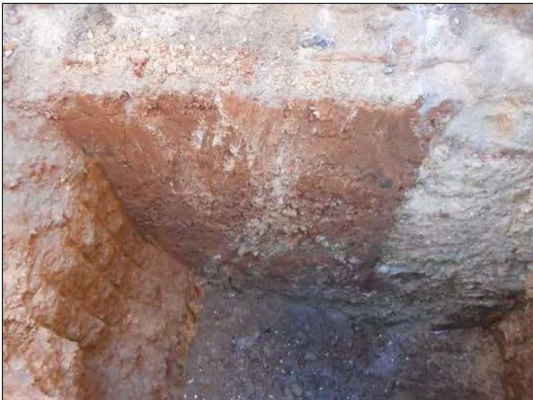
Foto 5: Tram 1. Rasa per al col·lector.
