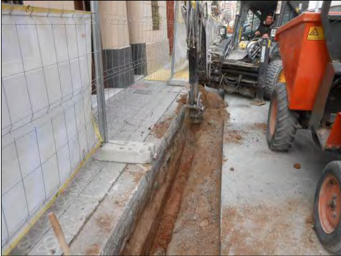
Foto 137: Tram 2. Rasa per a soterrar el cablejat elèctric de les cases.
