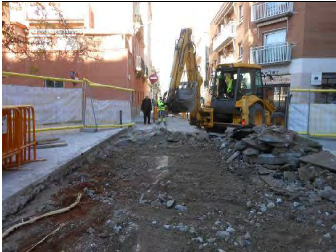
Foto 171: Tram 3. Aixecament del paviment.
