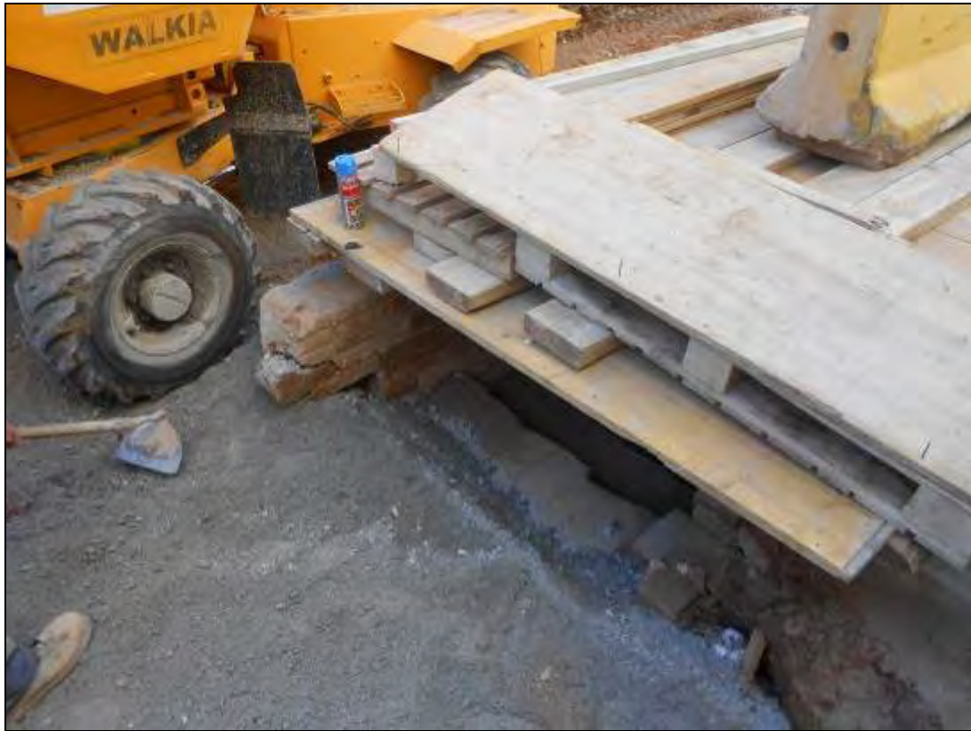
Foto 80: Tram 1. Vista de l'accés del refugi durant el procés de l'obra.
