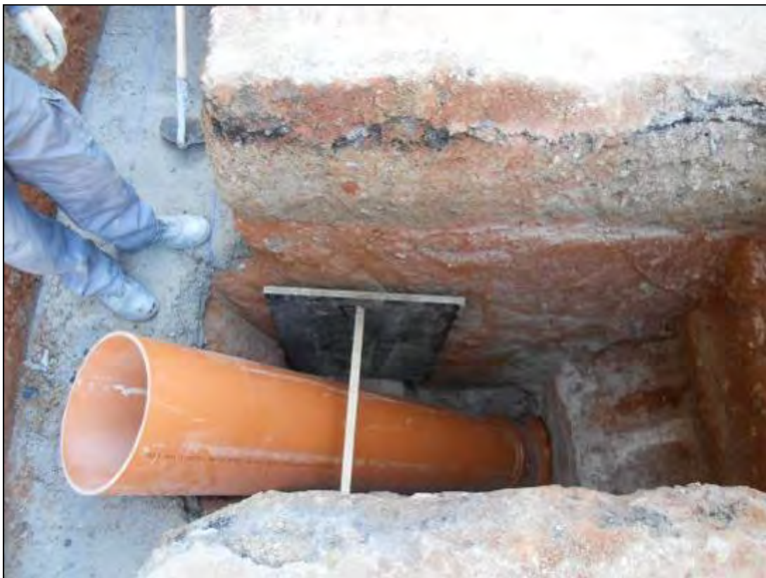
Foto 166: Tram 3. Vista del tauló per a tapar la galeria.
