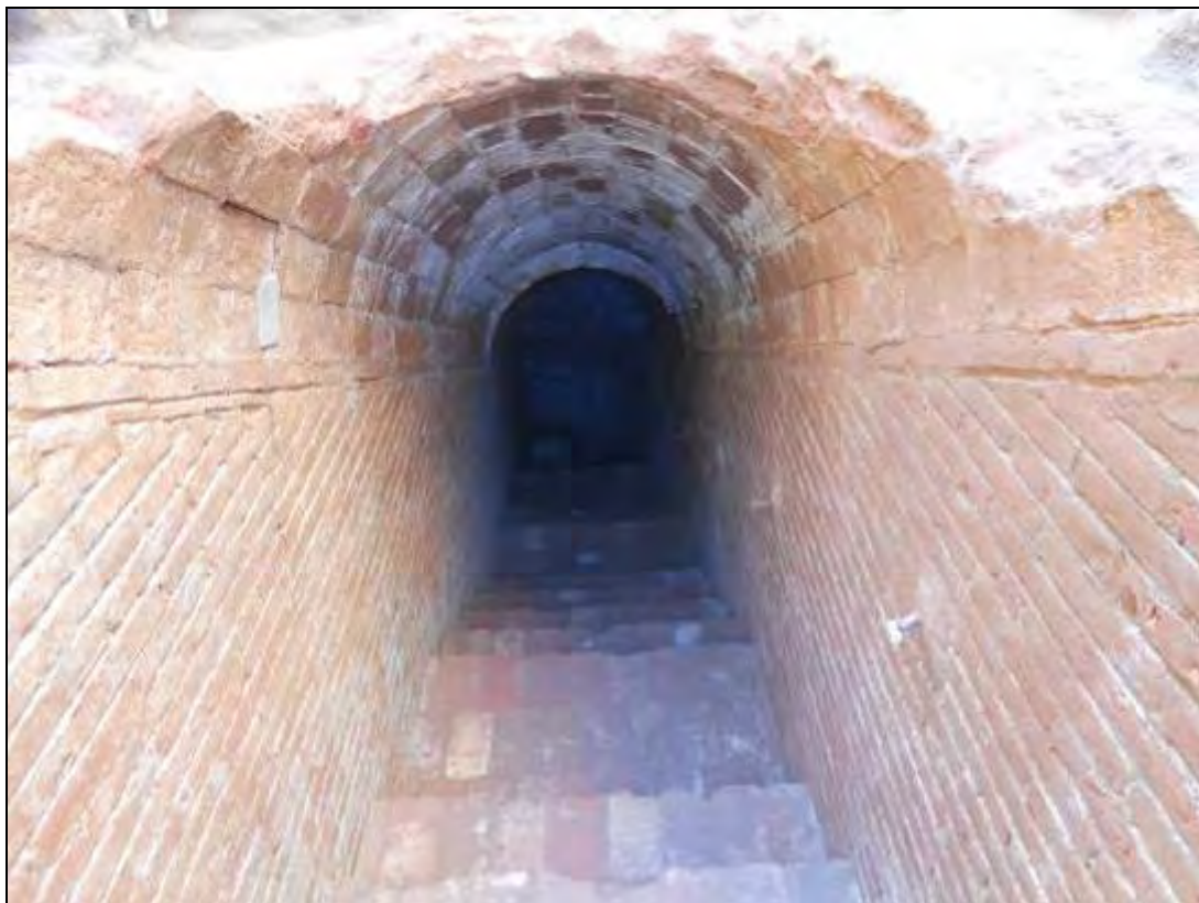
Foto 269: Accés al refugi.
