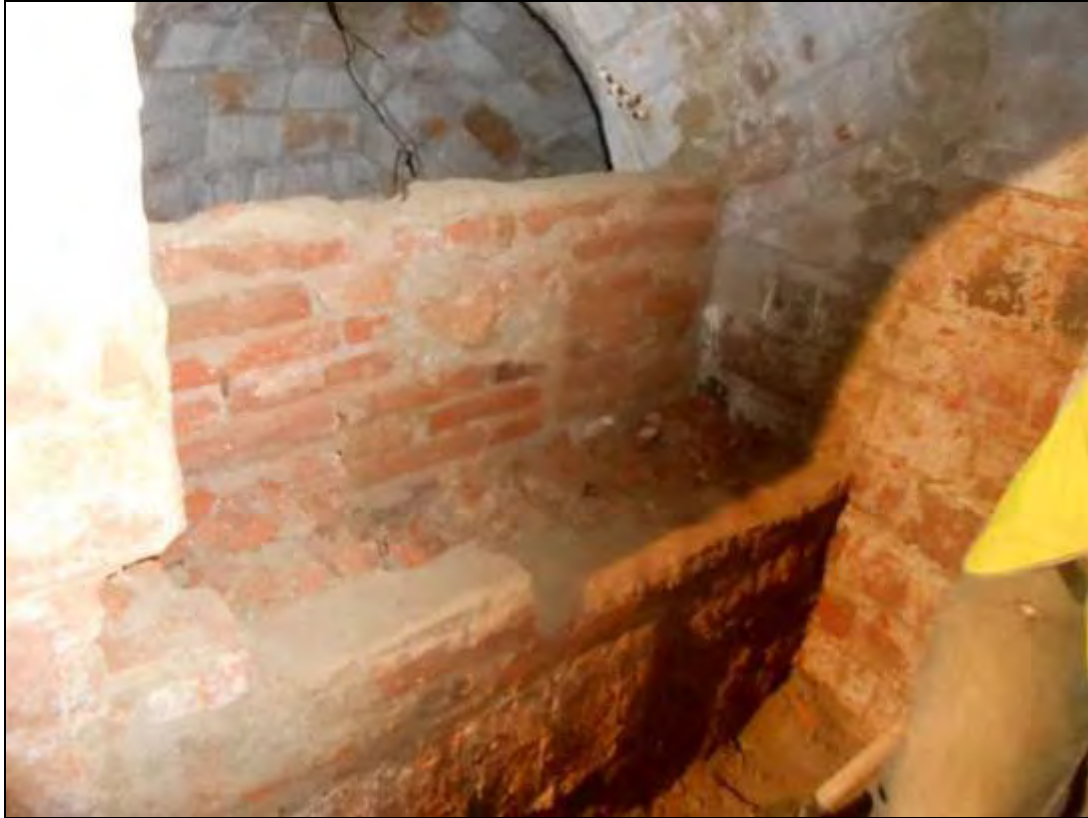
Foto 248: Vista de la doble paret de totxos.
