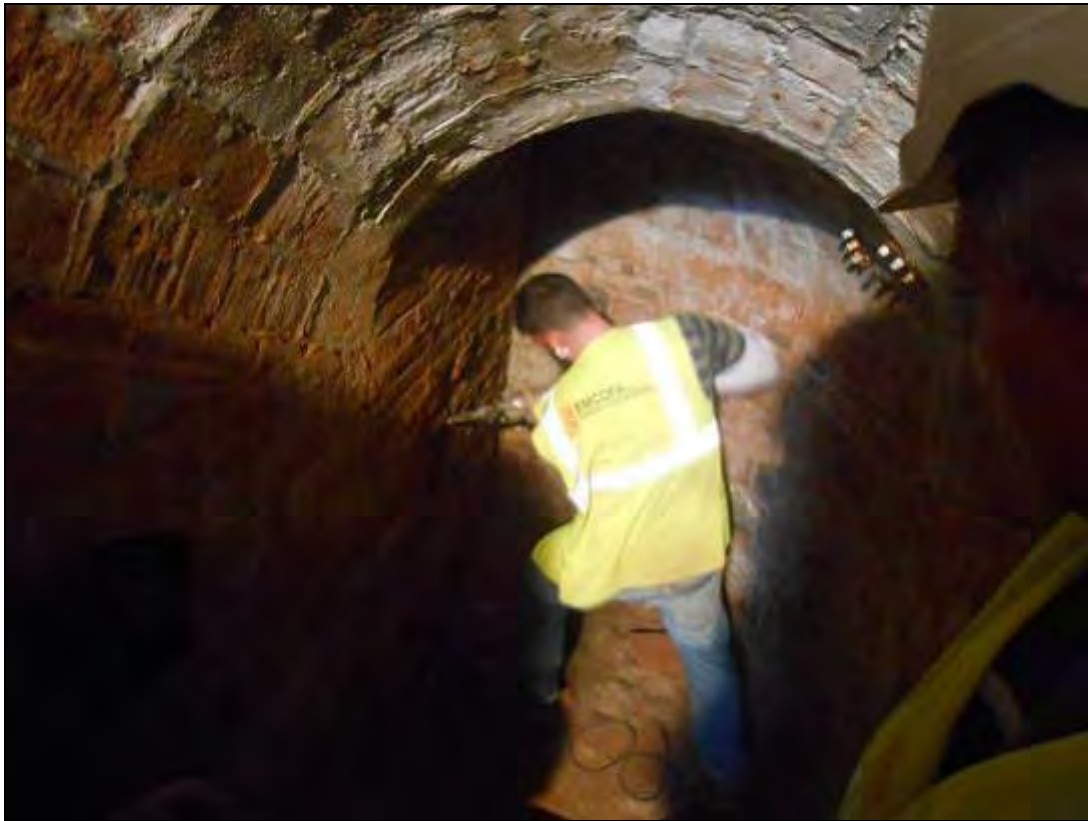
Foto 244: S'enruna l'accés tapiat amb un martell pneumàtic.
