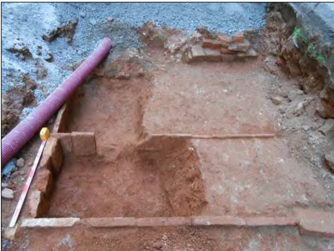
Foto 206: Tram 4. Vista del sondeig efectuat a l'estructura indeterminada (UE: 200).
