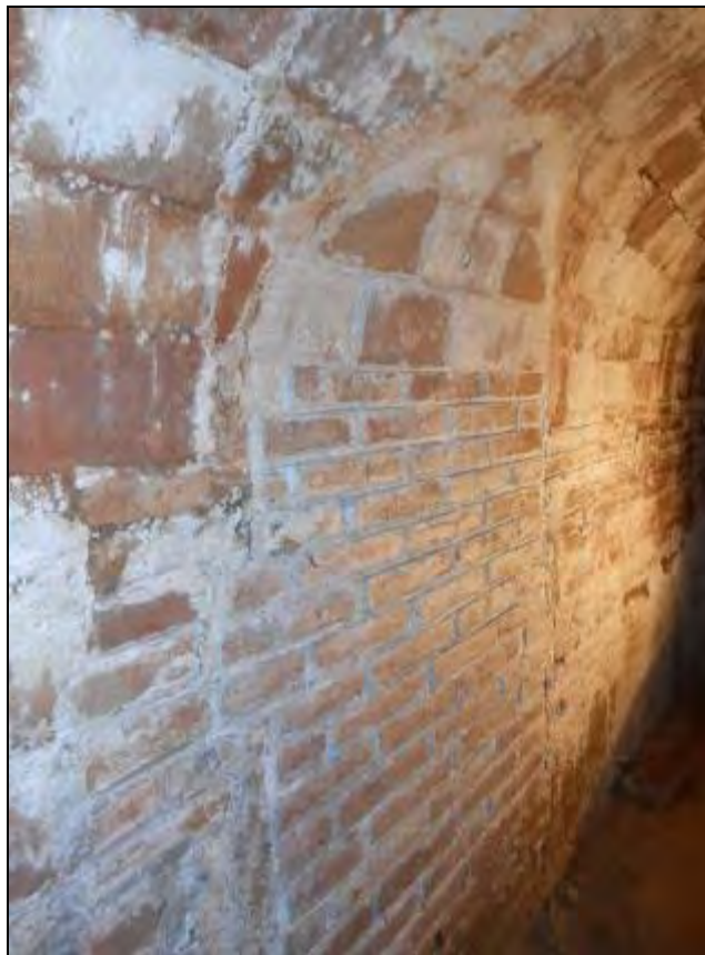
Foto 365: Accés tapiat al passadís del banc 9. Segurament enllaçaria amb l'obertura practicada a la paret de la dreta del ramal 4.
