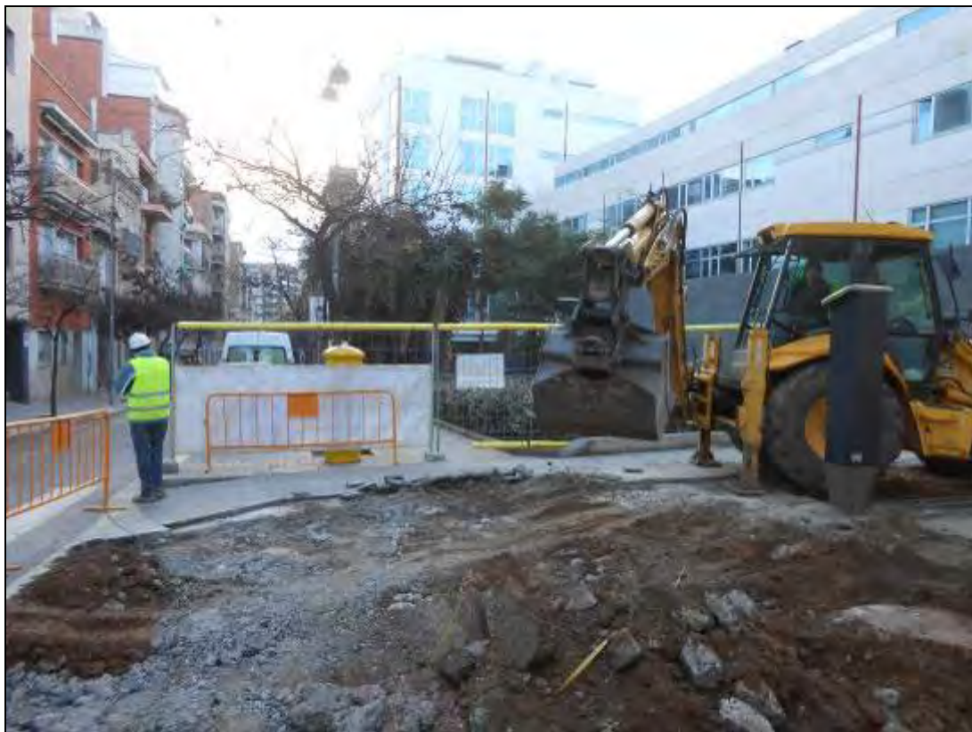
Foto 144: Tram 2. Rebaix del carrer a la cantonada amb Nació.
