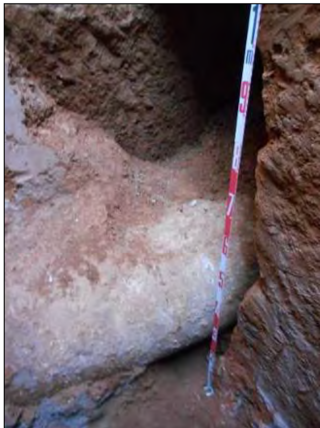
Foto 159. Tram 3. Galeria descoberta durant les obres. Es veu el tub de formigó passant pel seu interior.
