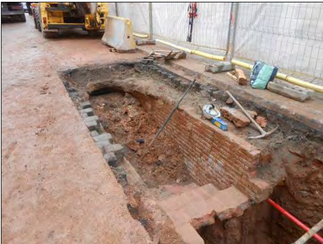
Foto 35: Tram 1. Vista de l'accés al refugi.
