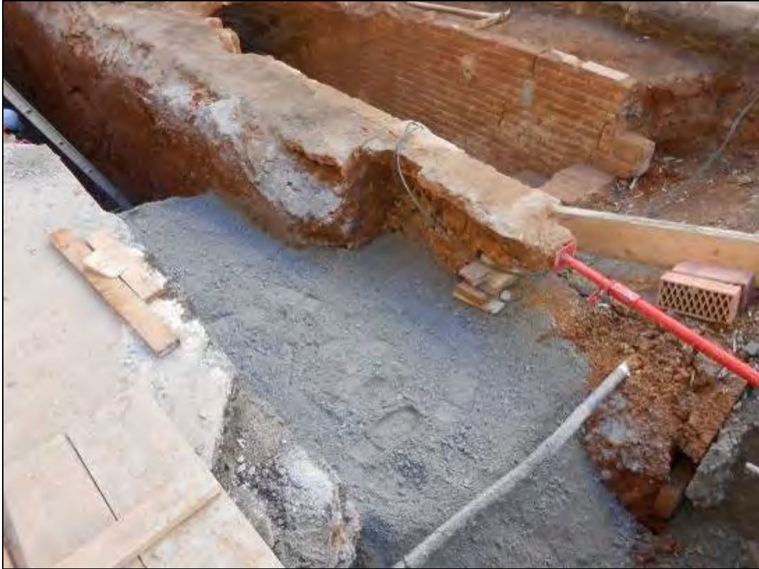
Foto 58: Tram 1. Procés de l'obra.
