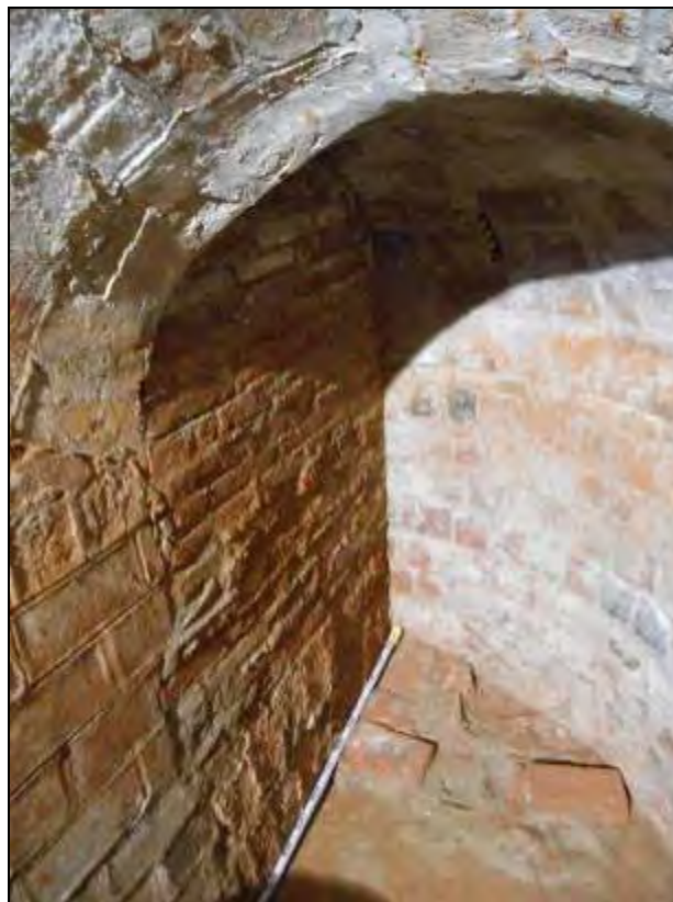
Foto 241: Vista de l'accés tapiat del refugi.
