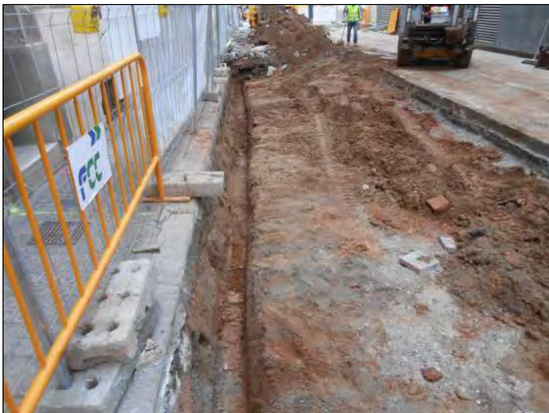
Foto 140: Tram 2. Rasa per a soterrar el cablejat elèctric.
