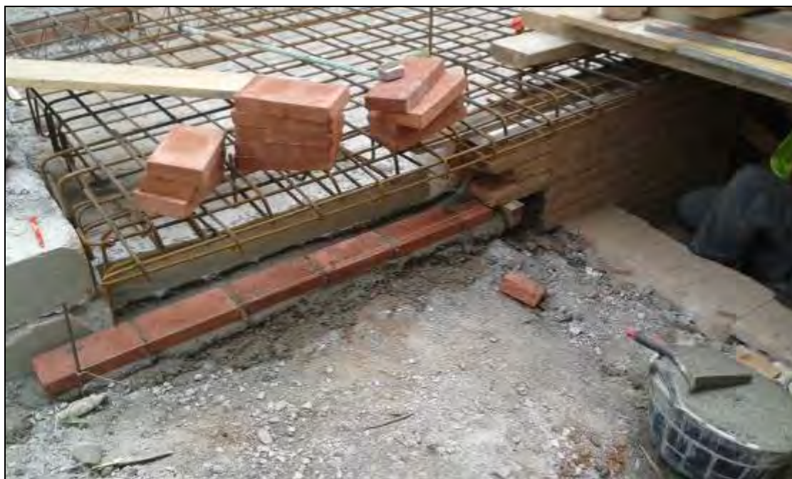
Foto 95: Tram 1: Construcció d'escales per a l'accés al refugi.
