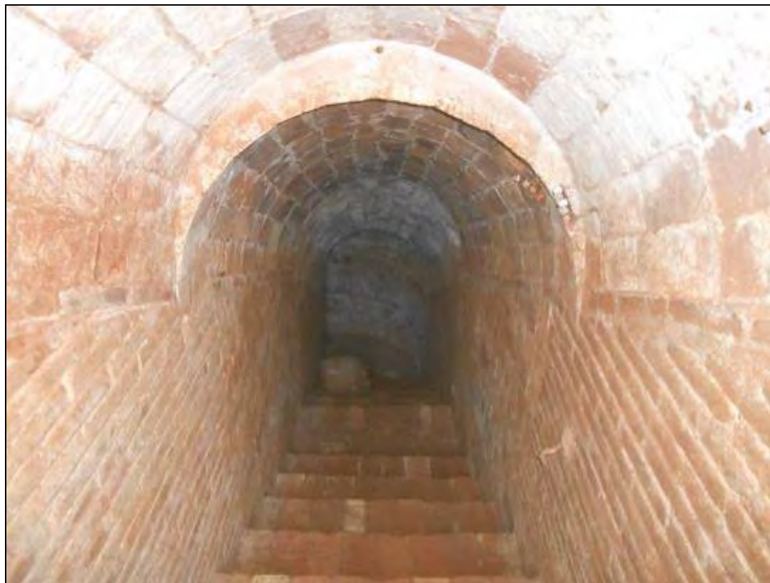
Foto 271: Accés al refugi.
