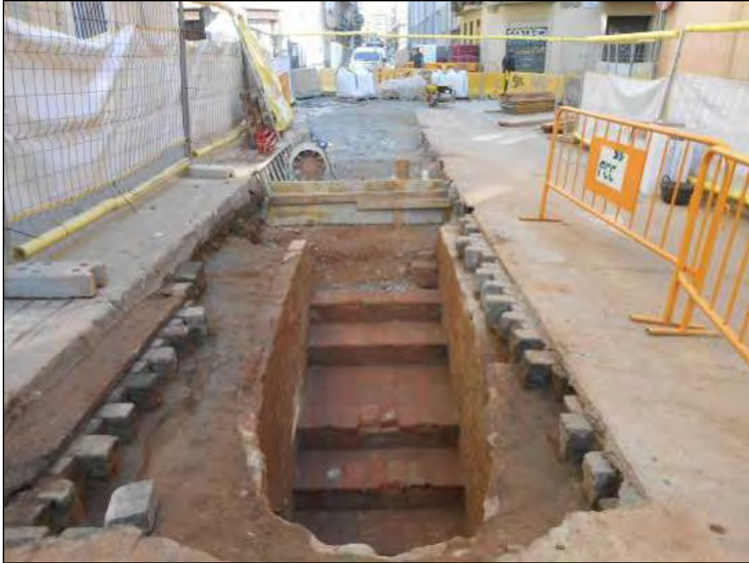
Foto 260: Accés al refugi.
