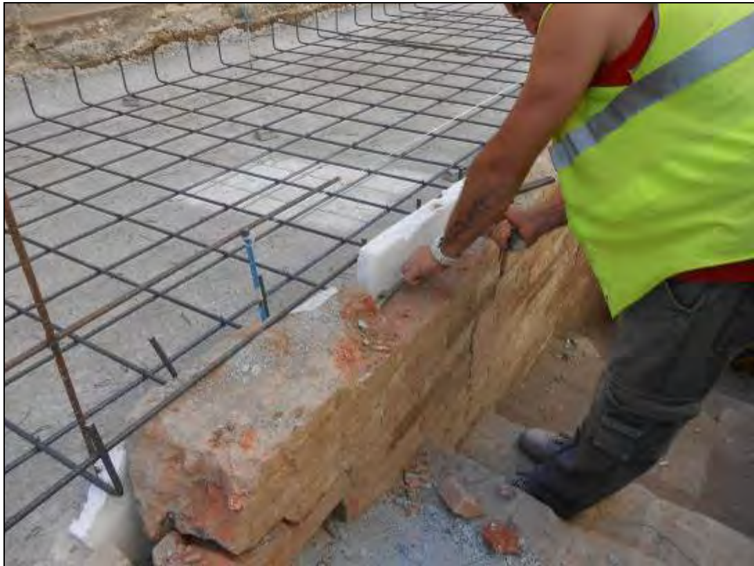
Foto 90: Es treu una filada de maó de la paret del refugi.
