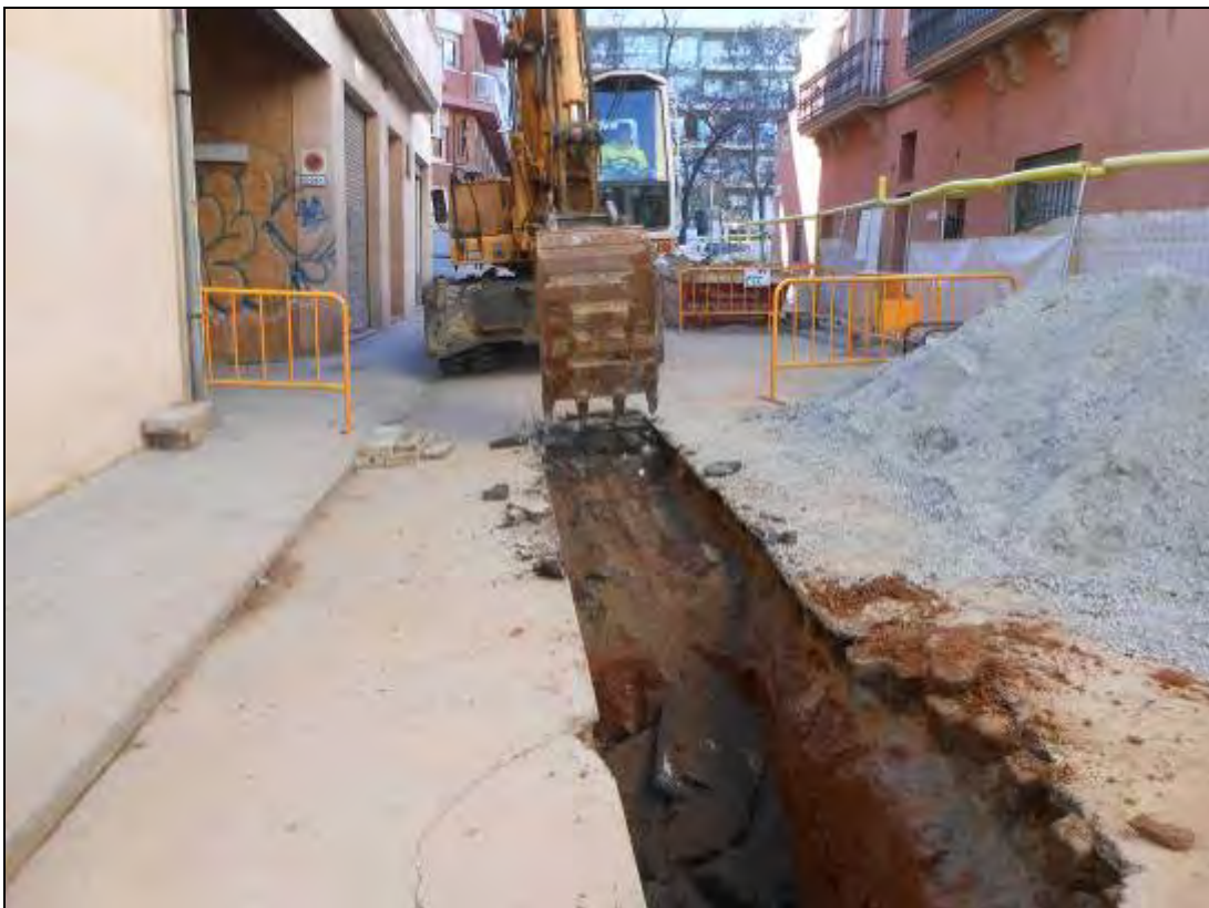
Foto 53: Tram 1. Rasa per al col·lector al costat del refugi.
