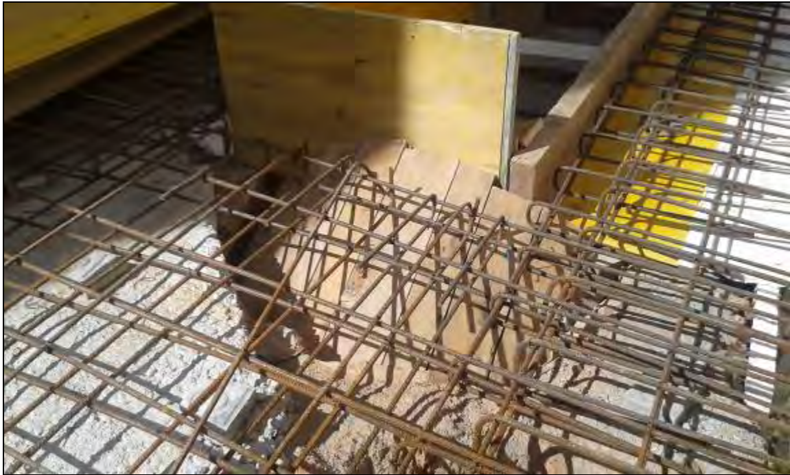
Foto 106: Tram 1. Procés de l'obra. Encofrant per a formigonar.
