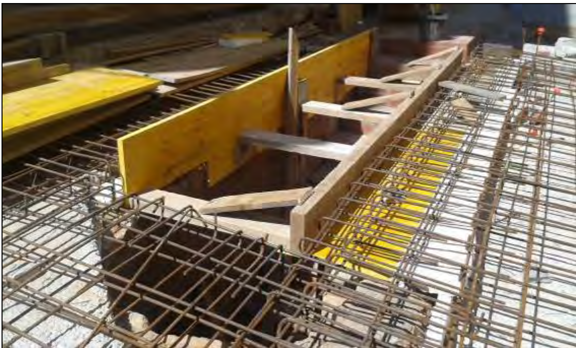
Foto 105: Tram 1. Procés de l'obra. Encofrant per a formigonar.
