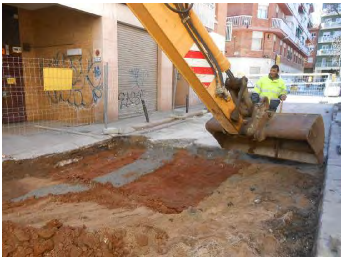
Foto 63: Tram 1. Rebaix del terreny al costat del refugi.
