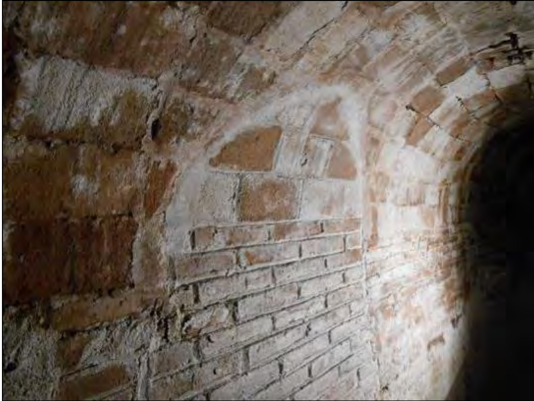
Foto 366: Vista de detall de l'accés tapiat.
