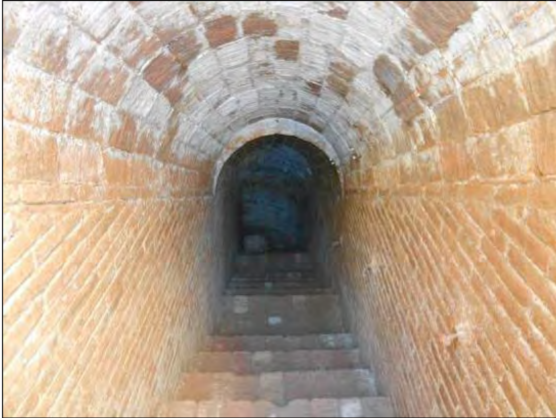
Foto 270: Accés al refugi.
