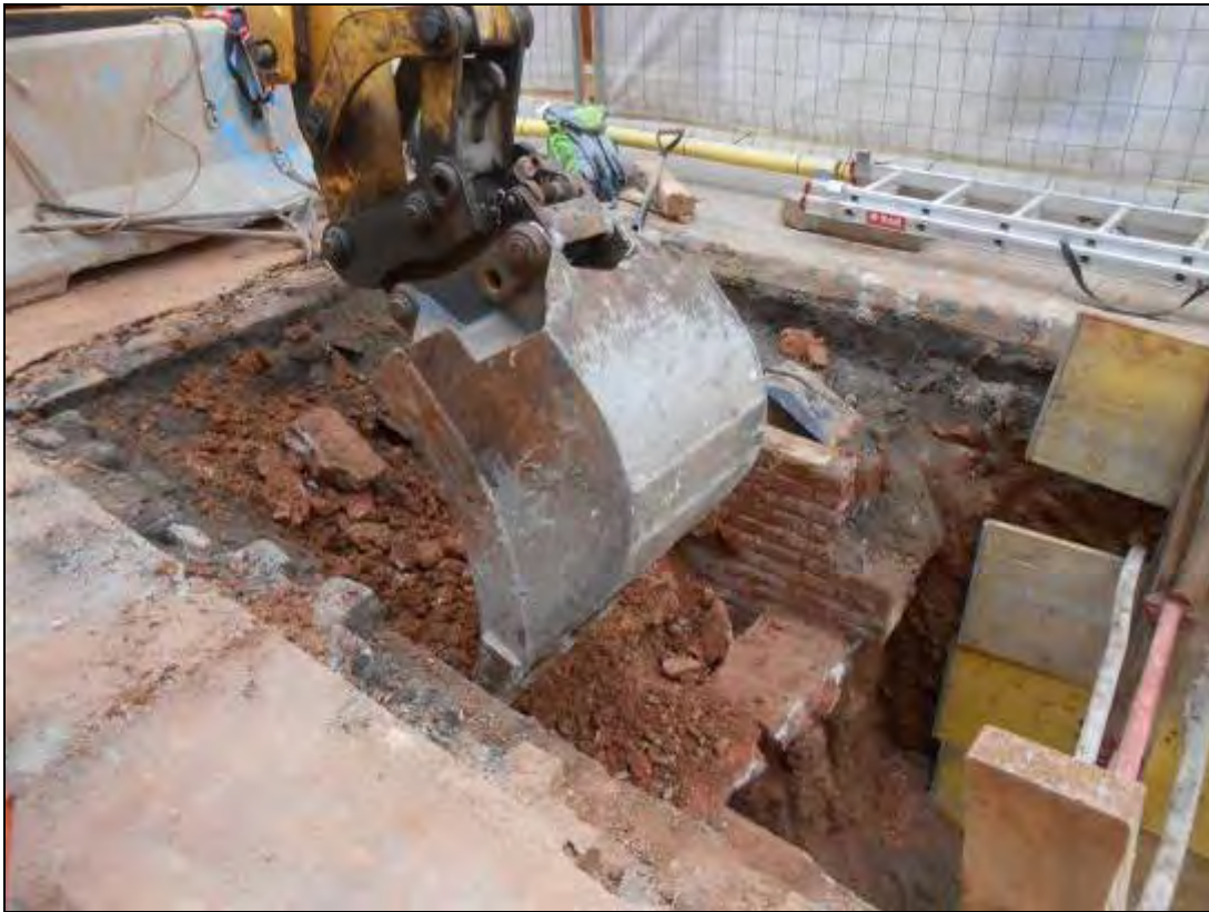
Foto: 224: Treballs d'extreure la terra que cobreix tot l'accés del refugi.
