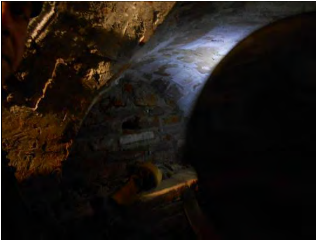
Foto 246: Es pot apreciar la doble paret de totxos amb un espai ple de runa.
