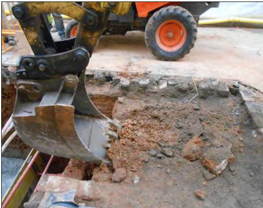
Foto: 223: Un cop es veu clarament que son escales, es passa a extreure la terra amb la retroexcavadora.
