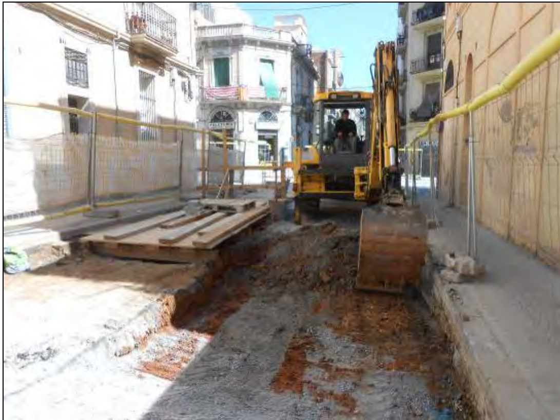
Foto 70: Tram 1. Rebaix del carrer al costat del refugi.
