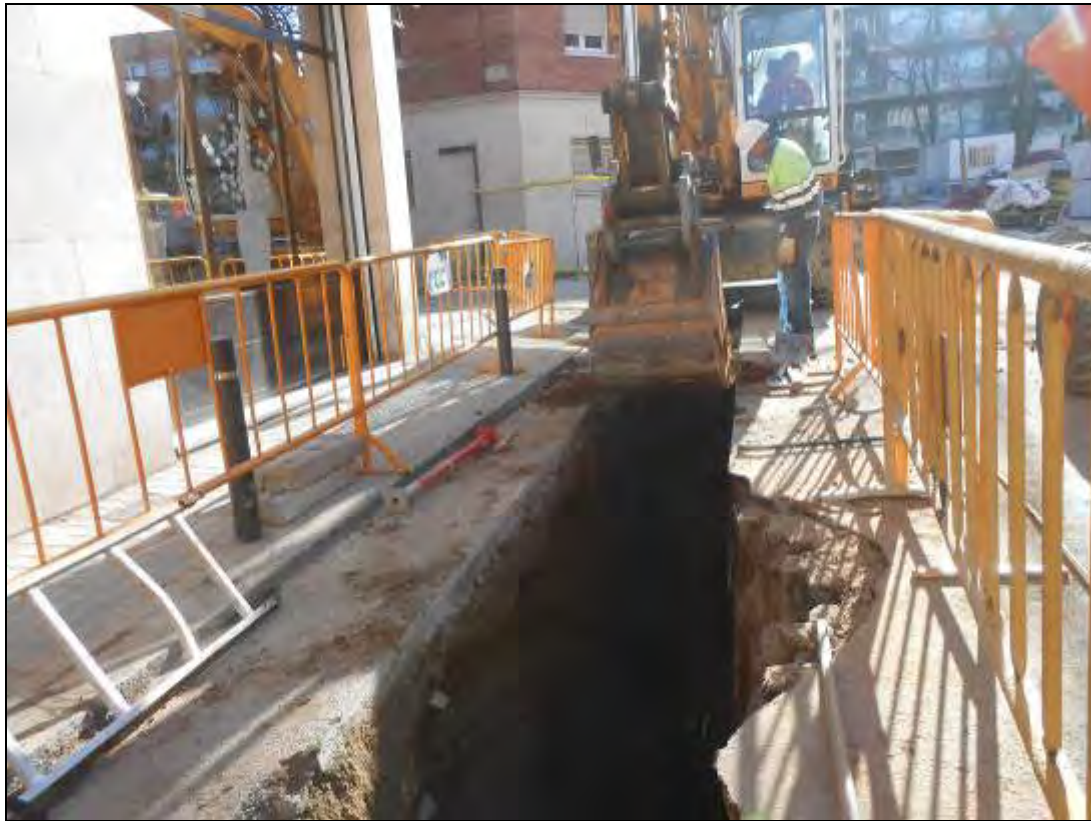
Foto 56: Tram 1. Procés de l'obra.
