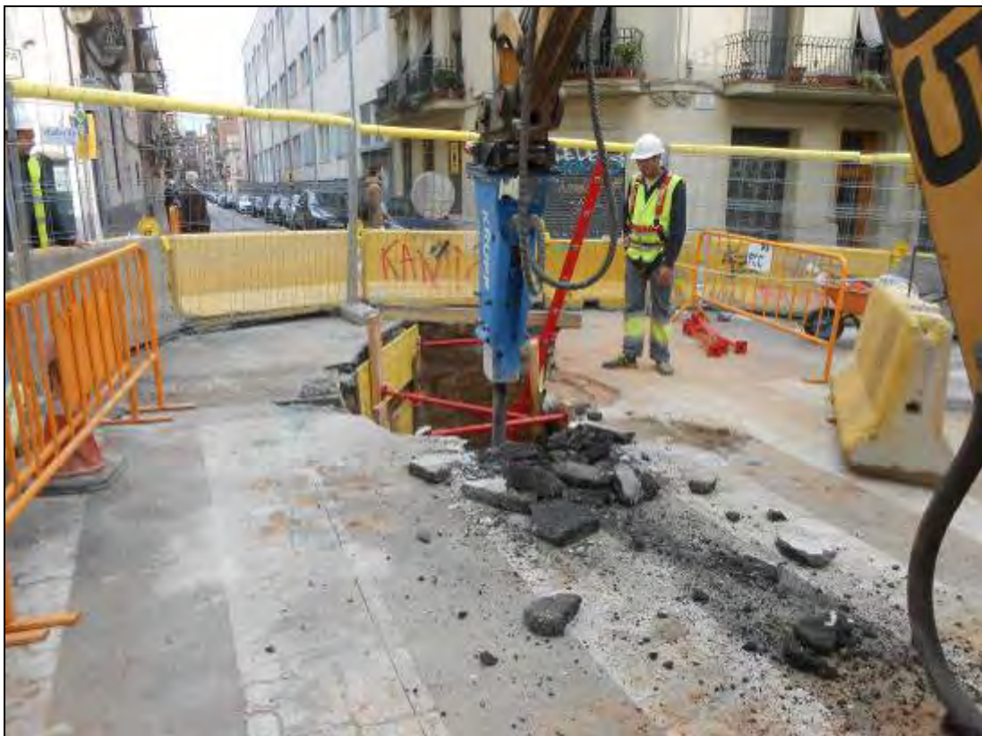
Foto 13: Tram 1. Rasa per al col·lector.
