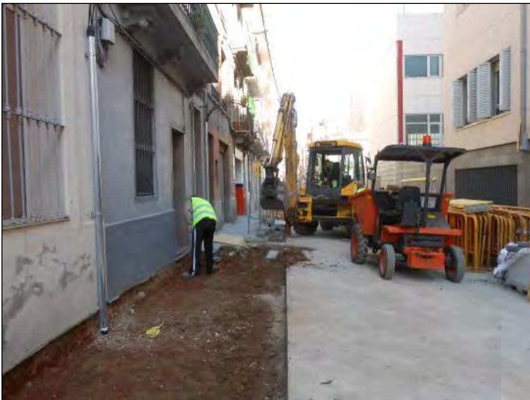
Foto 150: Tram 2. Rebaix del carrer i arrencament de la vorera.
