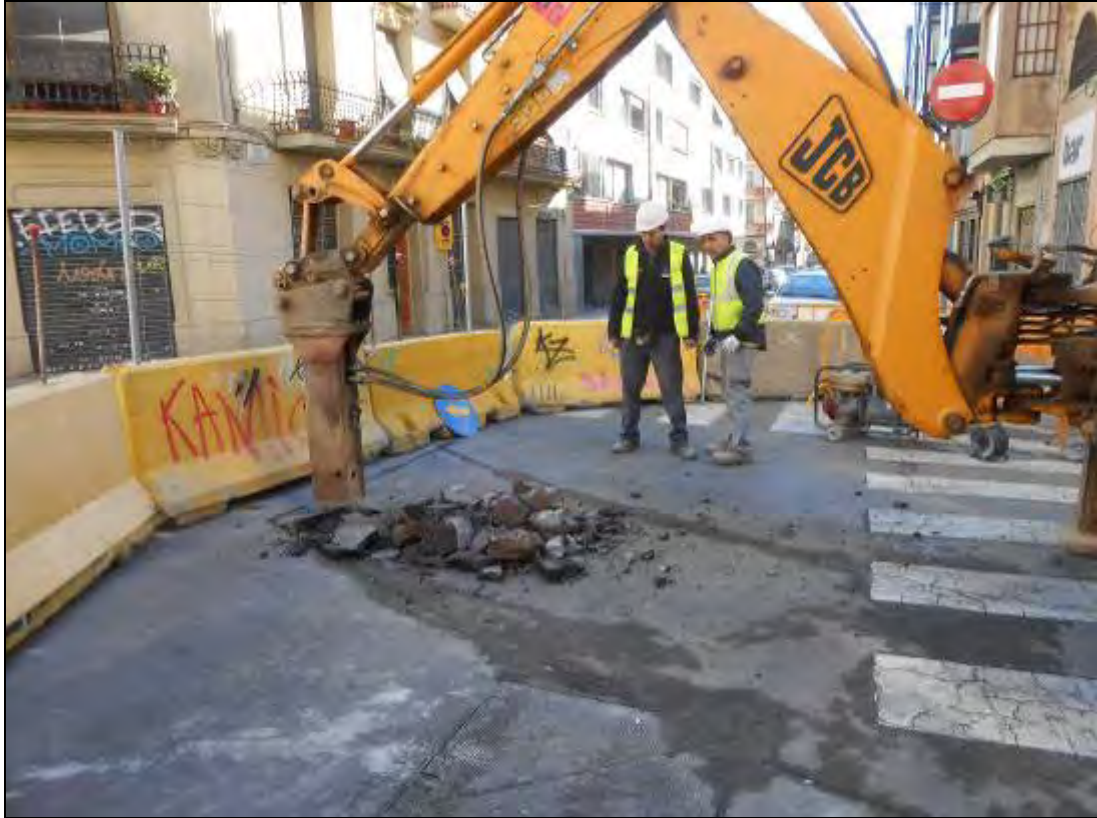
Foto 2: Tram 1. Inici de les obres al carrer del Ripollès amb el carrer Muntanya. Rasa per a col·lector.
