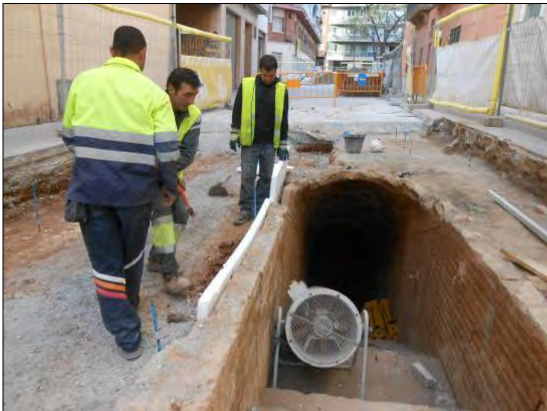
Foto 81: Tram 1. Es posa porexpan a les parets del refugi per a posar la malla de ferro.
