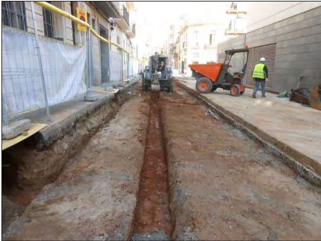
Foto 143: Tram 2. Rasa per al regadiu dels arbres.
