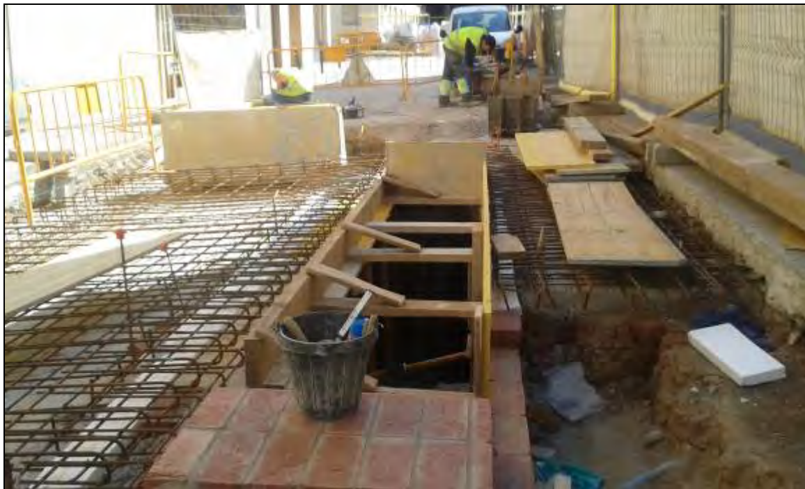
Foto 107: Procés de l'obra.
