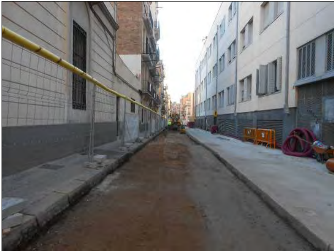
Foto 133: Tram 2. Vista de les obres.
