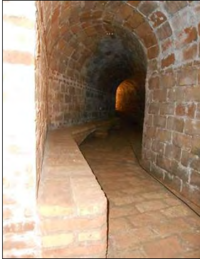
Foto 330: Tram del passadís amb el banc 6 després d'haver estat netejat.
