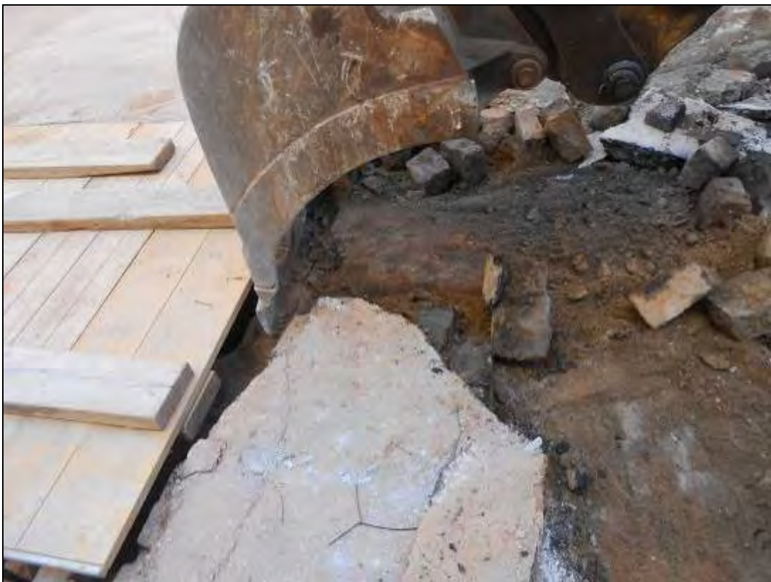
Foto 67: Tram 1. Rebaix del carrer al costat del refugi.
