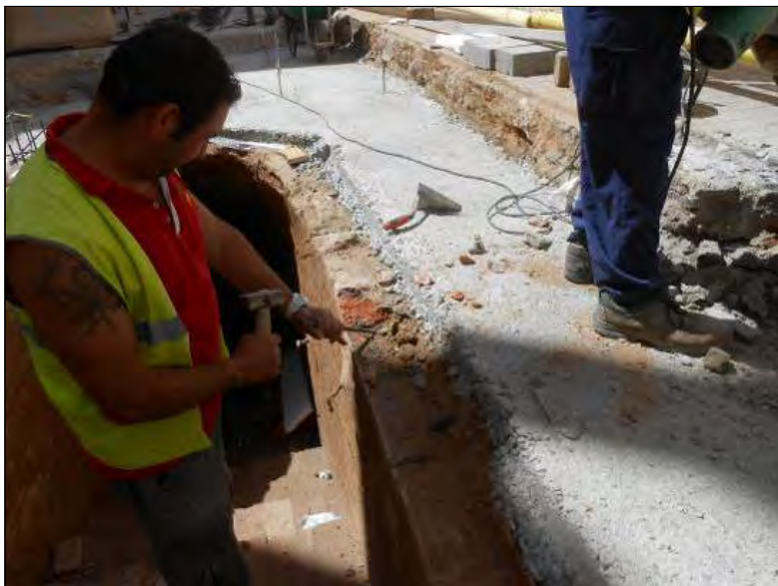
Foto 91: Tram 1. Es treu una filada de totxos de la paret del refugi.
