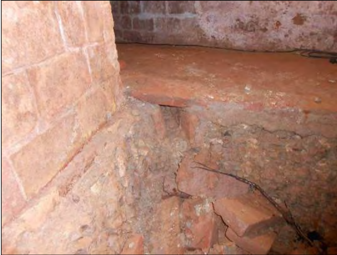
Foto 358: Canaleta a ramal 4. Amb el retall UE: 102.
