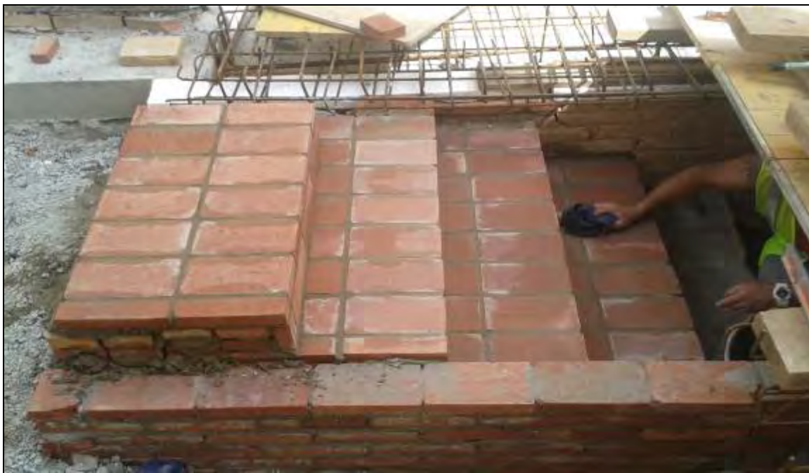
Foto 101: Tram 1. Construcció d'escales per a l'accés al refugi.
