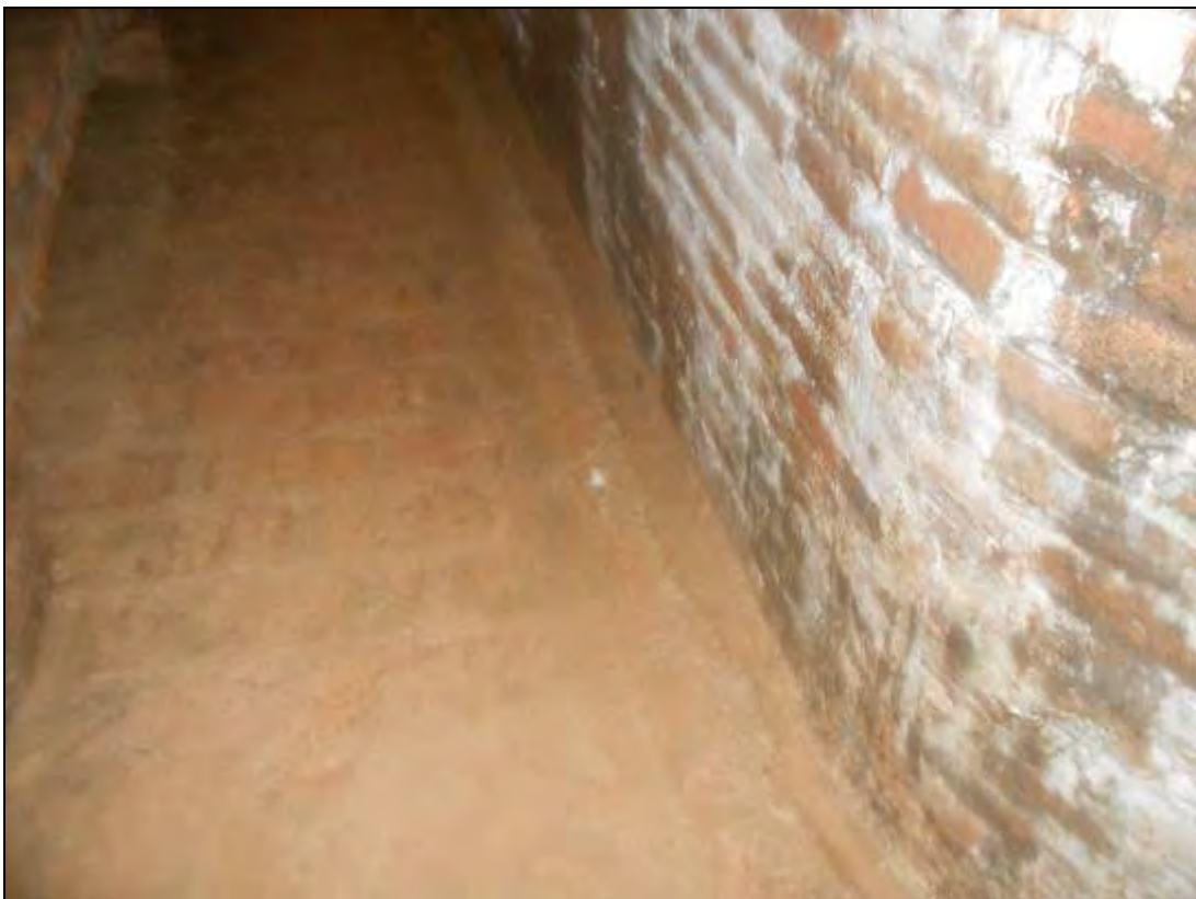
Foto 375: Detall del canaló de morter per a reconduir l'aigua.
