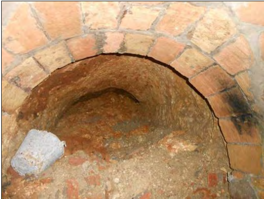
Foto 350: Obertura a la paret de la dreta del ramal 4
