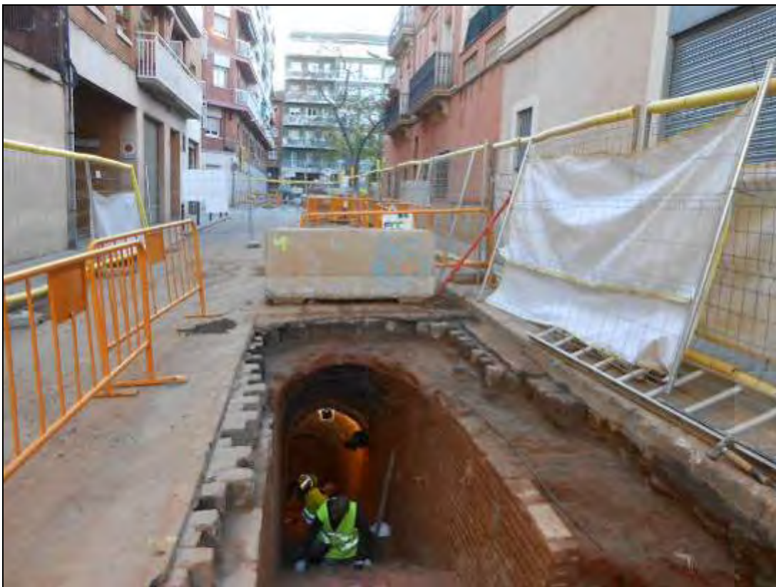
Foto 239: Vista del carrer del Ripollès amb els treballs arqueològics.
