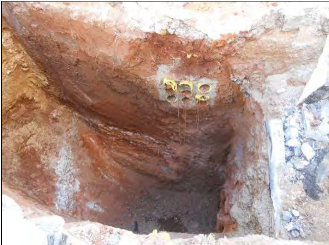
Foto 8: Tram 1. Rasa per al col·lector. A la paret es poden veure els tubs de serveis.
