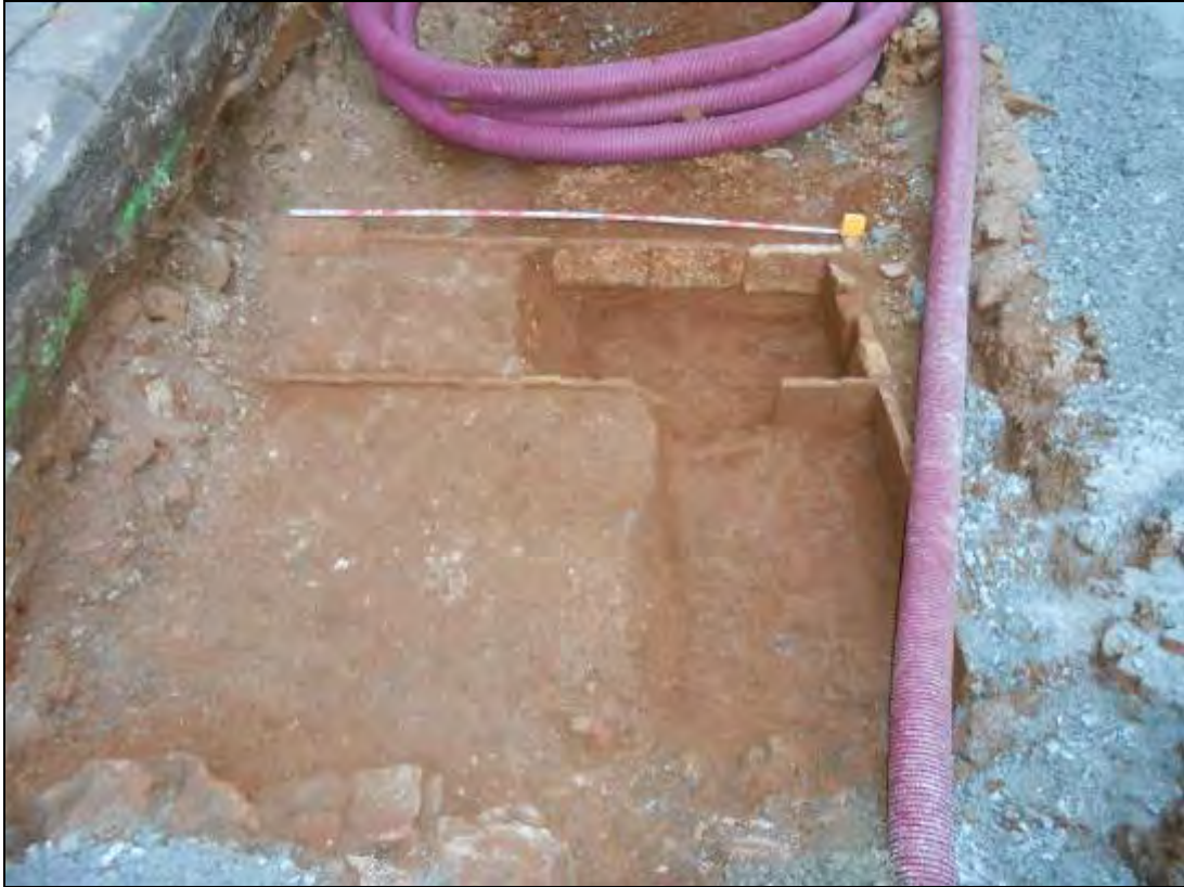
Foto 205: Tram 4. Vista del sondeig efectuat a l'estructura indeterminada (UE: 200).
