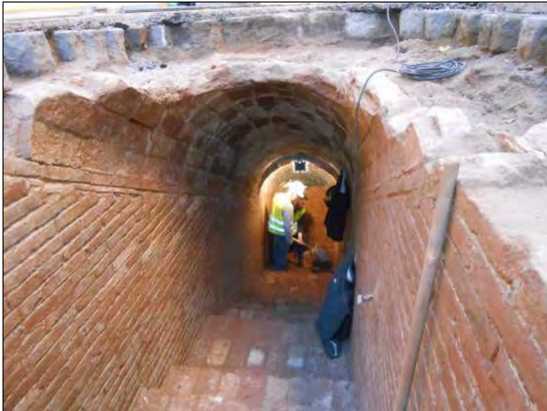
Foto 236: Netejant el tram final del refugi.
