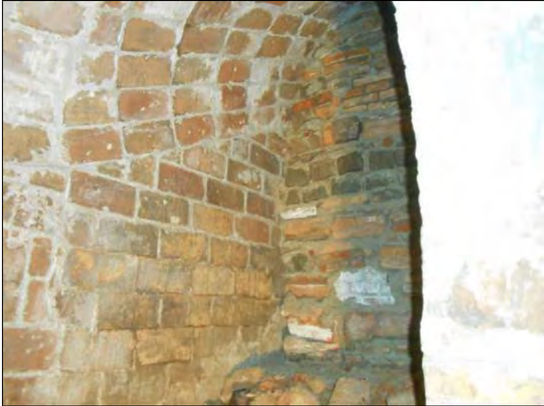
Foto 378: Accés tapiat al tram final.
