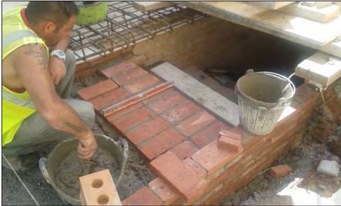
Foto 100: Tram 1. Construcció d'escales per a l'accés al refugi.
