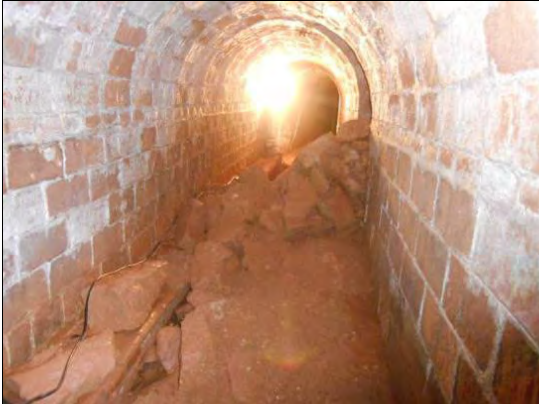
Foto 311: Tram del refugi amb el banc 4. Es pot veure la gran acumulació de runa provinent del pou d'accés o de ventilació. Foto feta des de l'entrada.
