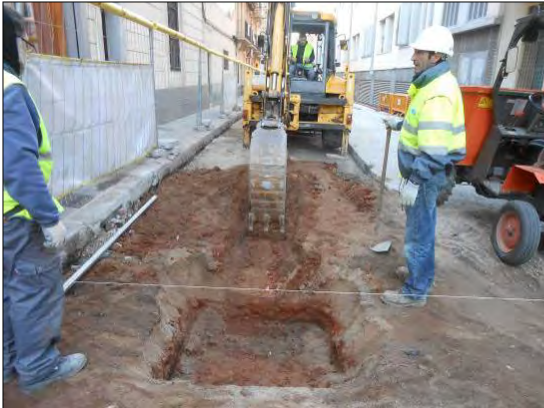
Foto 135: Tram 2. Rasa per als arbres i per al seu regadiu.
