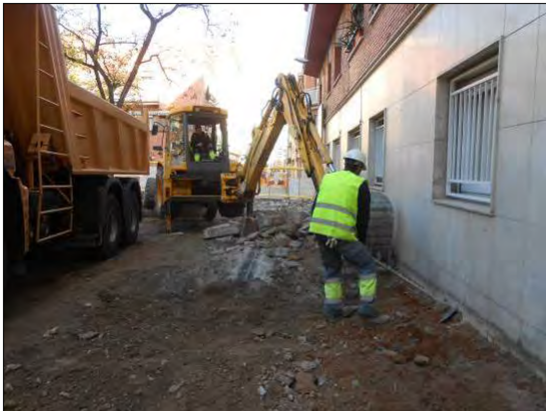
Foto: 172: Tram 3. Aixecament del paviment.
