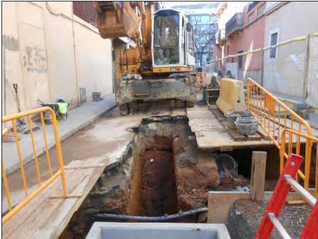
Foto 48: Tram 1. Desviació del col·lector per a no afectar al refugi.
