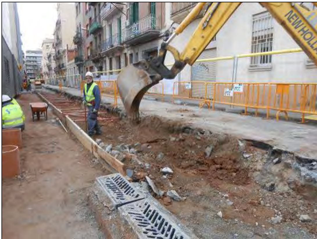
Foto 130: Tram 2. Rebaixant el paviment.
