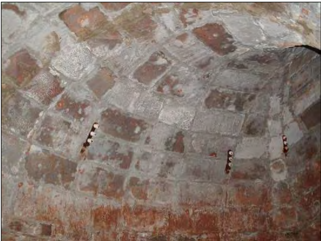
Foto 281: Detall dels aïllants per als cables de la llum.
