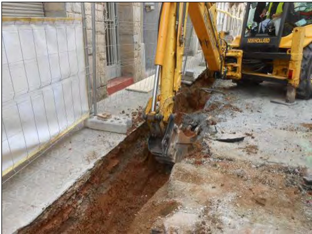
Foto 196: Tram 4. Rasa per a subministrament elèctric.
