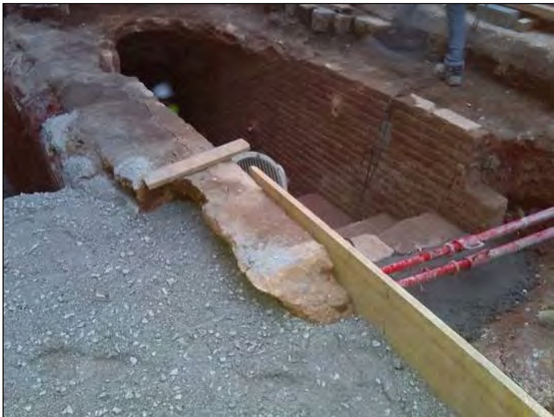
Foto 59: Tram 1. Procés de l'obra.
