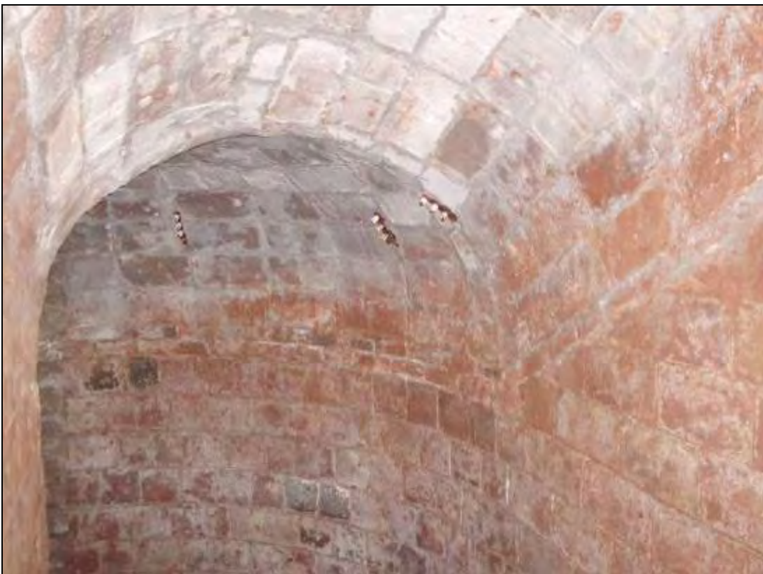
Foto 277: Detall de la volta amb els aïllants del cablejat elèctric.
