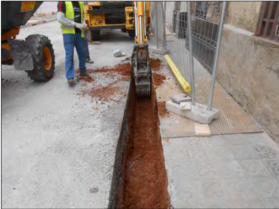
Foto 195: Tram 4. Rasa per a subministrament elèctric.
