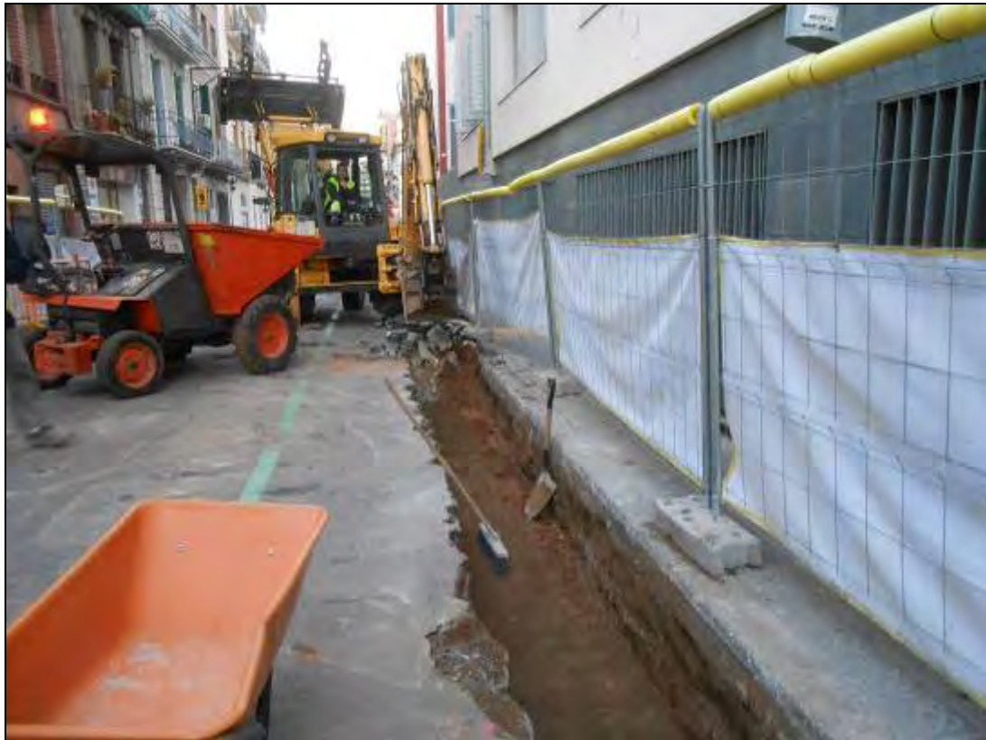
Foto 125: Tram 2. Rasa per a embornal. De 0,80 m d'ample i 0,70 m de profunditat.
