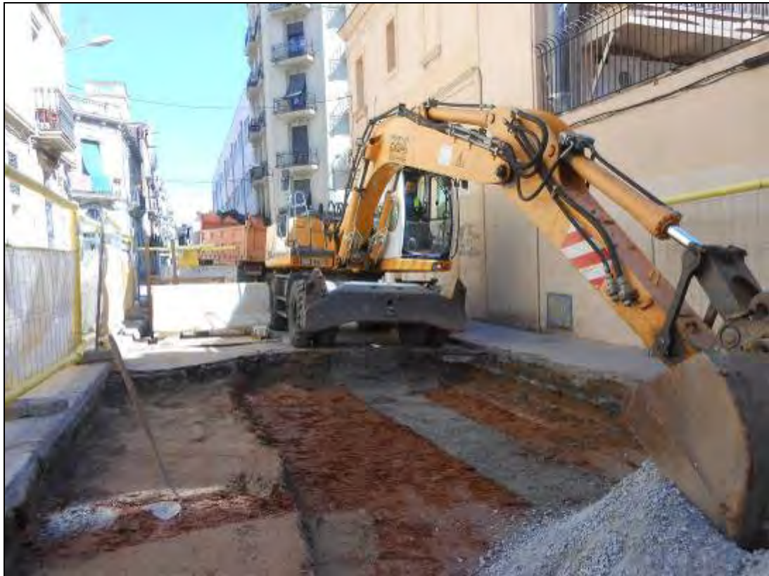
Foto 64: Tram 1. Rebaix del terreny al costat del refugi.
