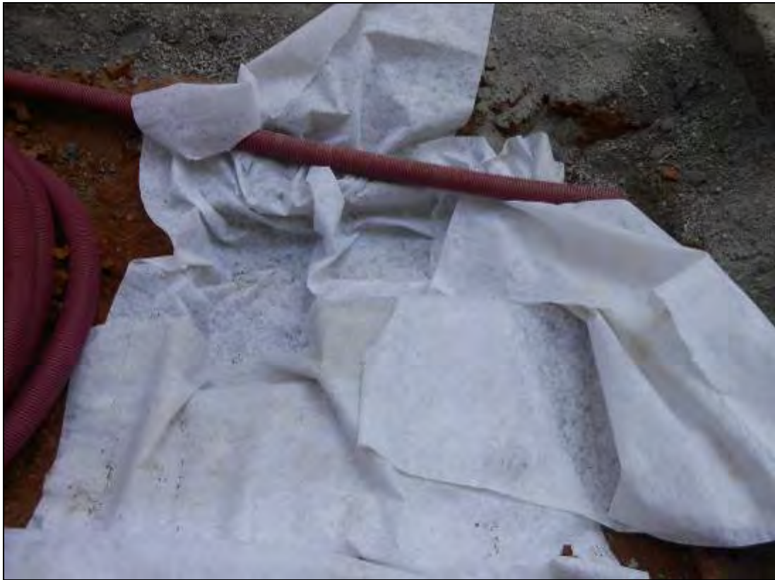
Foto 209: Tram 4. Estructura (UE: 200) coberta amb la tela geotèxtil.
