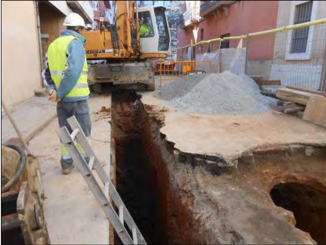
Foto 54: Tram 1. Rasa per al col·lector al costat del refugi.
