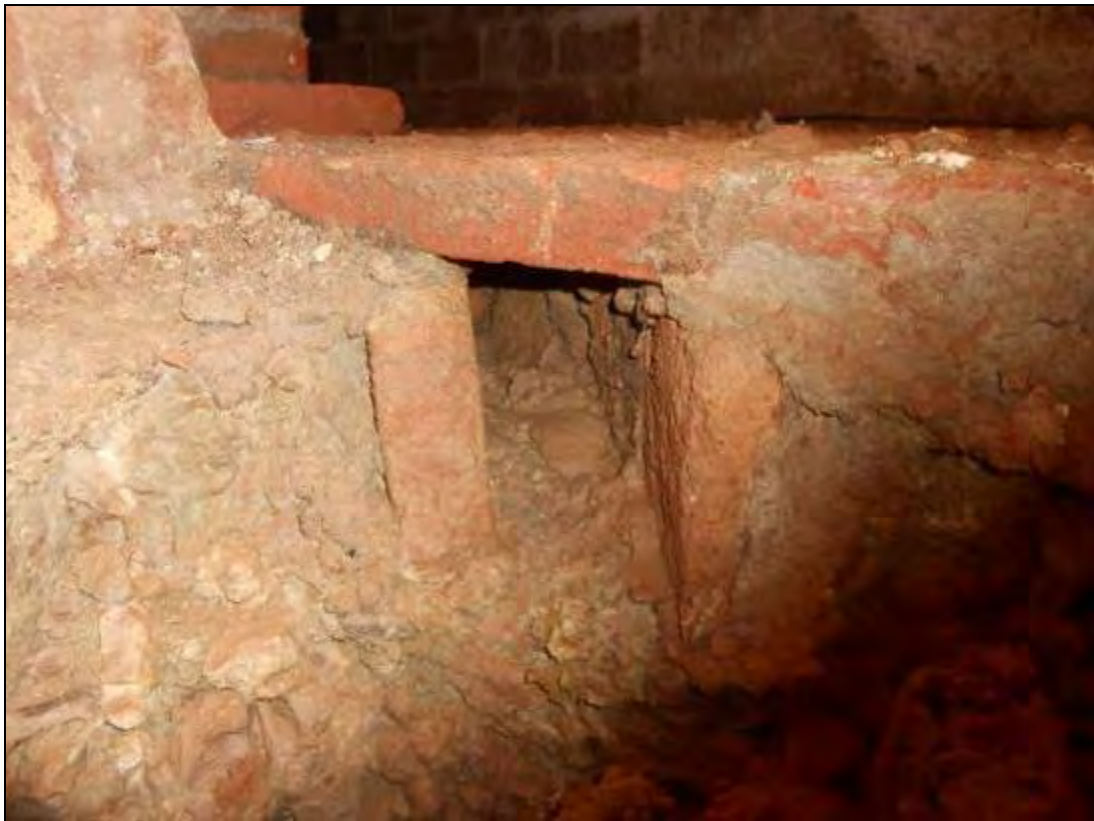
Foto 359: Canaleta a ramal 4.
