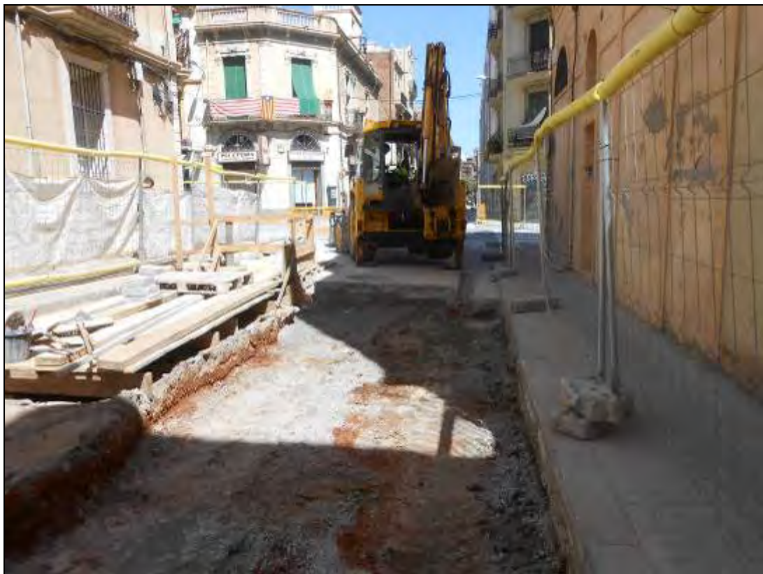
Foto 71: Tram 1. Rebaix del carrer al costat del refugi.
