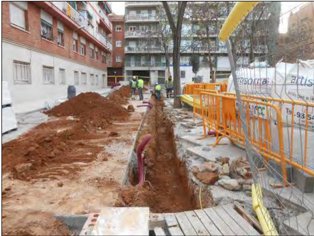
Foto 175: Tram 3. Rasa per a serveis.
