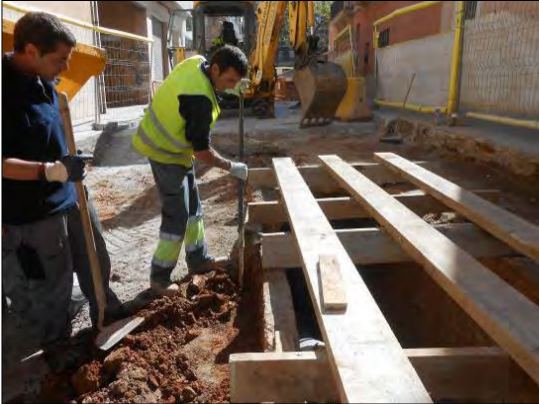
Foto 76: Tram 1. Rebaix del carrer al costat del refugi.
