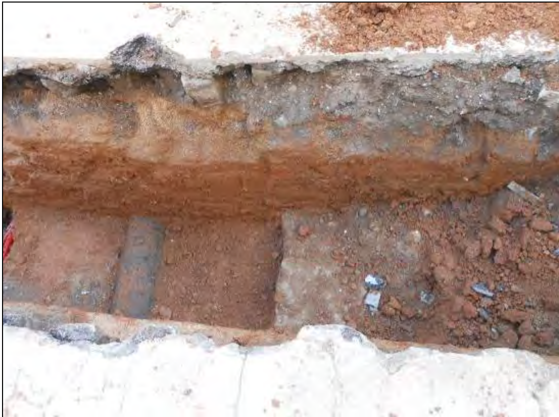
Foto 16: Tram 1. Rasa per al col·lector. Serveis.
