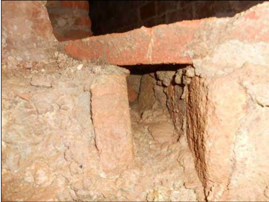
Foto 360: Canalització a ramal 4.
