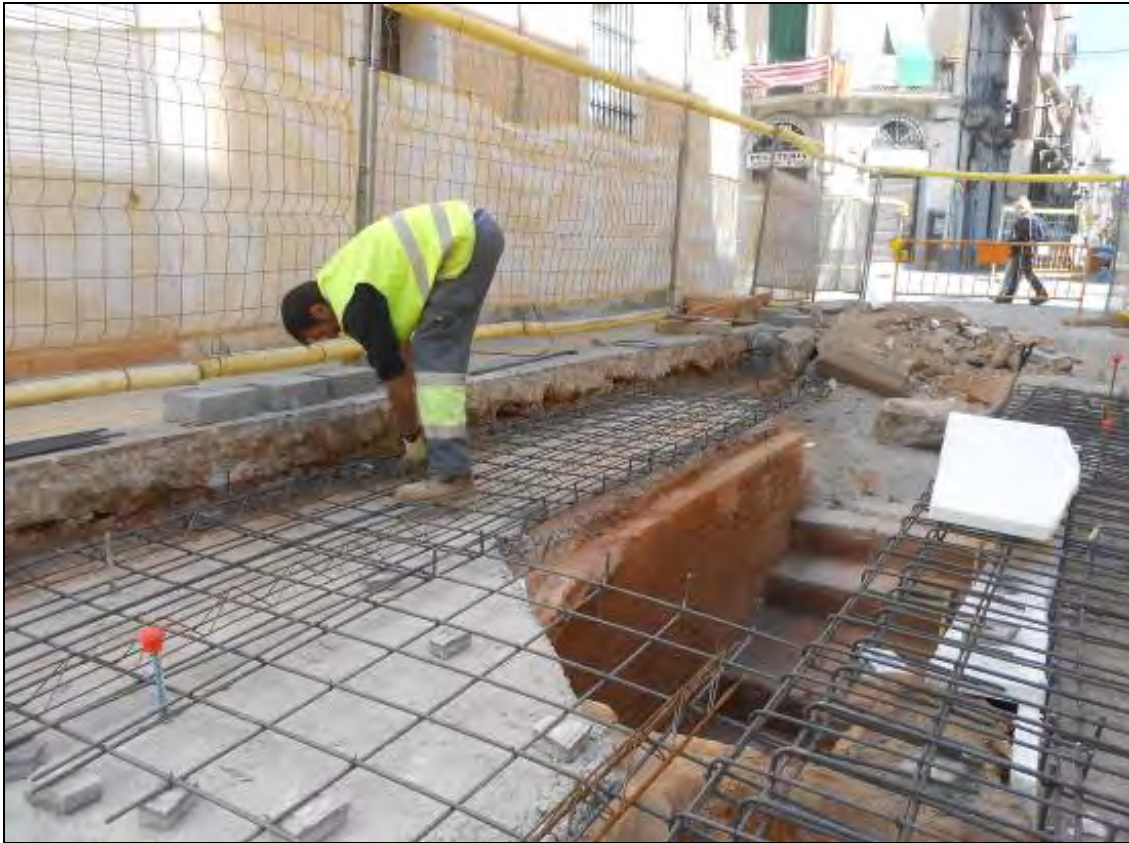
Foto 108: Tram 1. Encofrant per a formigonar.
