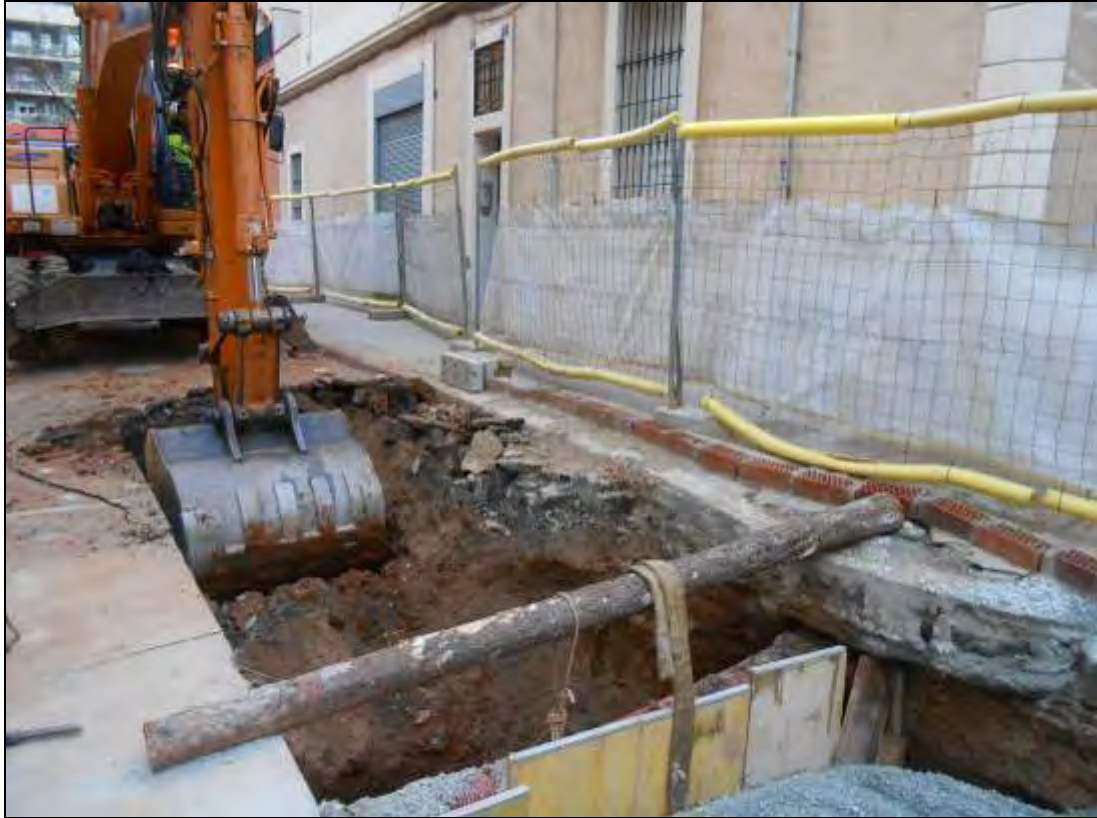
Foto 24: Tram 1. Rasa per a col·lector.
