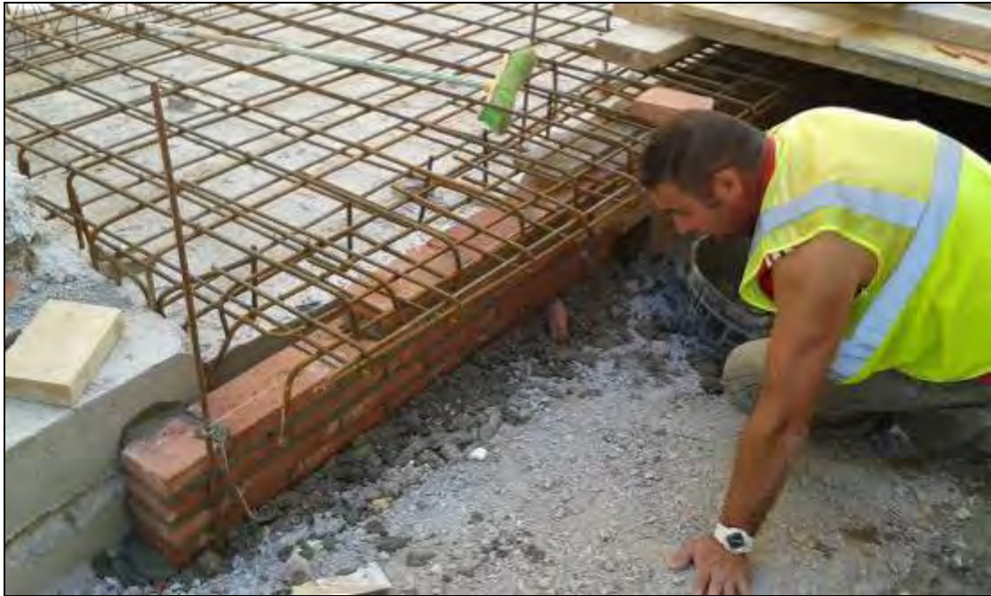
Foto 96: Tram 1: Construcció d'escales per a l'accés al refugi.
