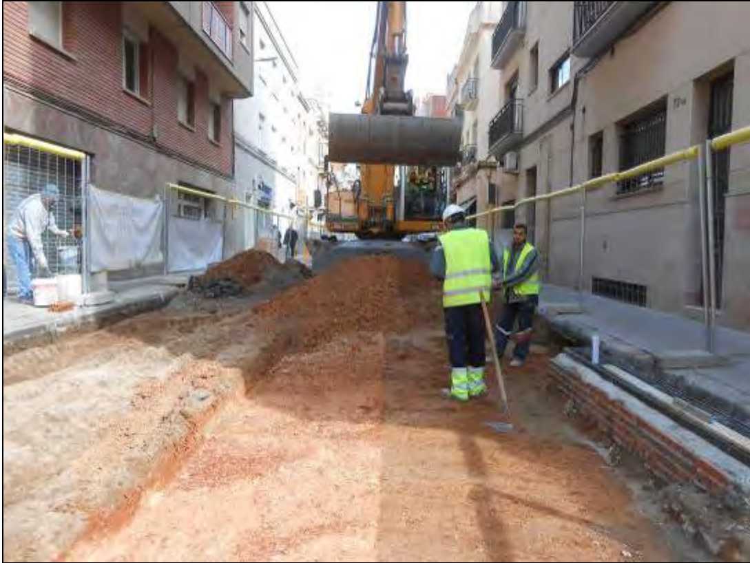
Foto 193: Tram 4. Procés de l'obra. Rebaix del carrer. Es pot apreciar la rasa del col·lector existent.
