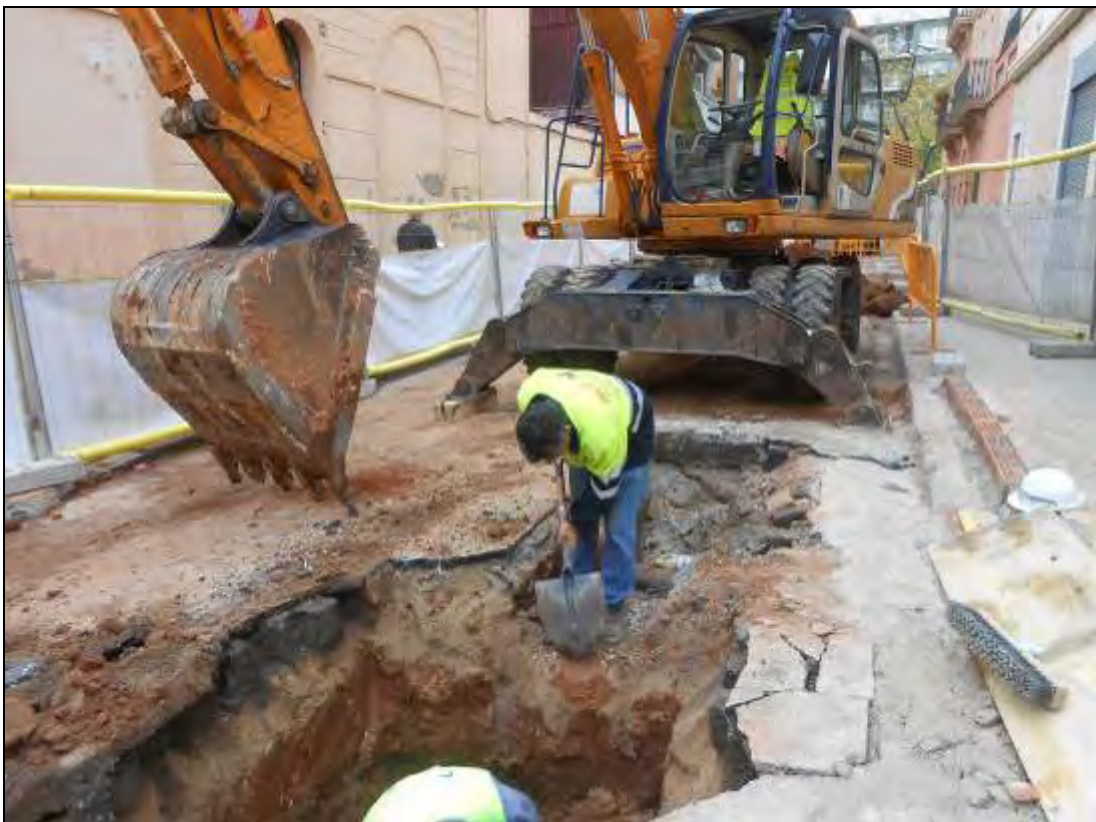
Foto 21: Tram 1. Rasa per al col·lector.
