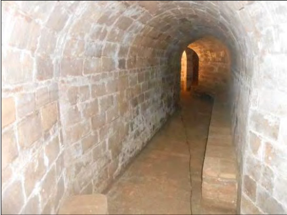
Foto 364: Tram de passadís del banc 8 després d'haver-se netejat. Foto feta en direcció a l'entrada del refugi.
