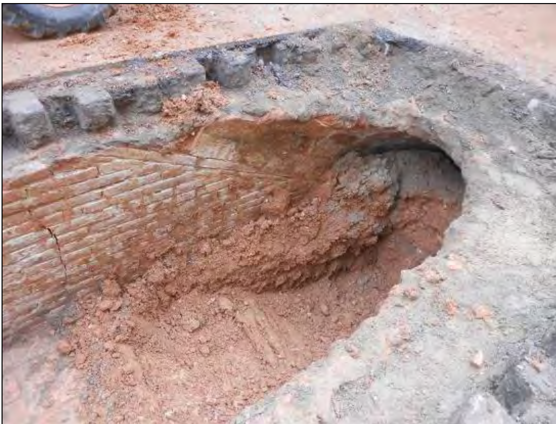
Foto 231: Treballs d'extracció de la terra de l'accés al refugi.
