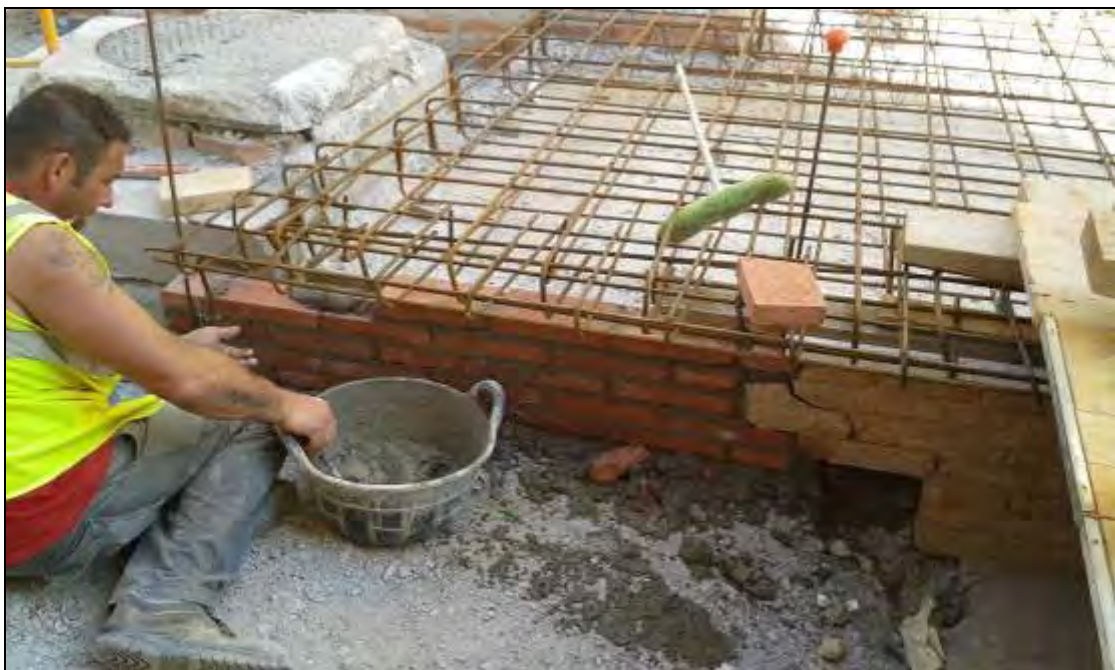
Foto 97: Tram 1: Construcció d'escales per a l'accés al refugi.
