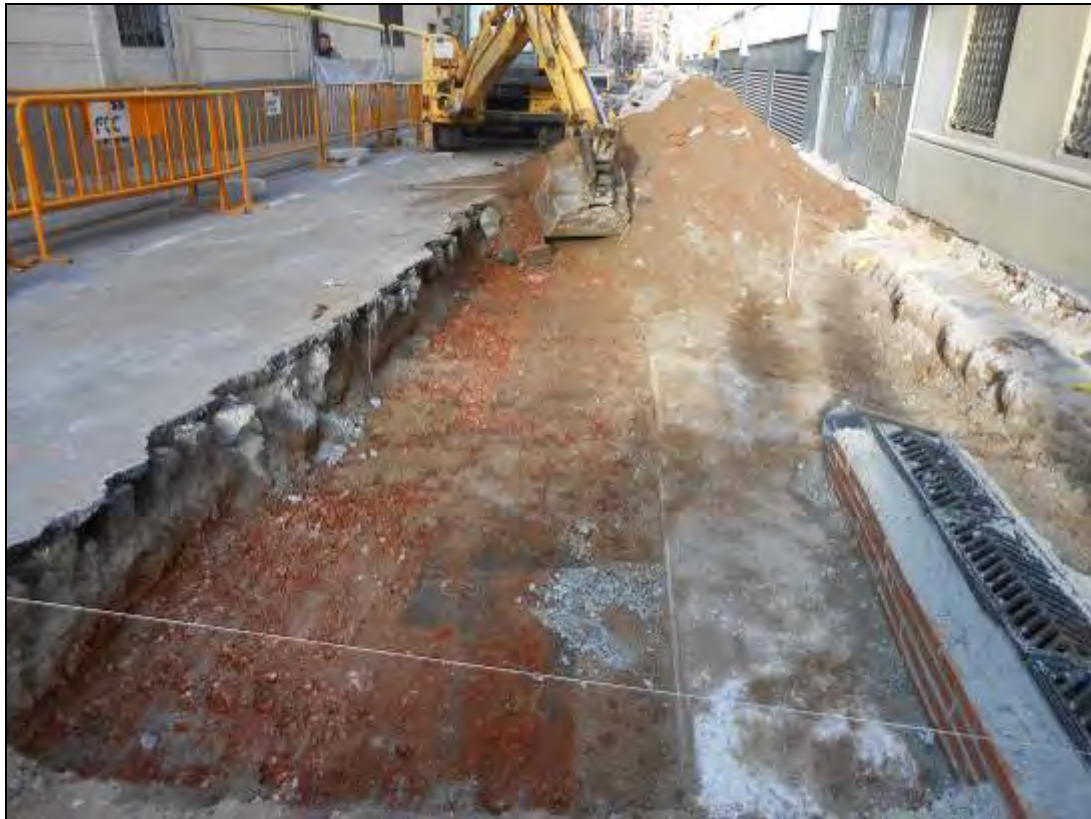
Foto 127: Tram 2. Rebaix del carrer. Es veu la rasa del col·lector.
