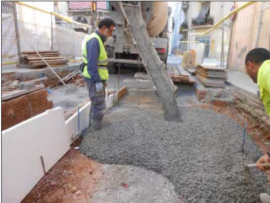
Foto 84: Tram 1. Procés de l'obra.
