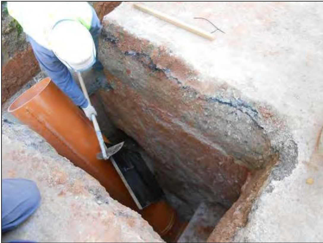
Foto 165: Tram 3. Es col·loca un tauló per a tapar el forat de la galeria.
