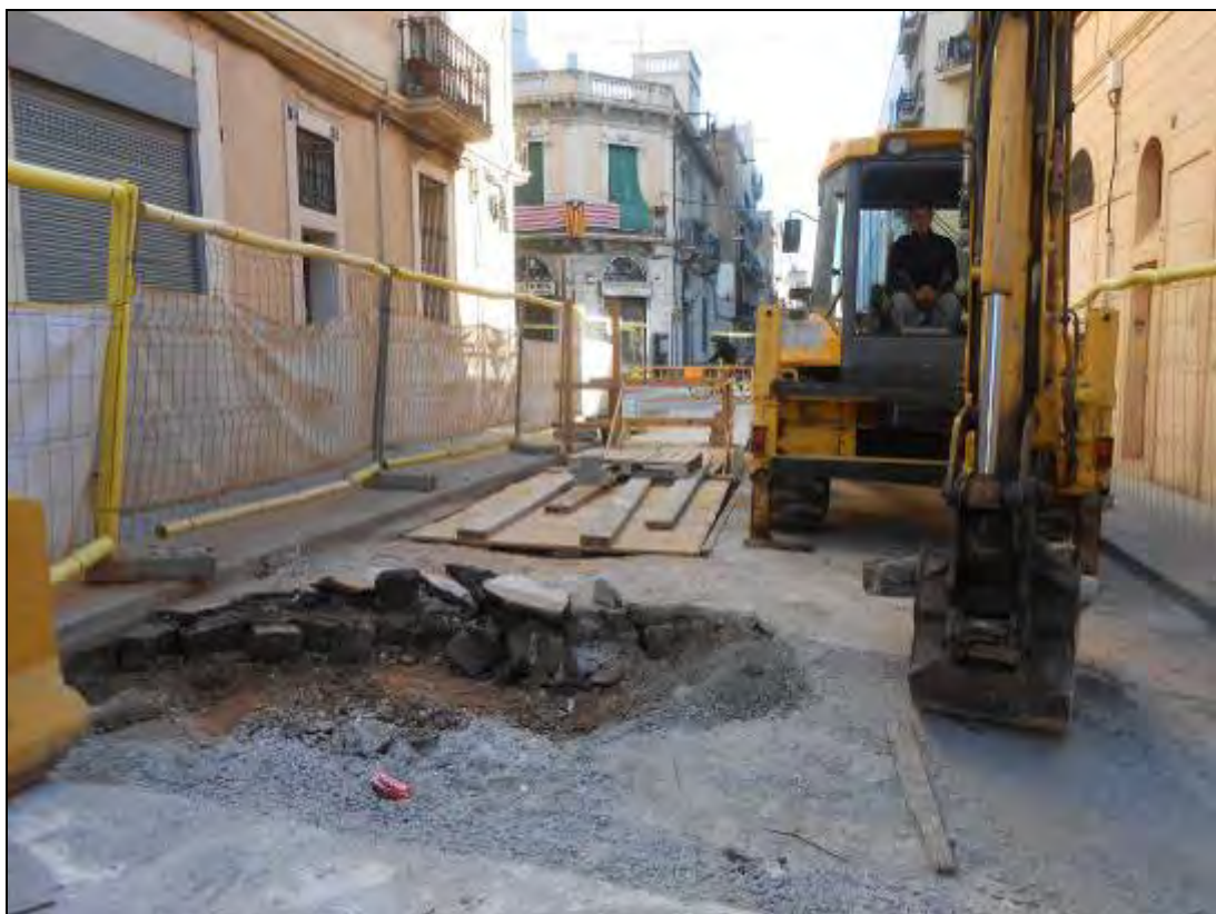
Foto 65: Tram 1. Rebaix del carrer al costat del refugi.
