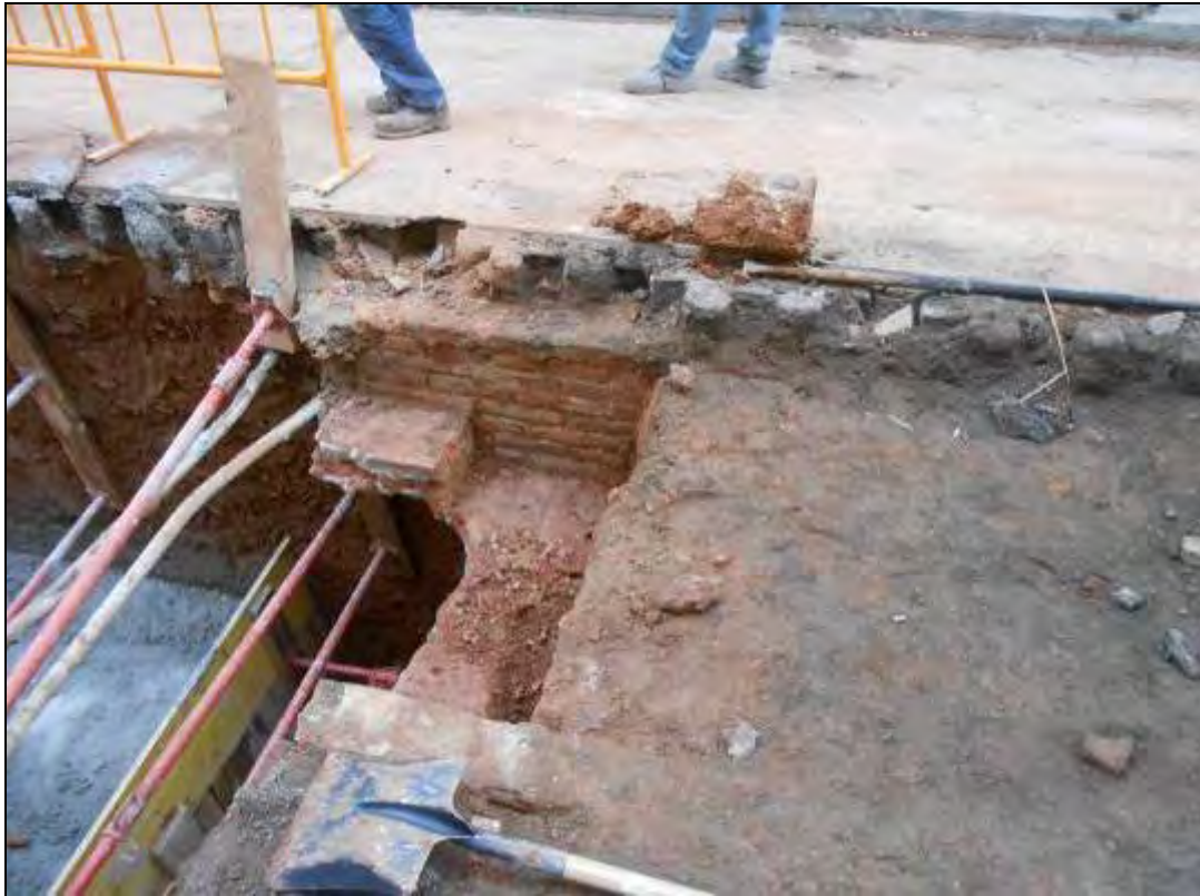
Foto: 222: Es comença a excavar manualment per veure si realment es un refugi.
