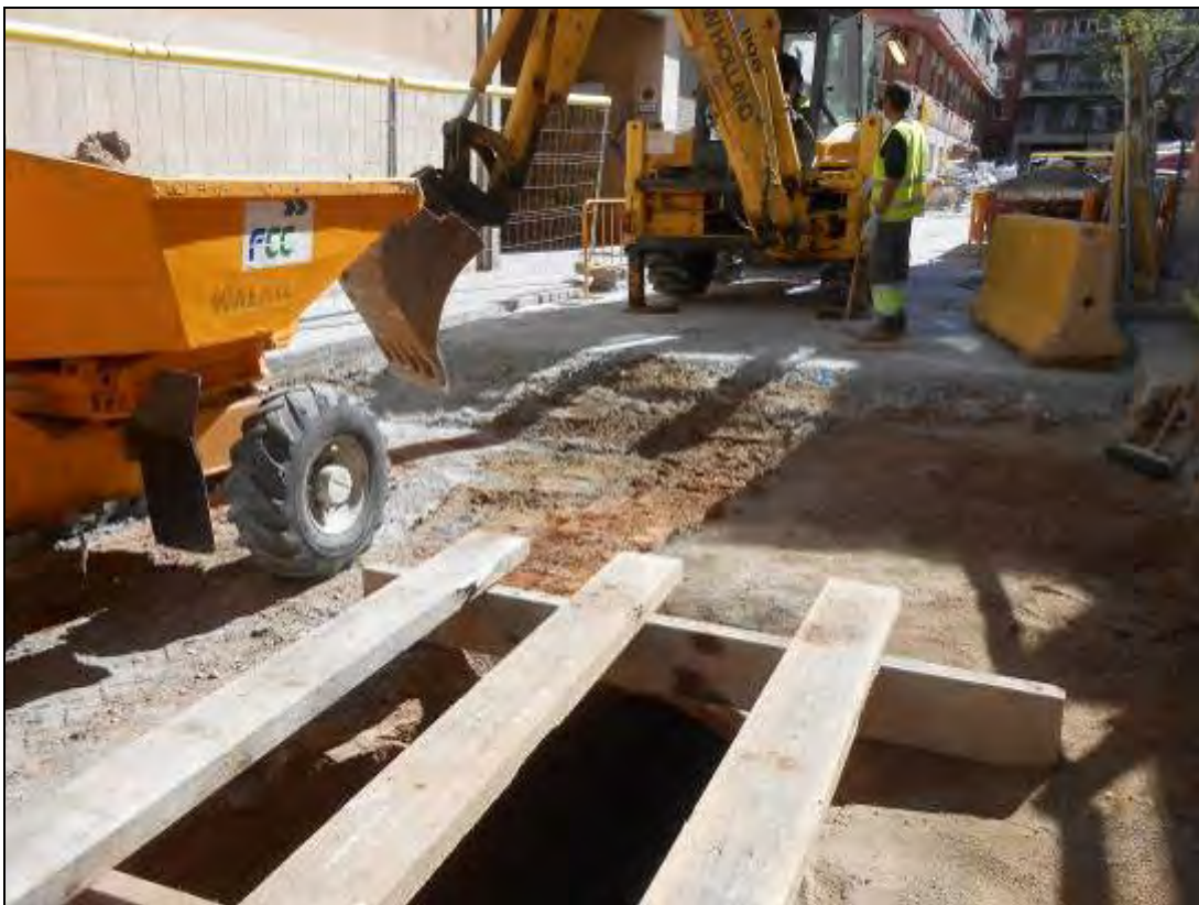
Foto 75: Tram 1. Rebaix del carrer al costat del refugi.
