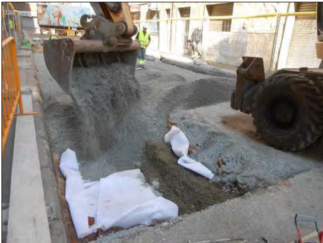
Foto 212: Tram 4. Procés de cobriment de l'estructura indeterminada (UE: 200).
