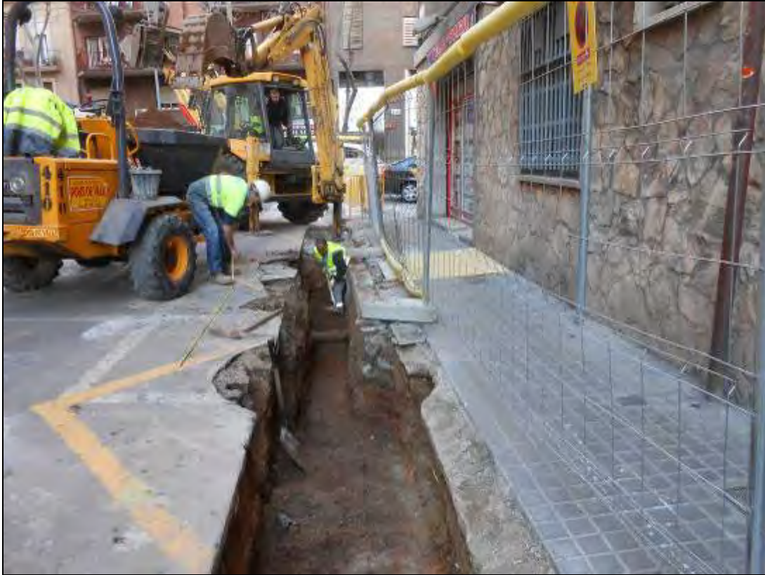
Foto 187: Tram 4. Rasa per a embornal a la cantonada amb Navas de Tolosa.
