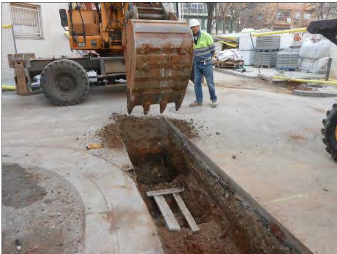
Foto 57: Tram 1. Rasa per al col·lector a la cantonada amb el carrer Pistó.
