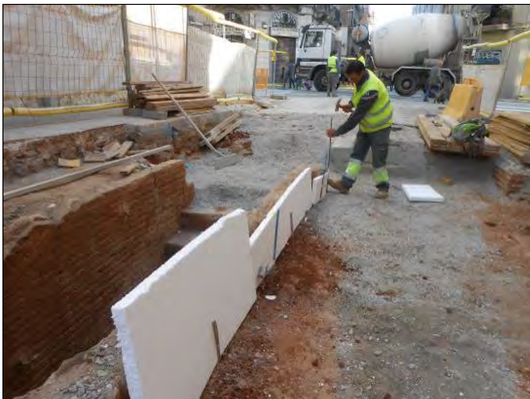
Foto 83: Tram 1. Procés de l'obra.
