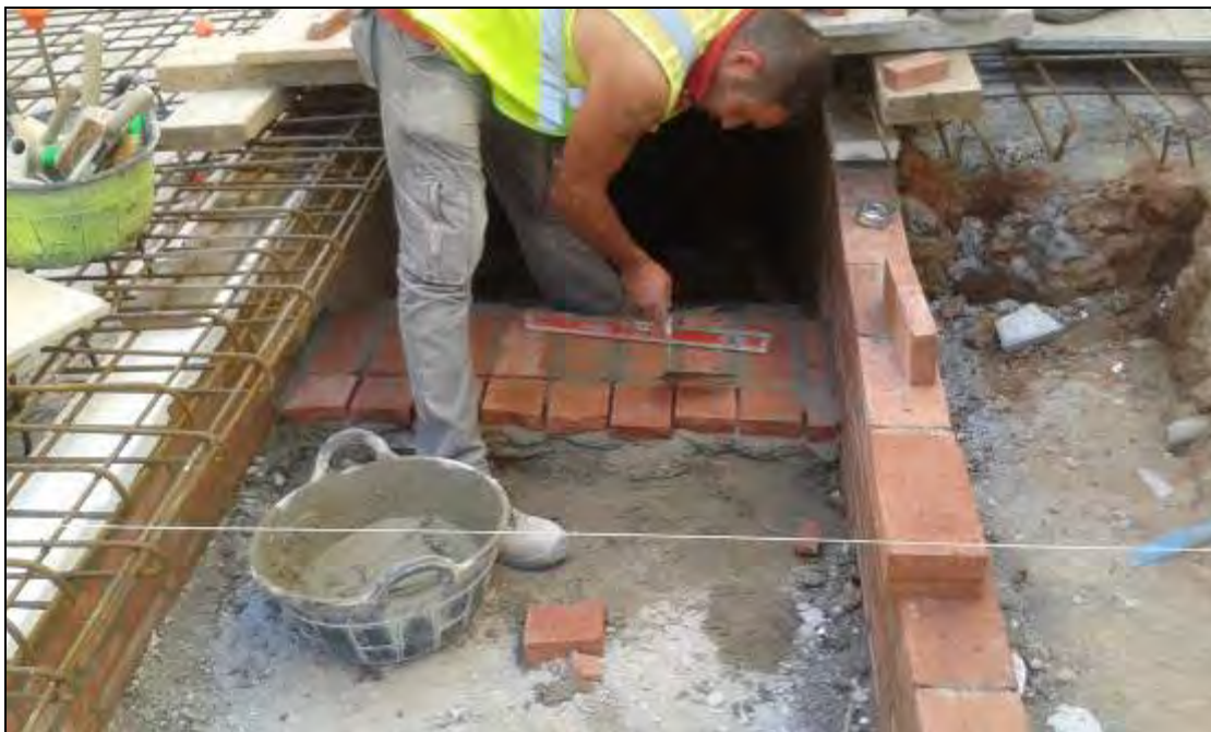
Foto 99: Tram 1. Construcció d'escales per a l'accés al refugi.
