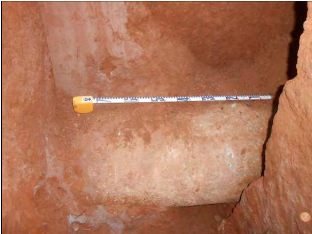
Foto 162: Tram 3. Tub de formigó que travessa la galeria.
