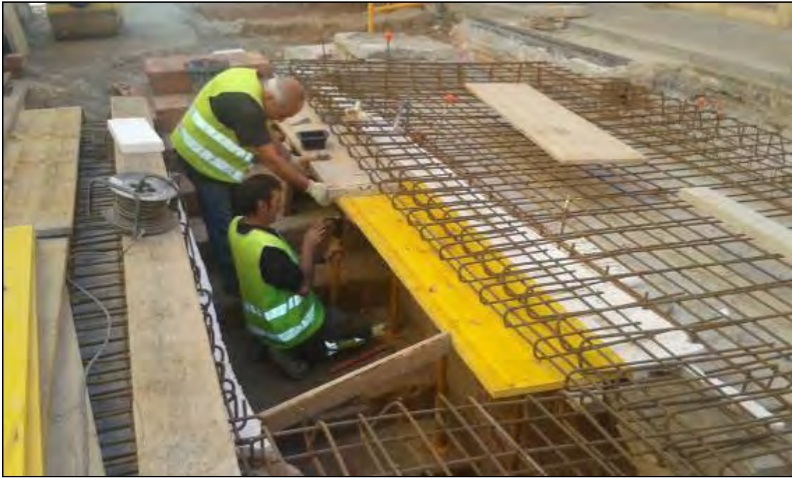
Foto 104: Tram 1. Procés de l'obra. Encofrant per a formigonar.
