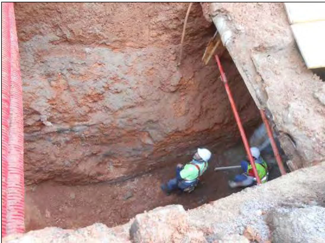
Foto 23: Tram 1. Treballs a la rasa per al col·lector.
