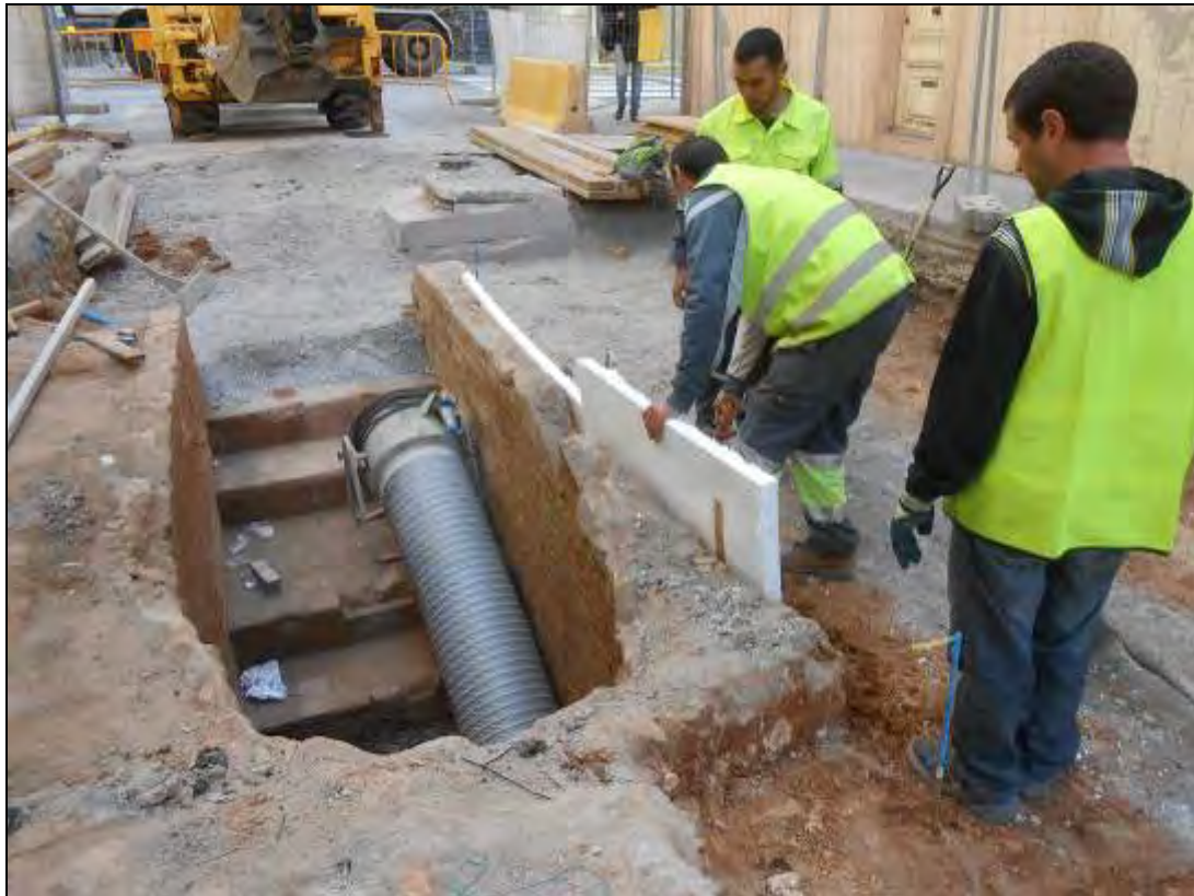
Foto 82: Tram 1. Procés de l'obra.
