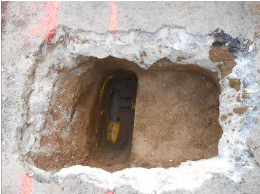
Foto 123: Tram 2. Rasa per a descobrir serveis. Tub de gas.
