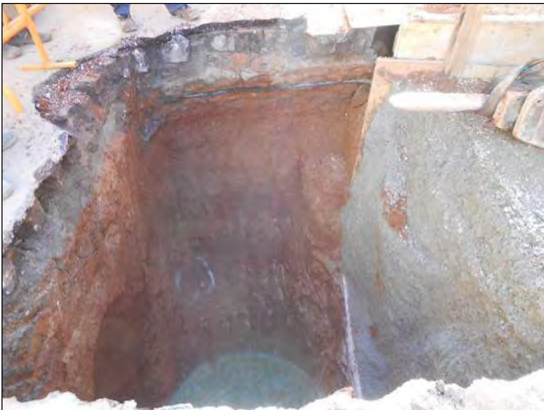
Foto 45: Tram 1. Ampliació del col·lector al costat del refugi.
