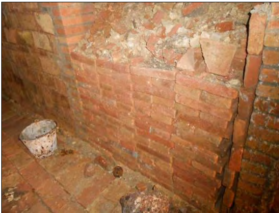
Foto 351: Obertura a la paret de la dreta del ramal 4.
