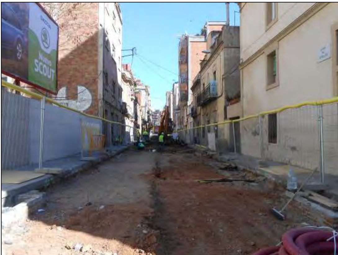
Foto 188: Tram 4. Obres de Rebaix del carrer.
