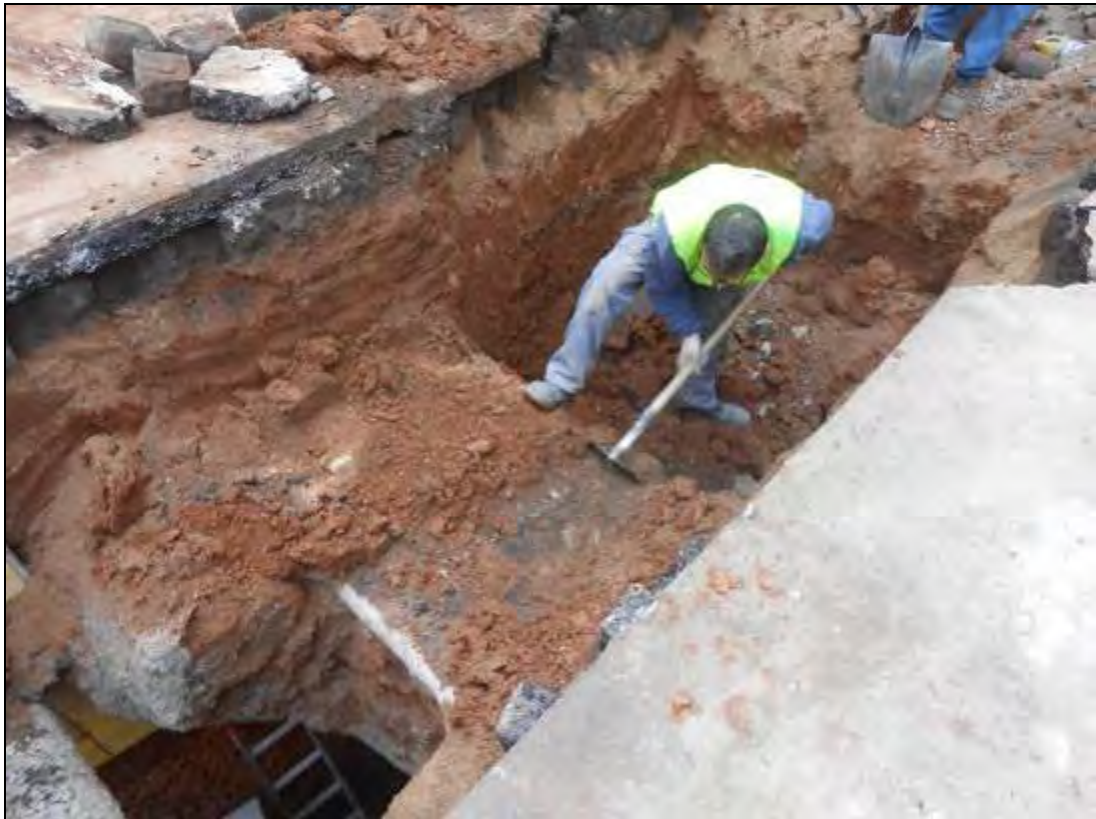
Foto 20: Tram 1. Rasa per al col·lector. Serveis.
