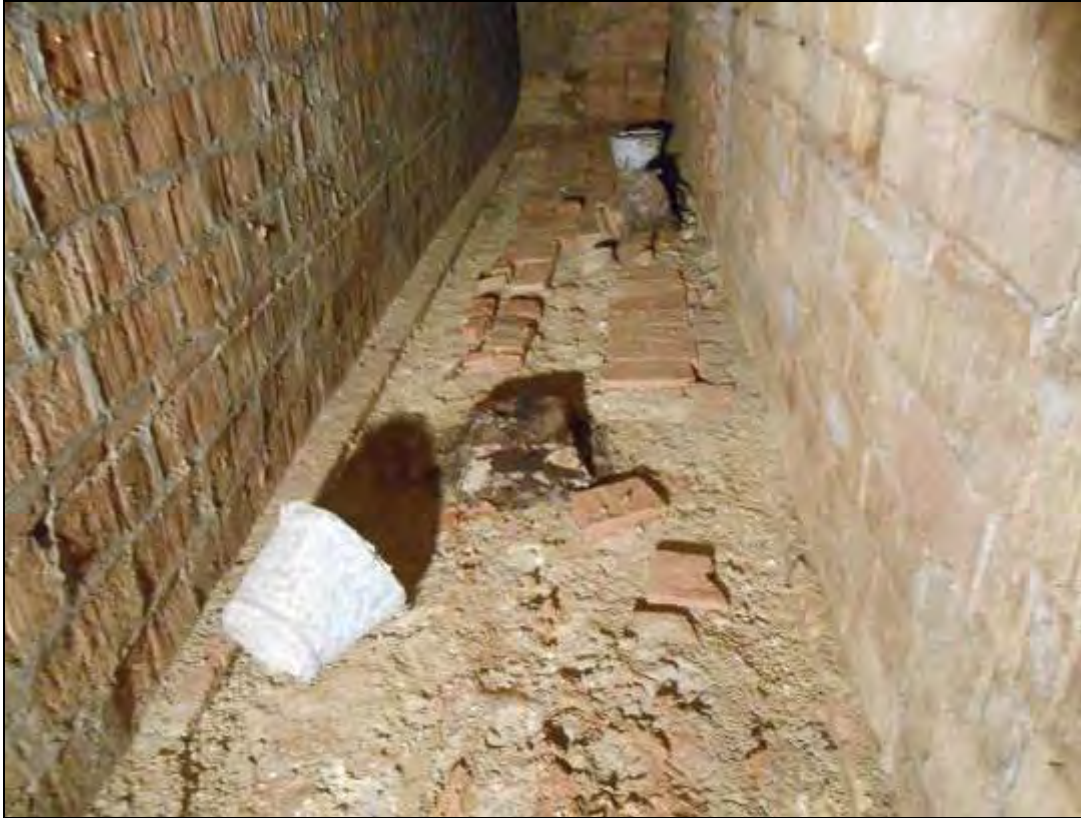
Foto 346: Ramal 4. Detall del terra amb els cubells i gaveta de fusta.
