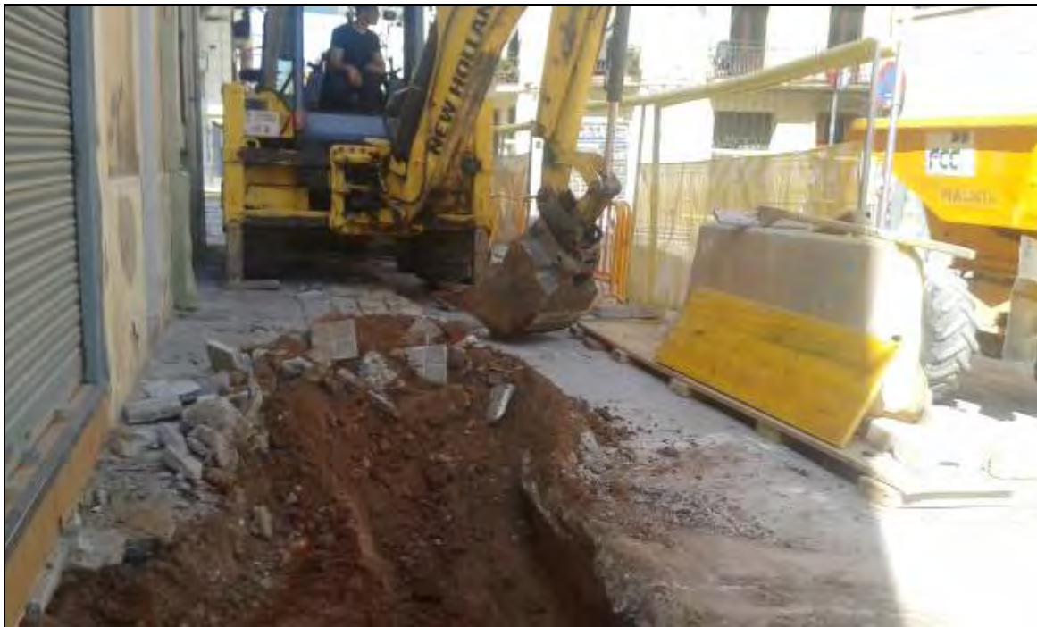
Foto 109: Tram 1. Aixecant vorera del costat del refugi.
