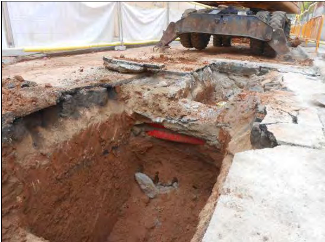
Foto 22: Tram 1. Treballs a la rasa per al col·lector.
