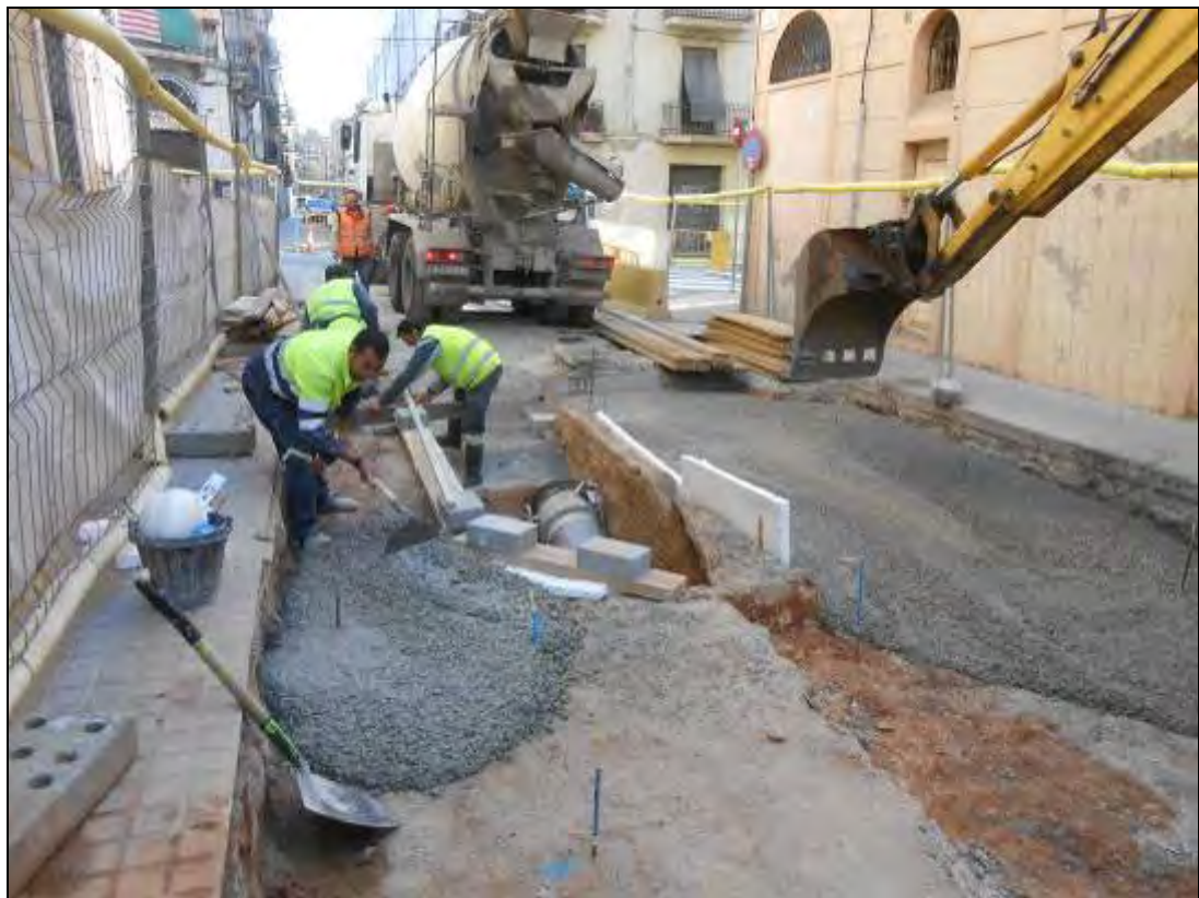
Foto 87: Tram 1. Procés de l'obra.
