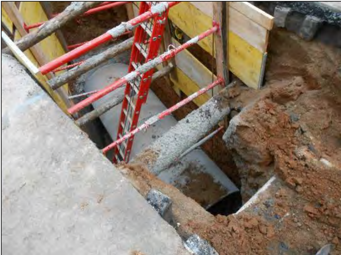
Foto 19: Tram 1. Vista del tram del nou col·lector.
