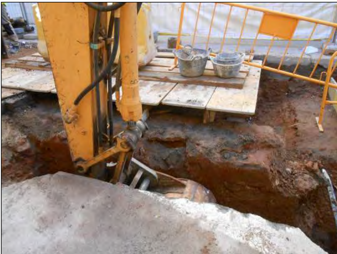
Foto 47: Tram 1. Desviació del col·lector passant pel costat del refugi per a no afectar-lo.
