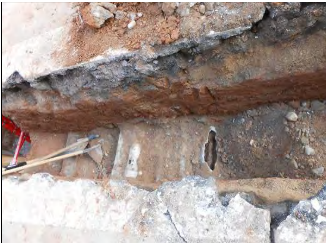
Foto 17: Tram 1. Rasa per al col·lector. Serveis.
