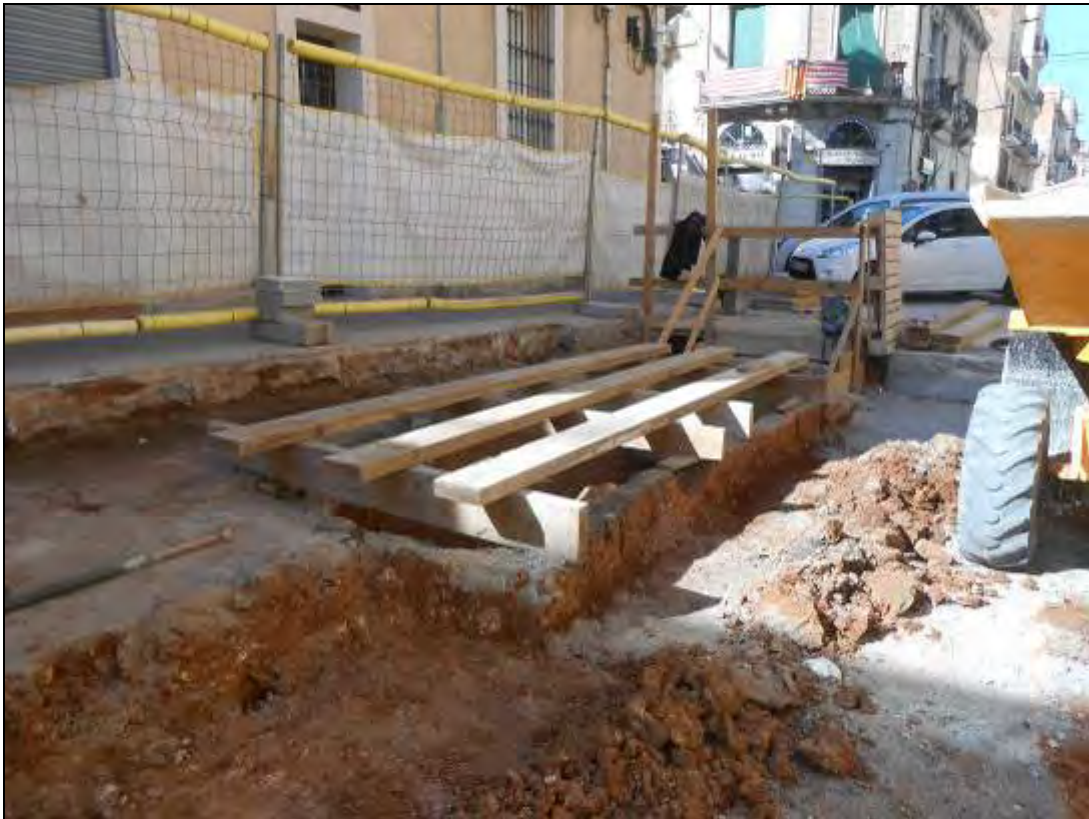
Foto 78: Tram 1. Rebaix del carrer al costat del refugi.
