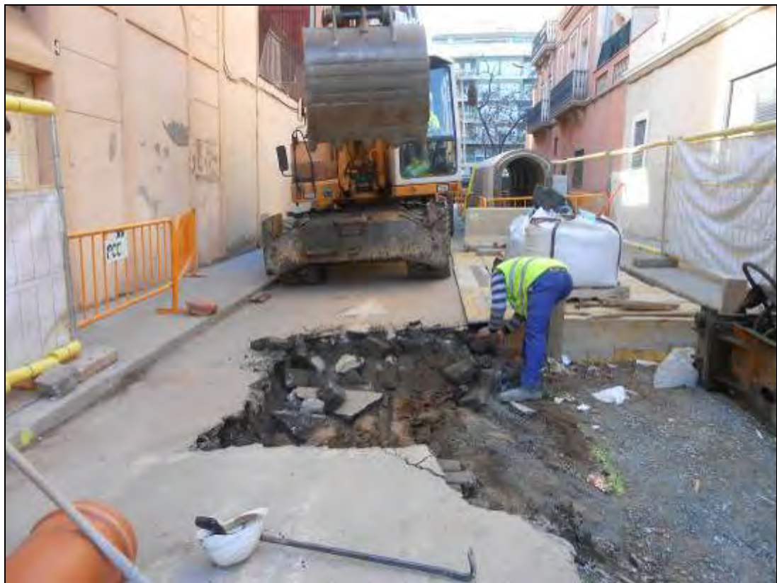
Foto 41: Tram 1. Ampliació del col·lector al costat del refugi.
