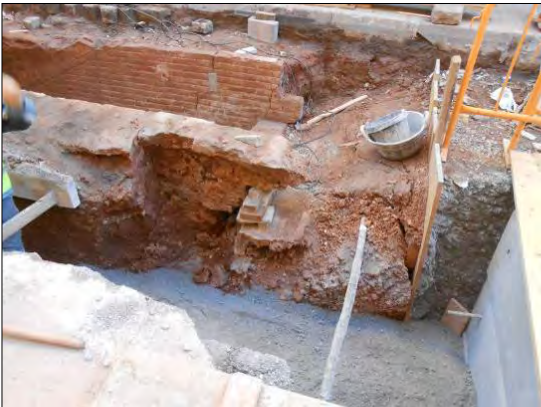
Foto 51: Tram 1. Vista de la rasa per a l'embornal al costa del refugi.
