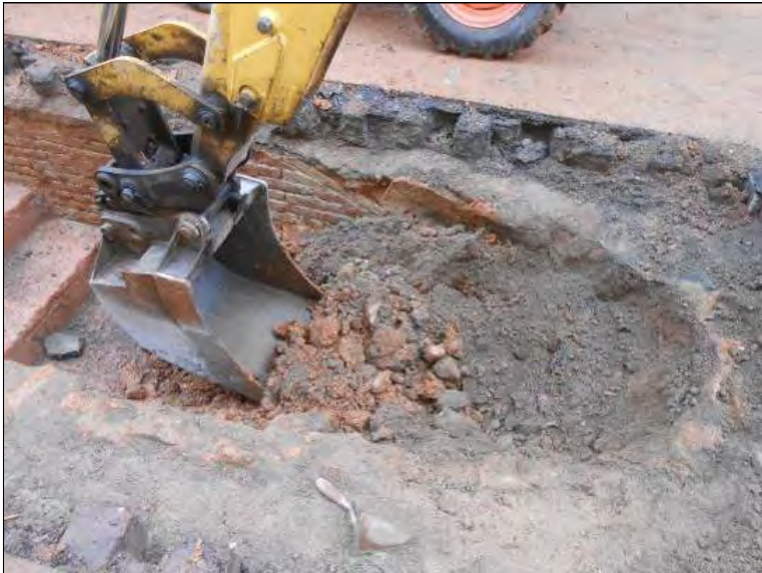
Foto 34: Tram 1. Excavant l'accés al refugi.
