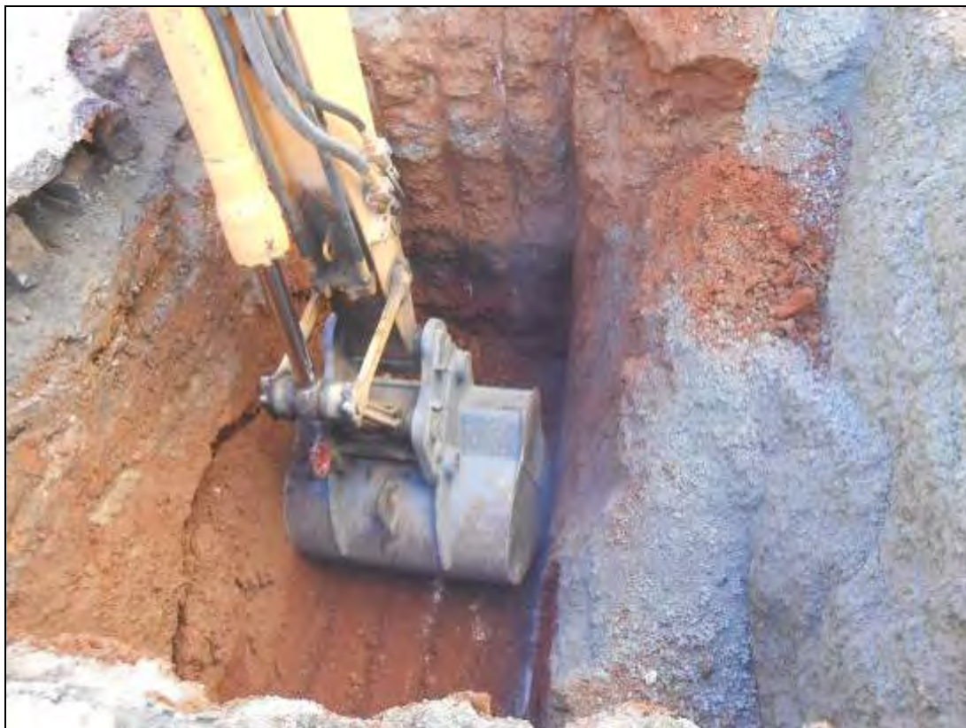
Foto 43: Tram 1. Ampliació del col·lector al costat del refugi.
