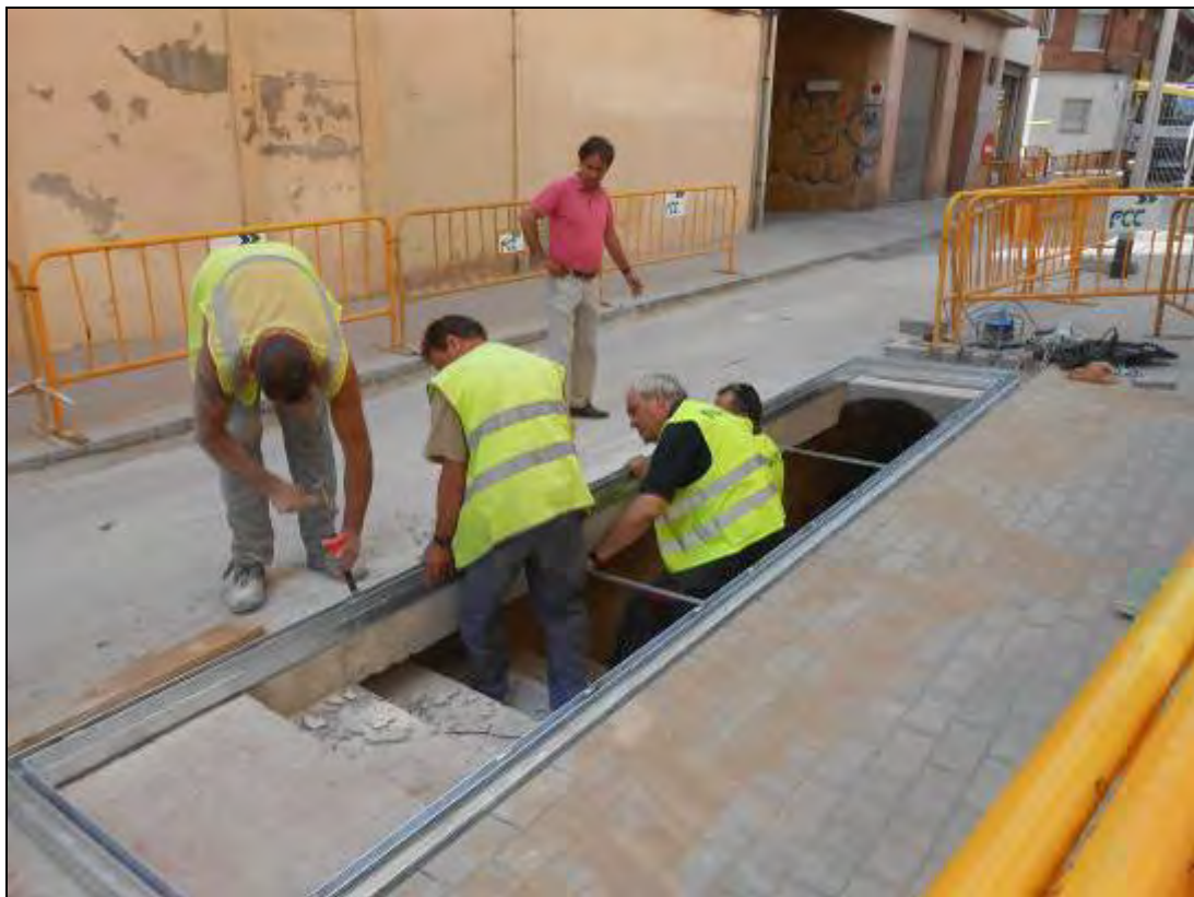
Foto 111: Tram 1. Es posa la tapa definitiva per al refugi.
