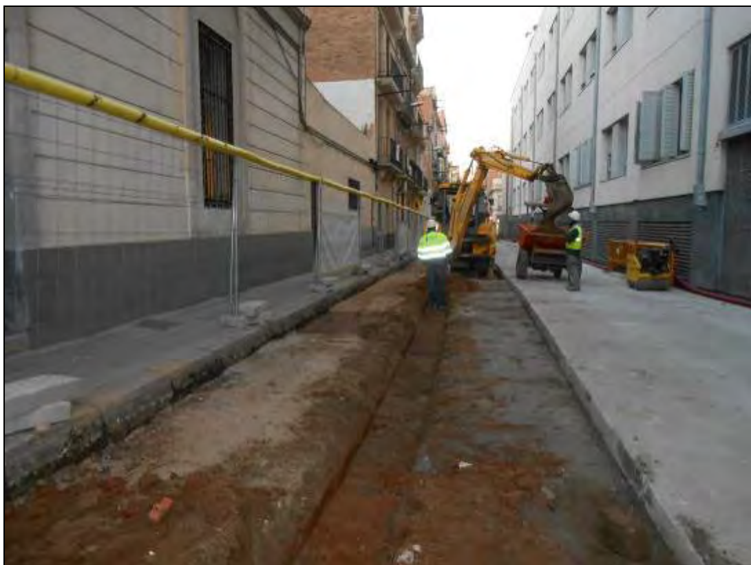
Foto 136: Tram 2. Rasa per al regadiu dels arbres.
