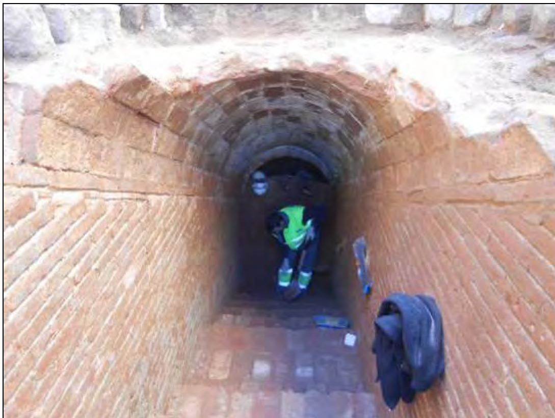
Foto 235: Netejant el tram final de l'accés al refugi.
