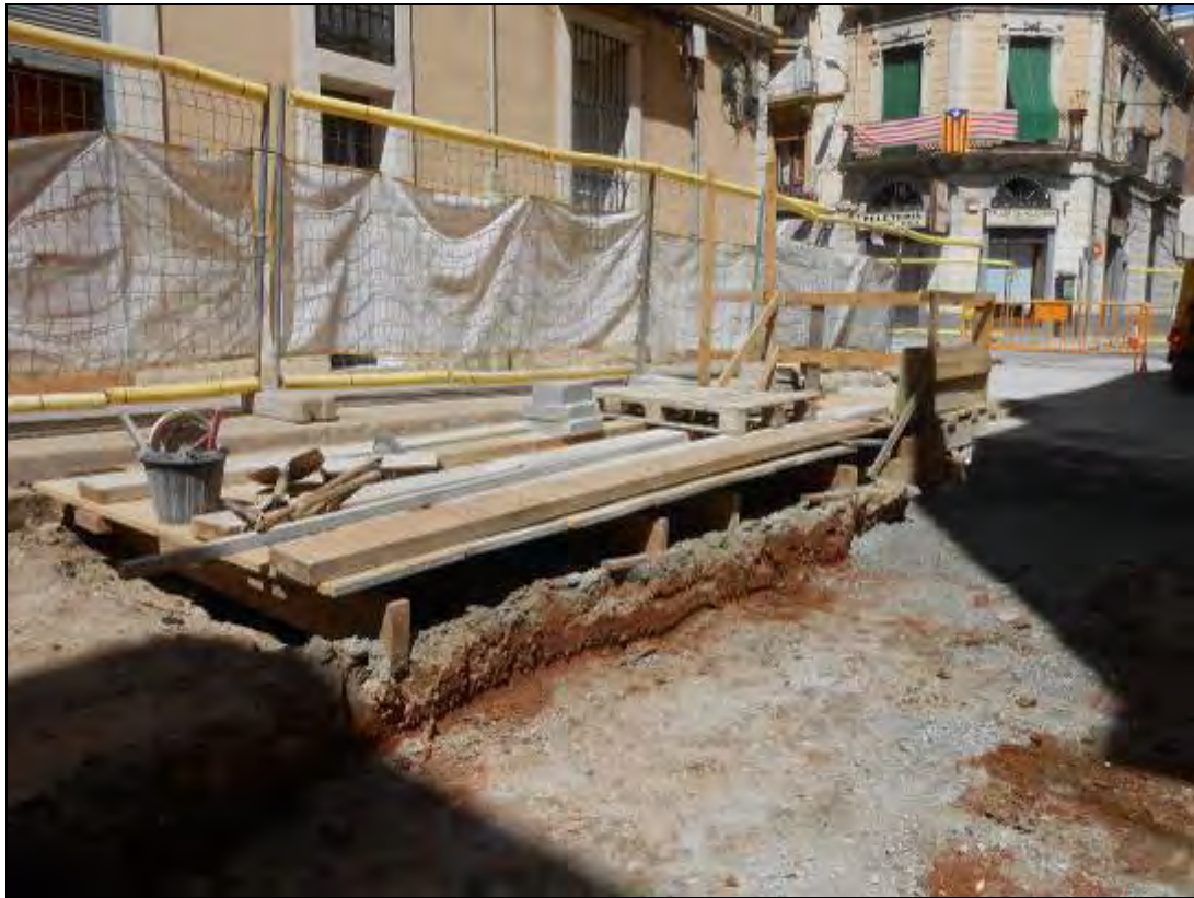
Foto 72: Tram 1. Rebaix del carrer al costat del refugi.
