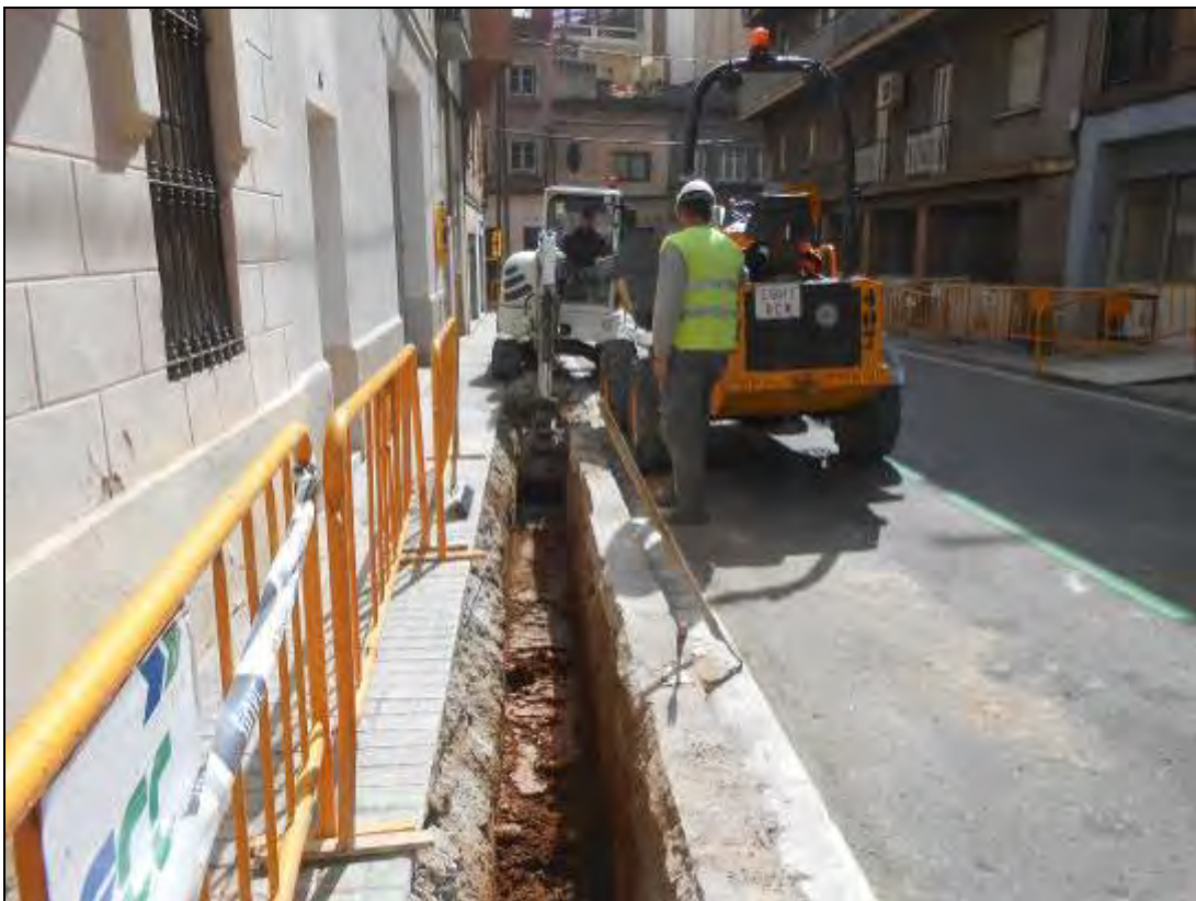
Foto 216: Tram 4. Rasa per a cablejat elèctric al carrer Amargor.
