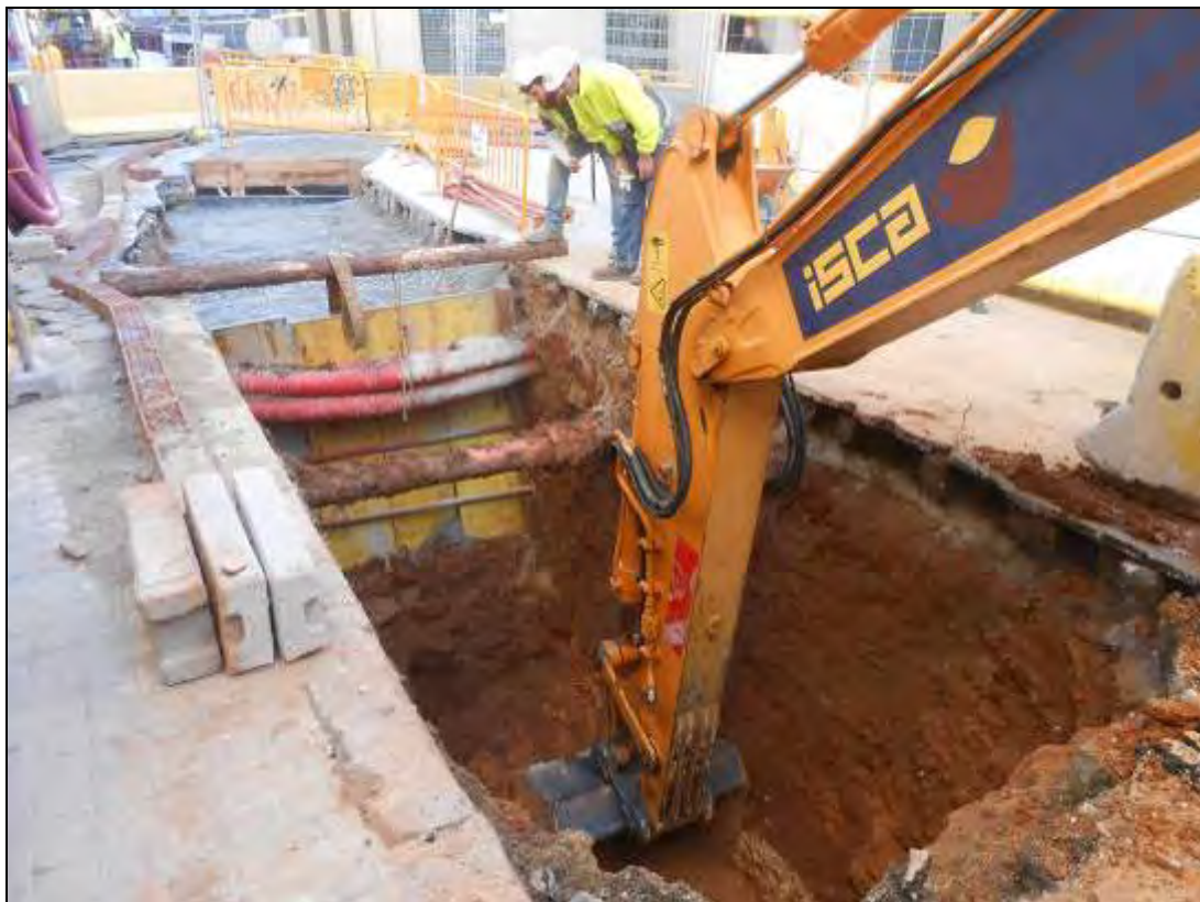
Fot 27: Tram 1. Rasa per al col·lector.
