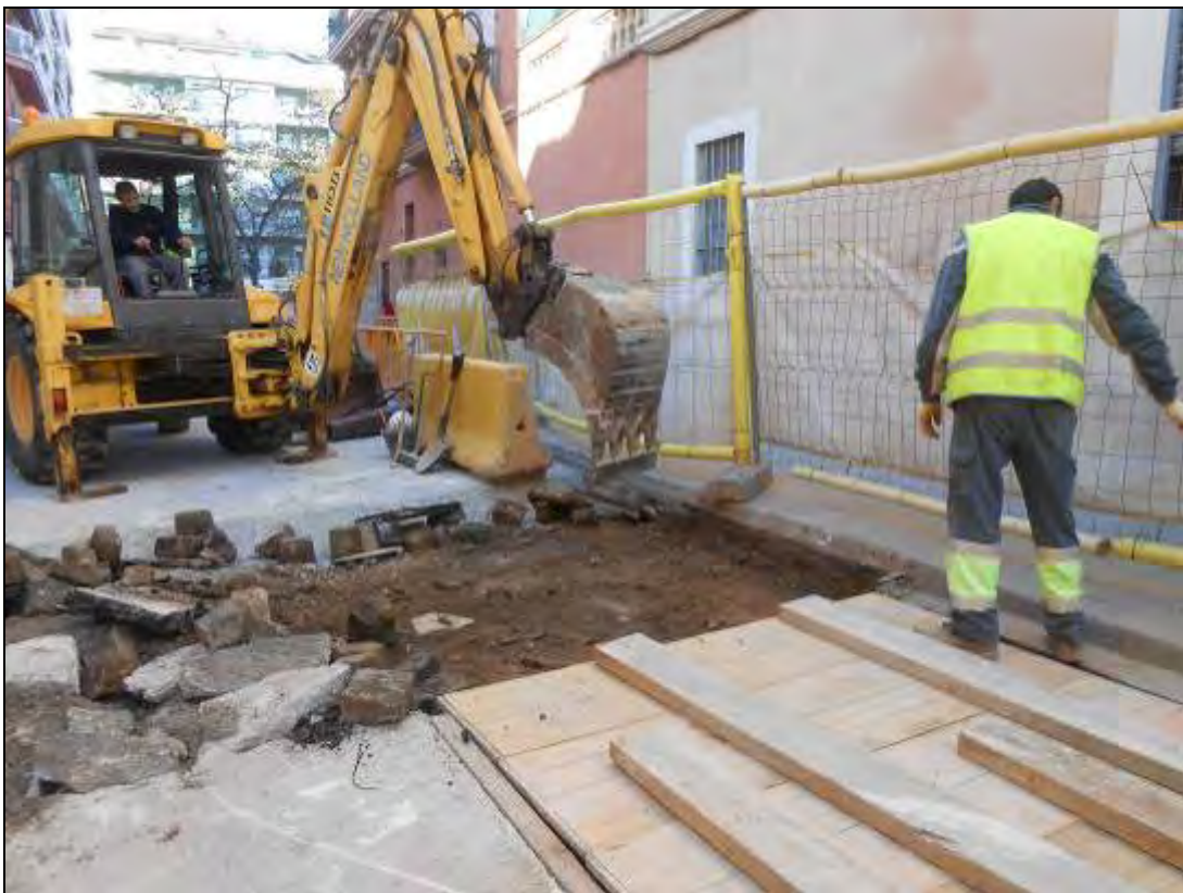
Foto 69: Tram 1. Rebaix del carrer al costat del refugi.
