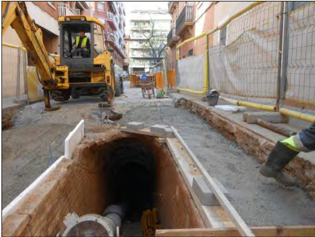
Foto 88: Tram 1. Procés de l'obra.
