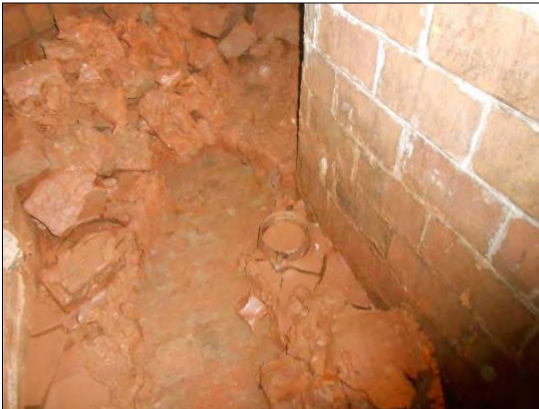
Foto 309: Vista del fang i la runa a l'entorn del pou d'accés o de ventilació.
