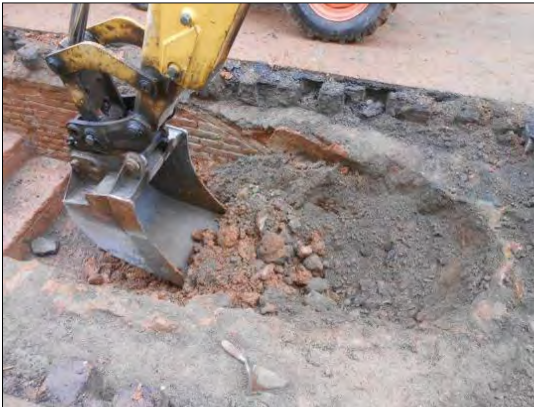
Foto 227: Procés d'extracció de terra amb la retroexcavadora.
