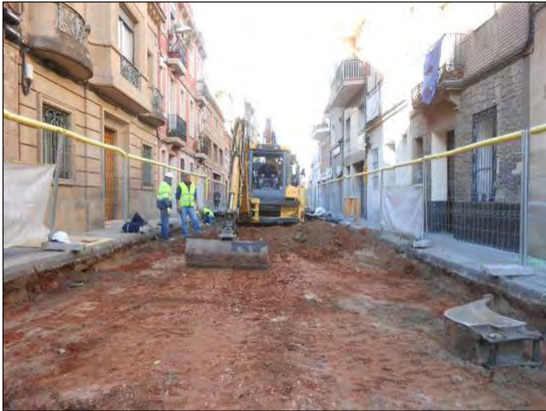
Foto 191: Tram 4. Procés de les obres.
