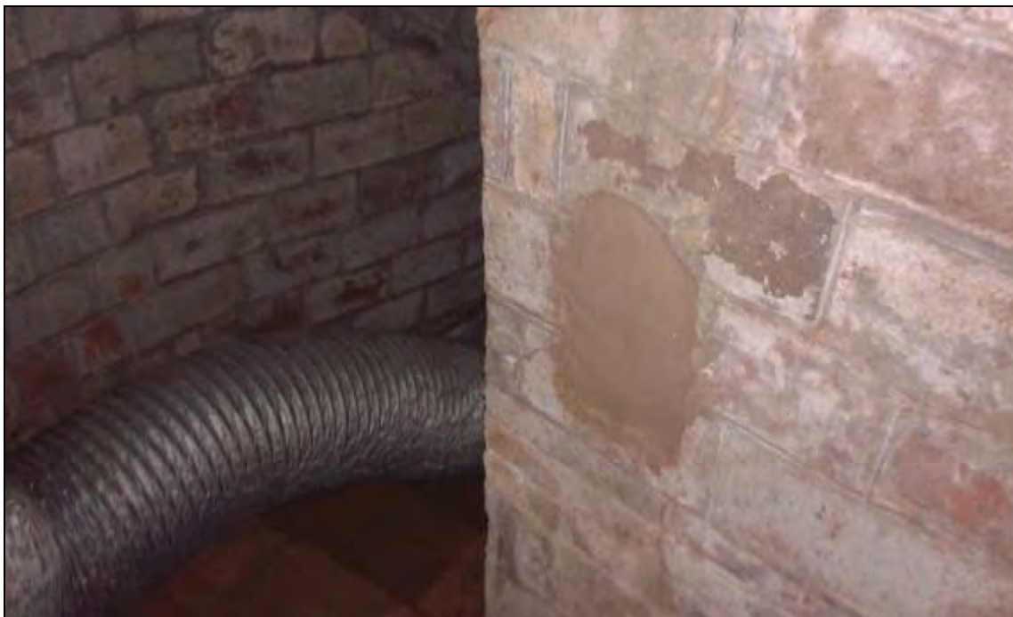
Foto 387: Restauració dels forats que es van fer per a travar l'accés tapiat del refugi.
