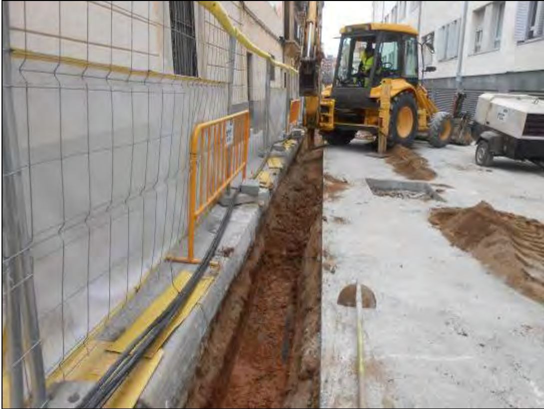
Foto 149: Tram 2. Rasa per al sotrament del cablejat elèctric.
