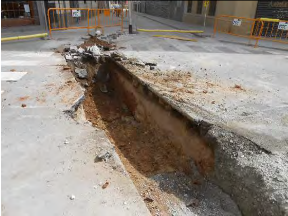
Foto 118: Tram 1. Rasa per a col·lector al carrer Muntanya.
