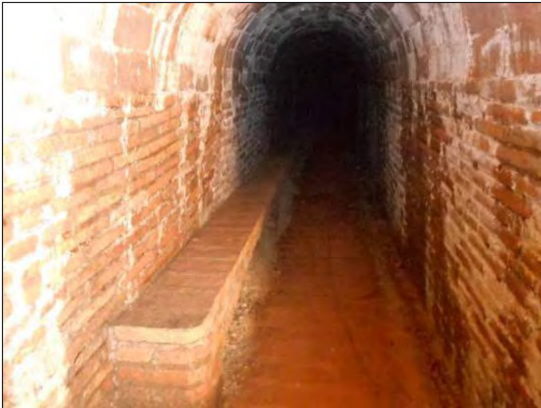
Foto 373: Últim tram del refugi ocupat pel banc 10. Foto feta des de l'entrada.
