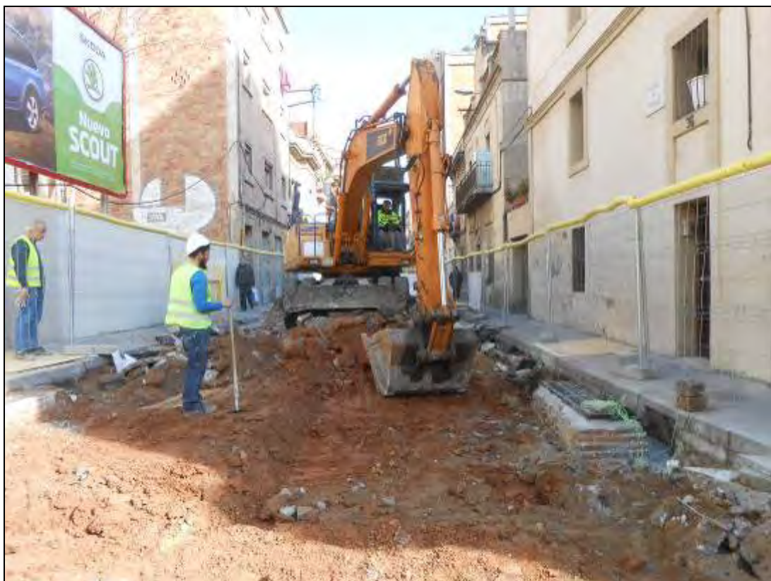
Foto 186: Tram 4. Obres de rebaix del carrer.
