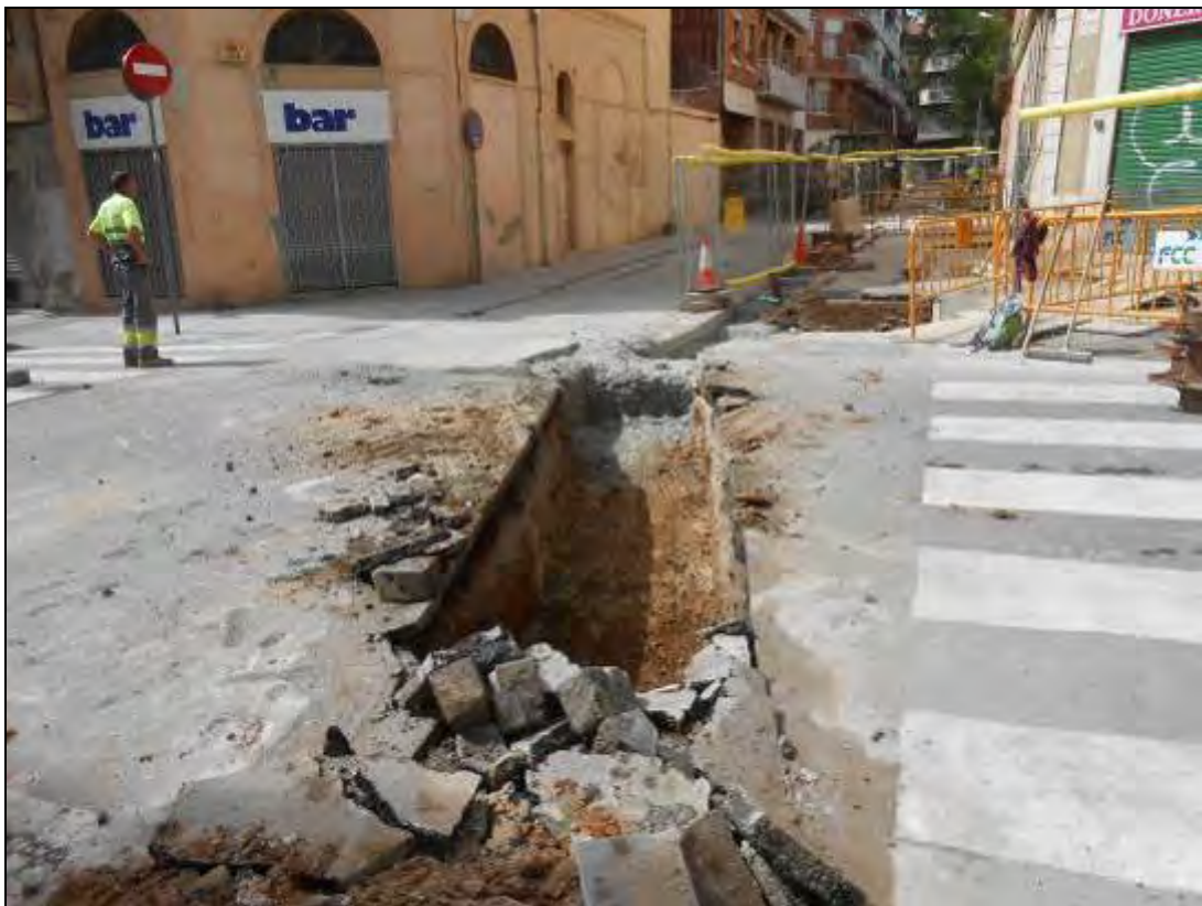
Foto 119: Tram 1. Rasa per a col·lector al carrer Muntanya.
