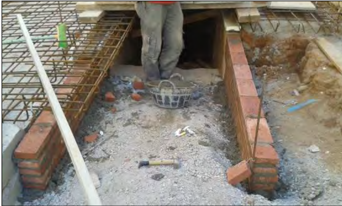
Foto 98: Tram 1: Construcció d'escales per a l'accés al refugi.
