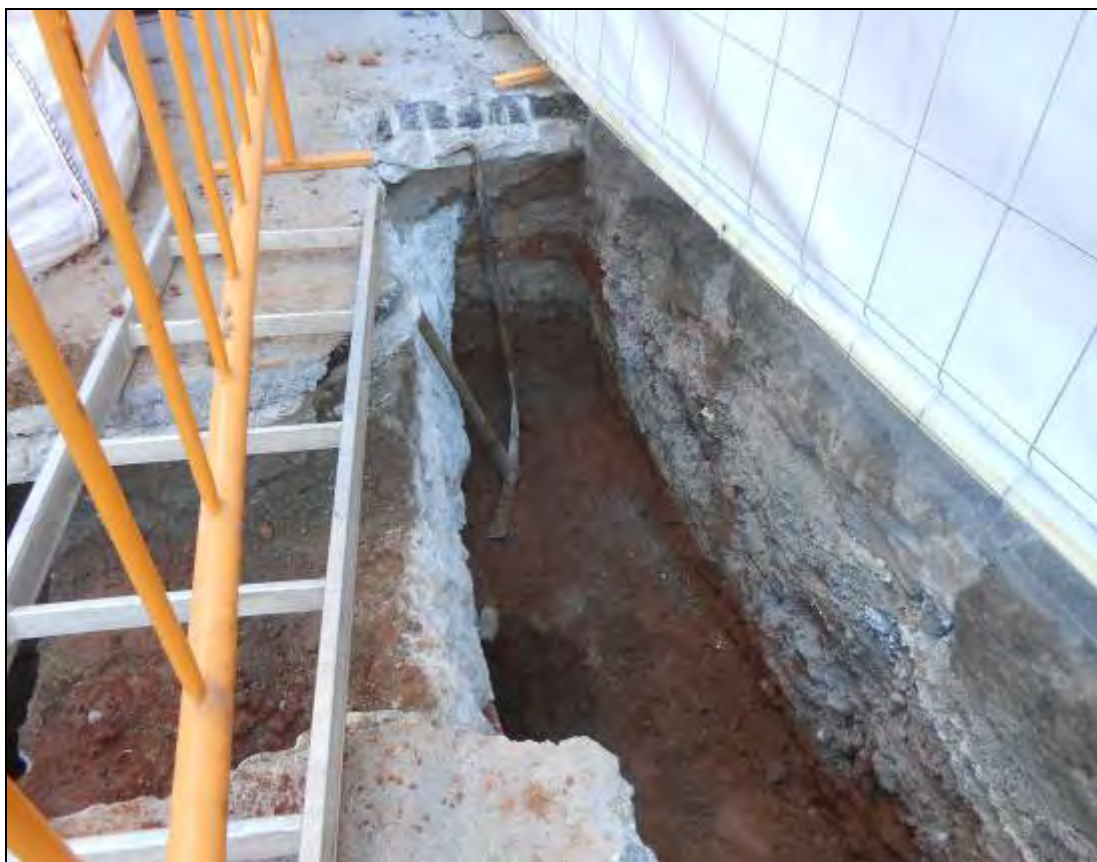
Foto 124: Tram 2. Es baixa l'embornal fins a trobar el col·lector.
