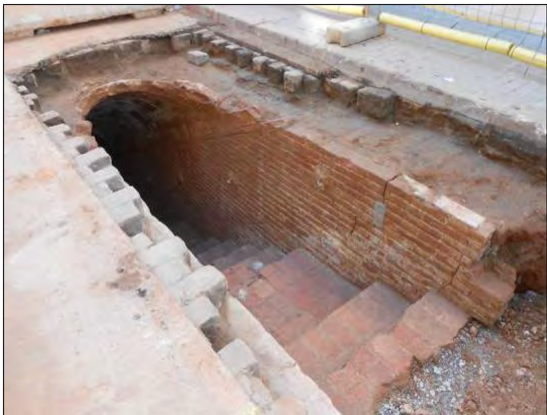
Foto 257: Accés al refugi. Es poden veure els passamans de ferro a la paret de la dreta.
