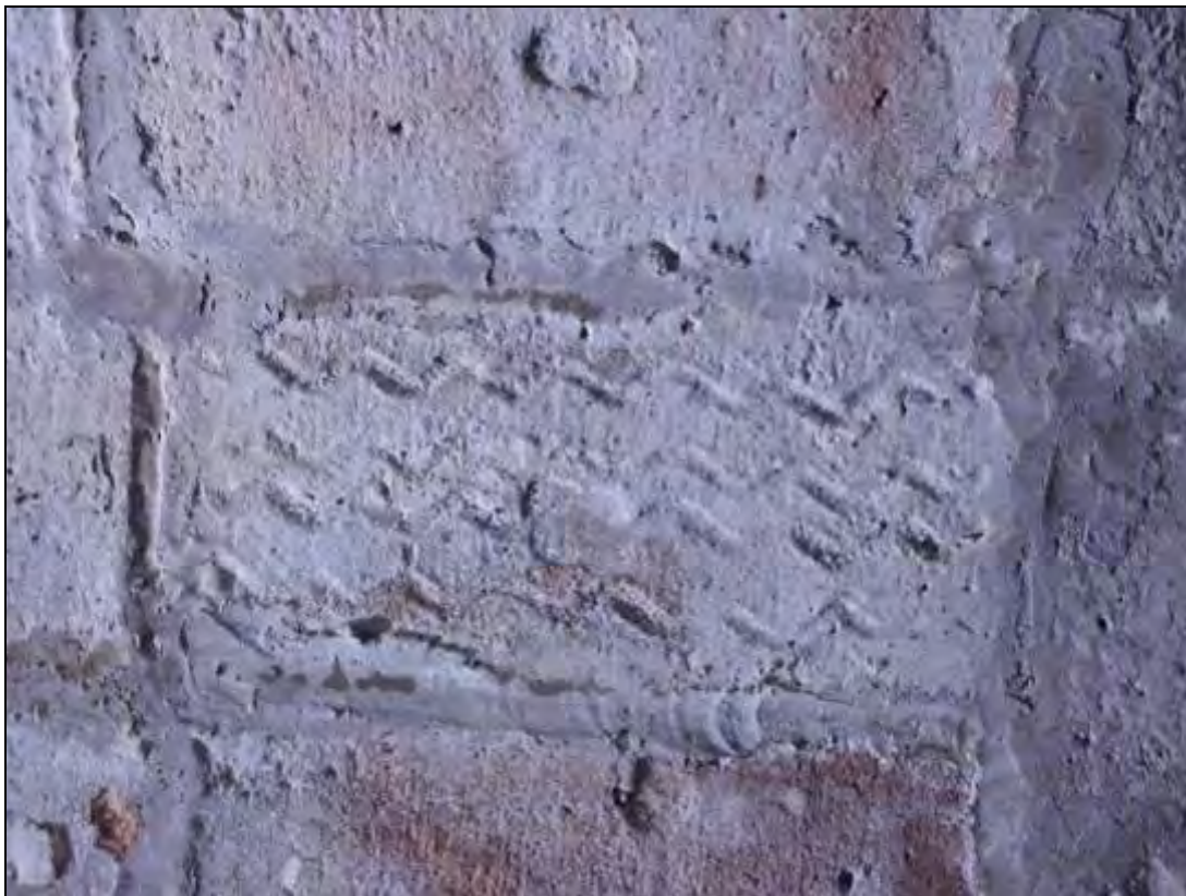
Foto 287: Dibuix fet amb ditades sobre el morter. Trobat al primer tram.
