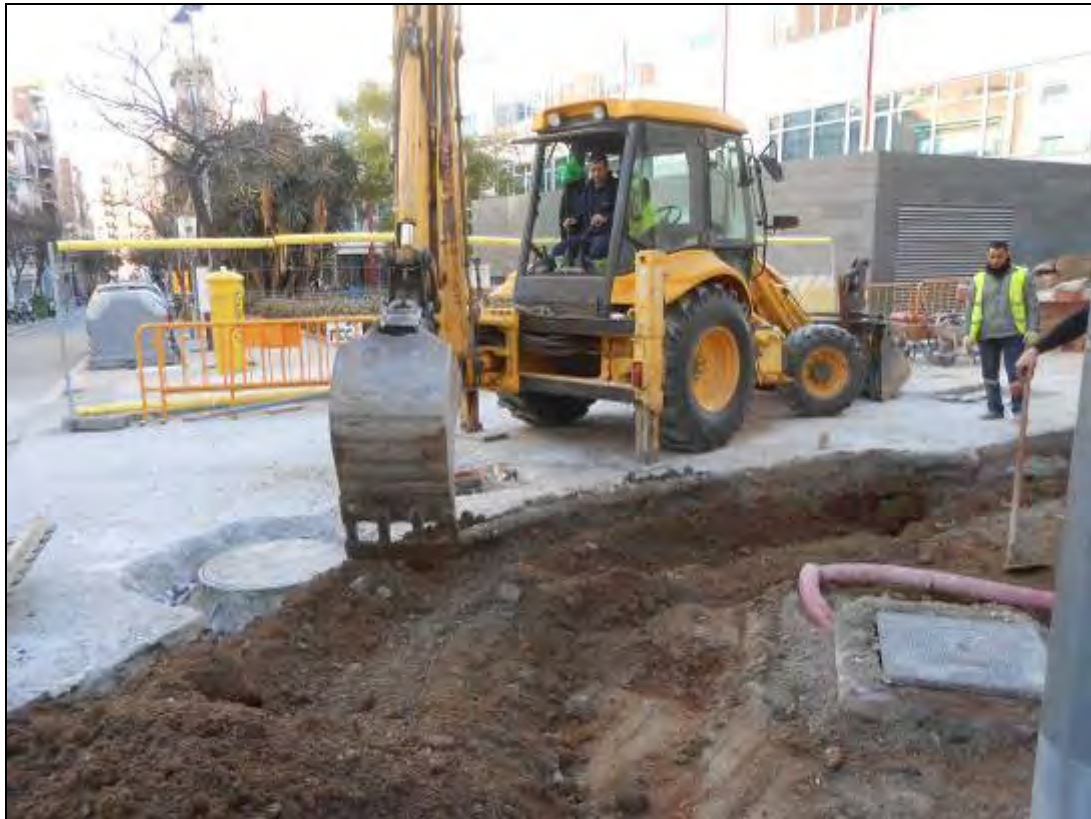
Foto 151: Tram 2. Rebaix a la cantonada amb el carrer Nació.
