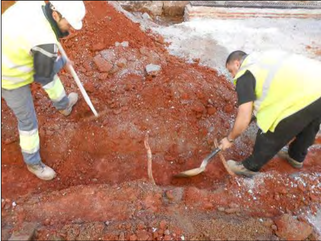
Foto 199: Tram 4. Exemple de serveis que han anat sortint en el procés de l'obra.
