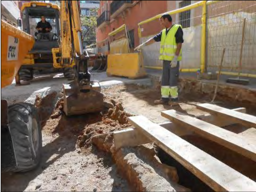
Foto 74: Tram 1. Rebaix del carrer al costat del refugi.
