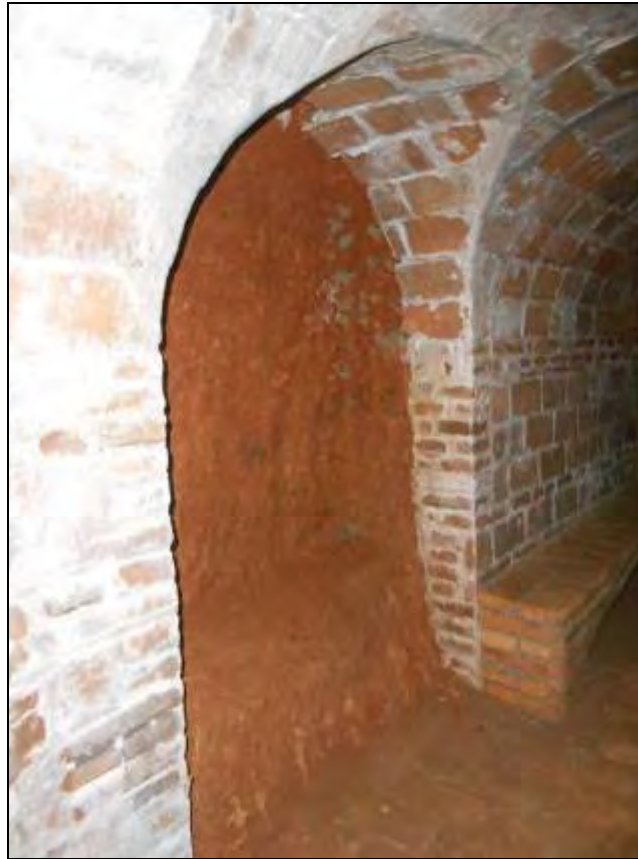
Foto 328: Vista del ramal 2 entre els bancs 5 i 6. Es pot veure que s'hi va picar un banquet a les argiles per a aprofitar l'espai. Foto feta des de l'entrada.
