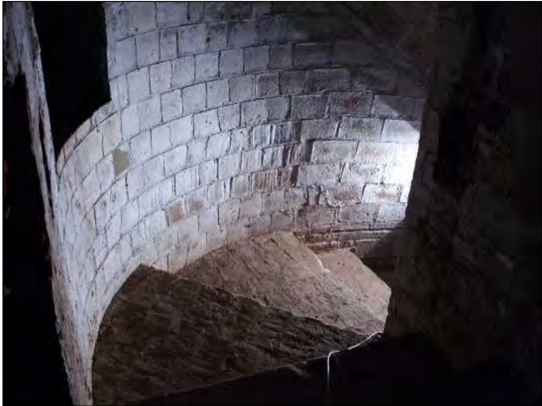
Foto 284: Últim tram d'escalas després d'haver estat netejat.
