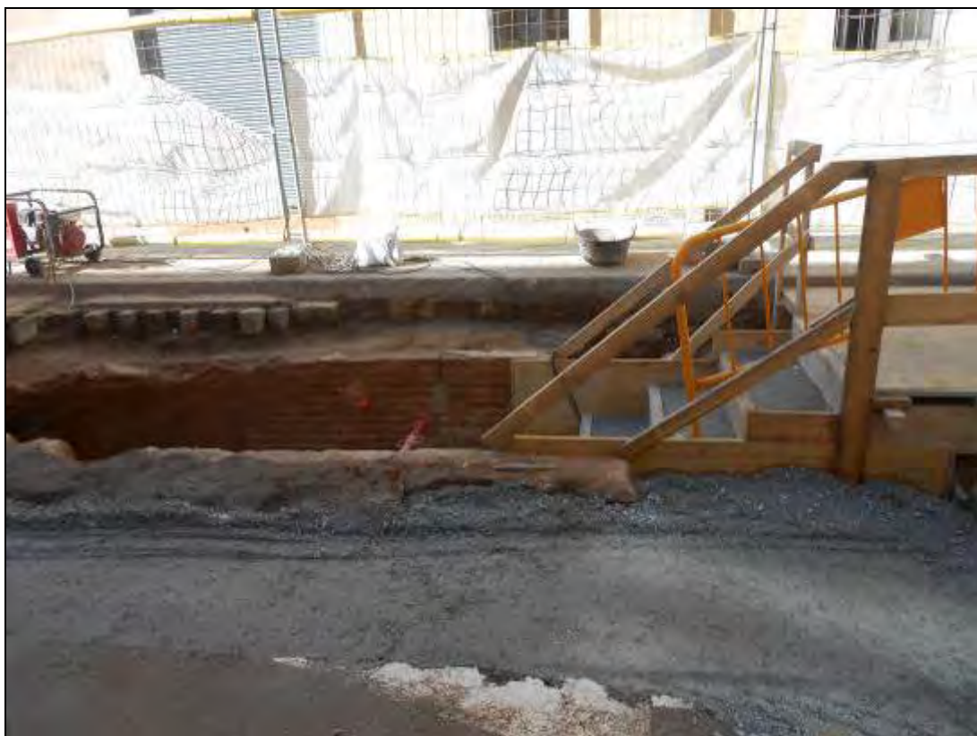
Foto 61: Tram 1. Procés de l'obra i vista de les escales provisionals del refugi.
