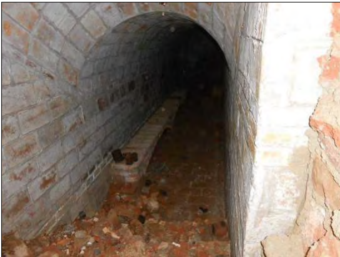
Foto 249: Primera vista de l'interior del refugi.
