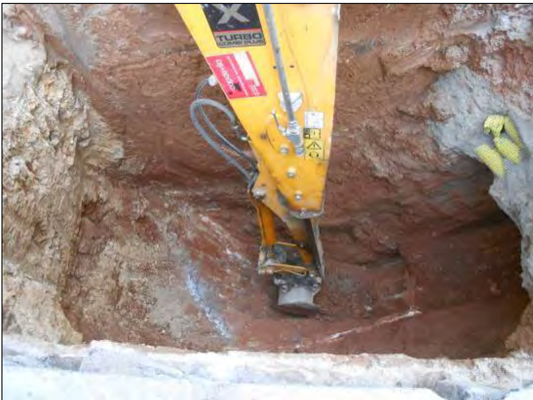
Foto 7: Tram 1. Rasa per al col·lector.
