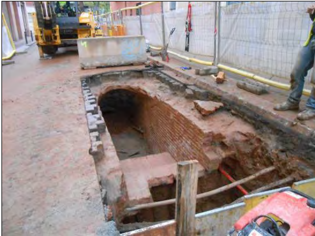
Foto 36: Tram 1. Vista del l'accés al refugi.
