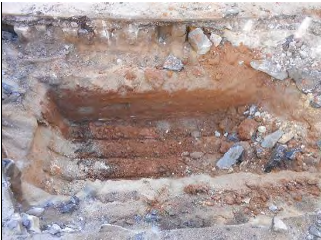
Foto 3: Tram 1. Inici de la rasa per al col·lector. Es poden veure les argiles.
