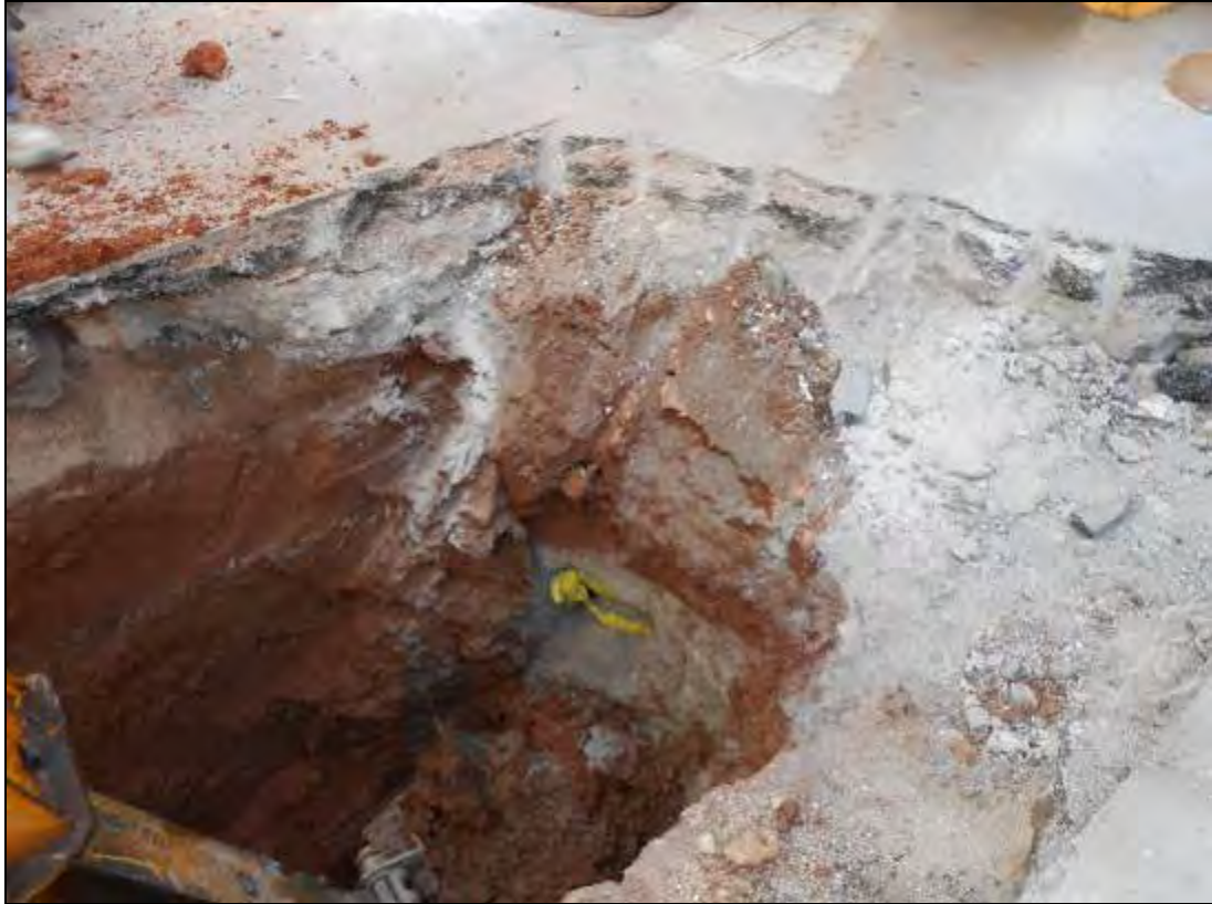
Foto 6: Tram 1. Rasa per al col·lector. Apareixen serveis.
