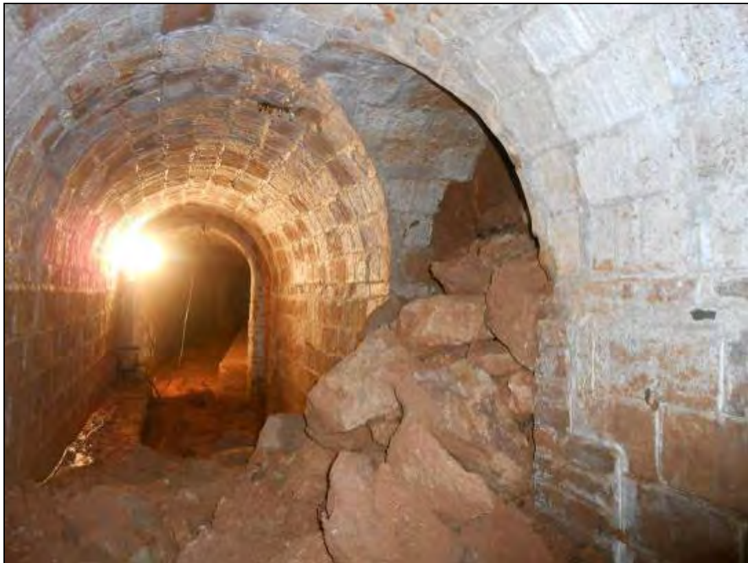
Foto 313: Tram del refugi amb el banc 4. Es pot veure la gran acumulació de runa provinent del pou d'accés o de ventilació. Foto feta des de l'entrada.
