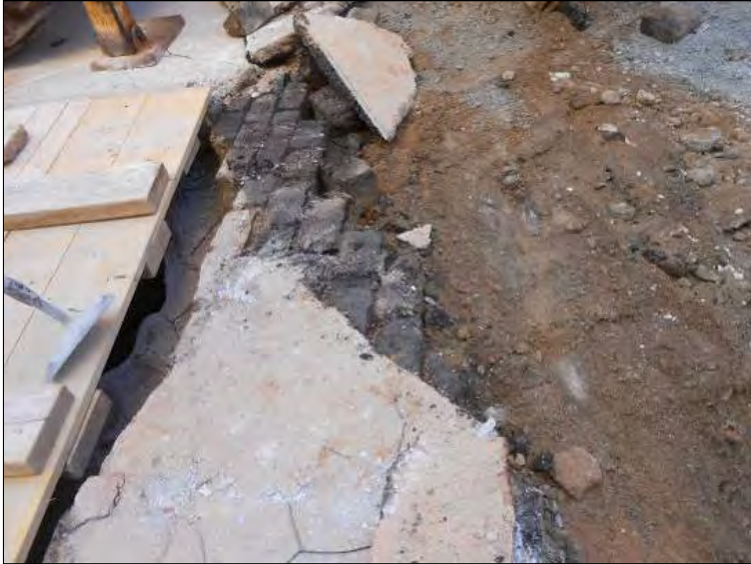
Foto 66: Tram 1. Rebaix del carrer al costat del refugi.
