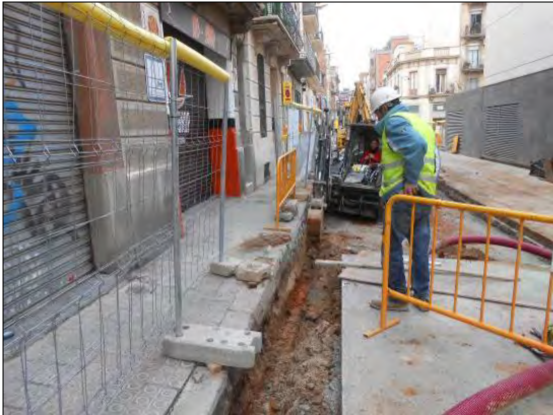
Foto 139: Tram 2. Rasa amb la bobcat per a soterrar el cablejat elèctric.
