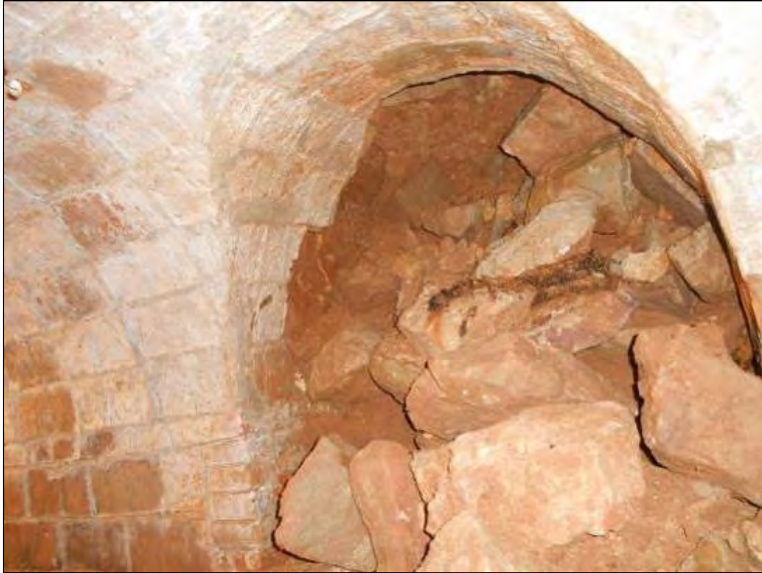
Foto 314: Vista del pou de ventilació o d'accés.
