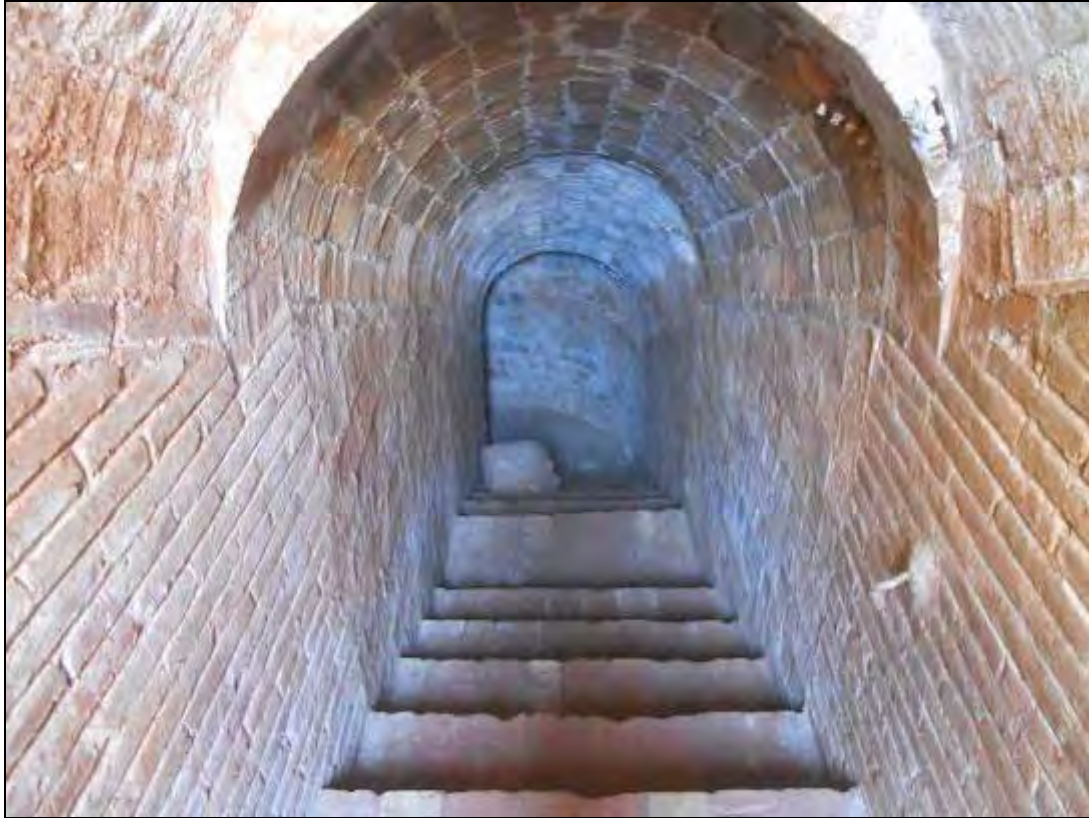
Foto 272: Accés al refugi.
