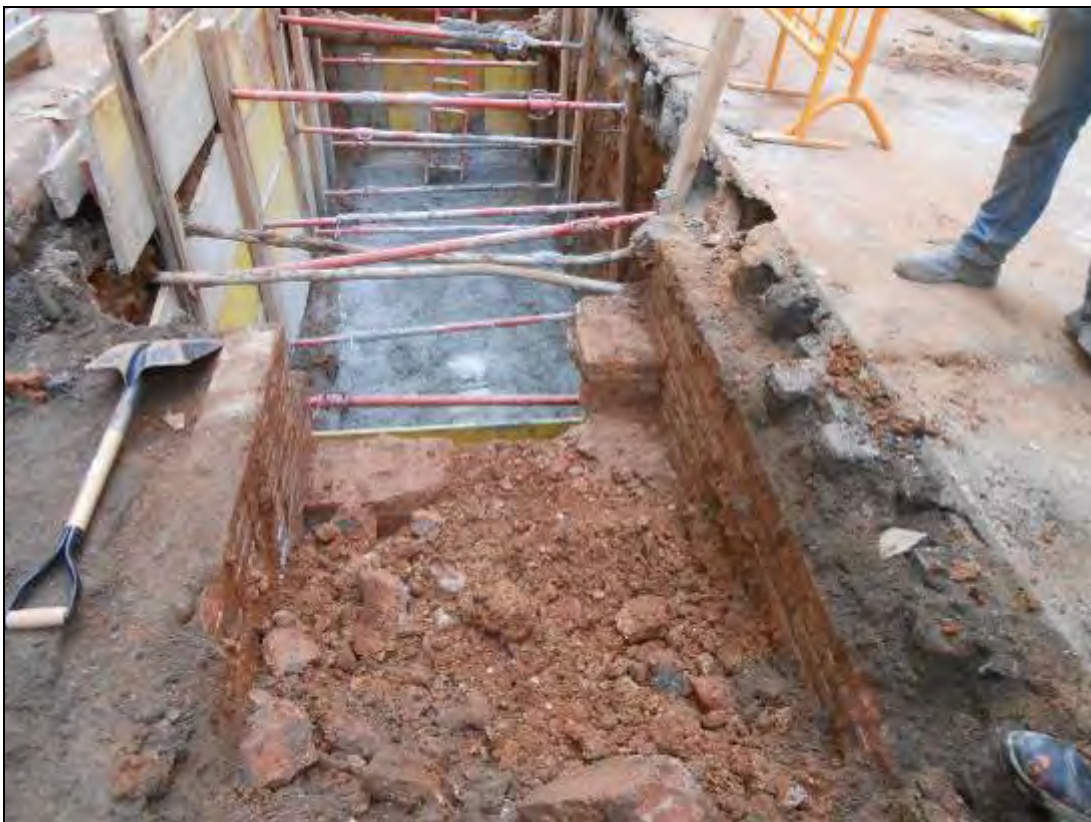
Foto 33: Tram 1. Vista de la rasa per al col·lector i del refugi.
