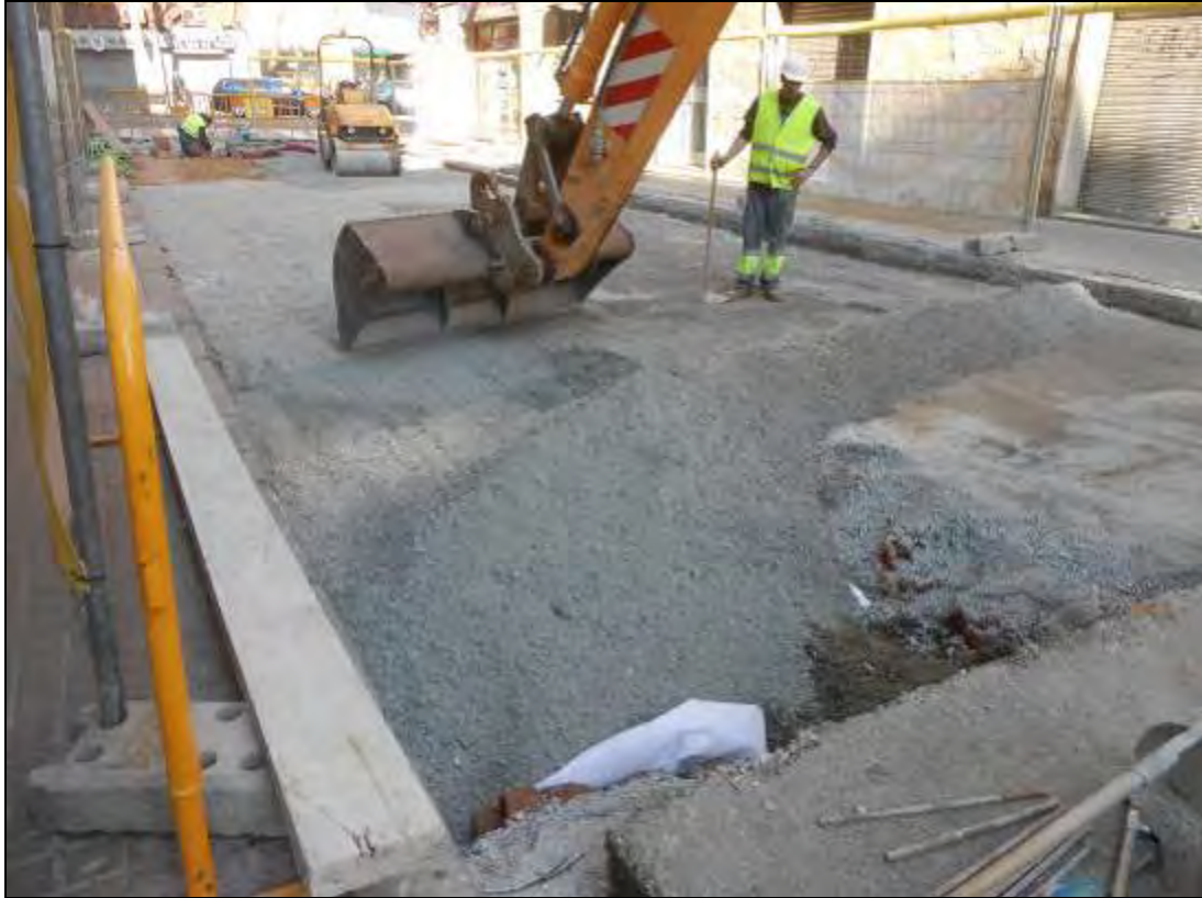
Foto 213: Tram 4. Procés de cobriment de l'estructura indeterminada (UE: 200).
