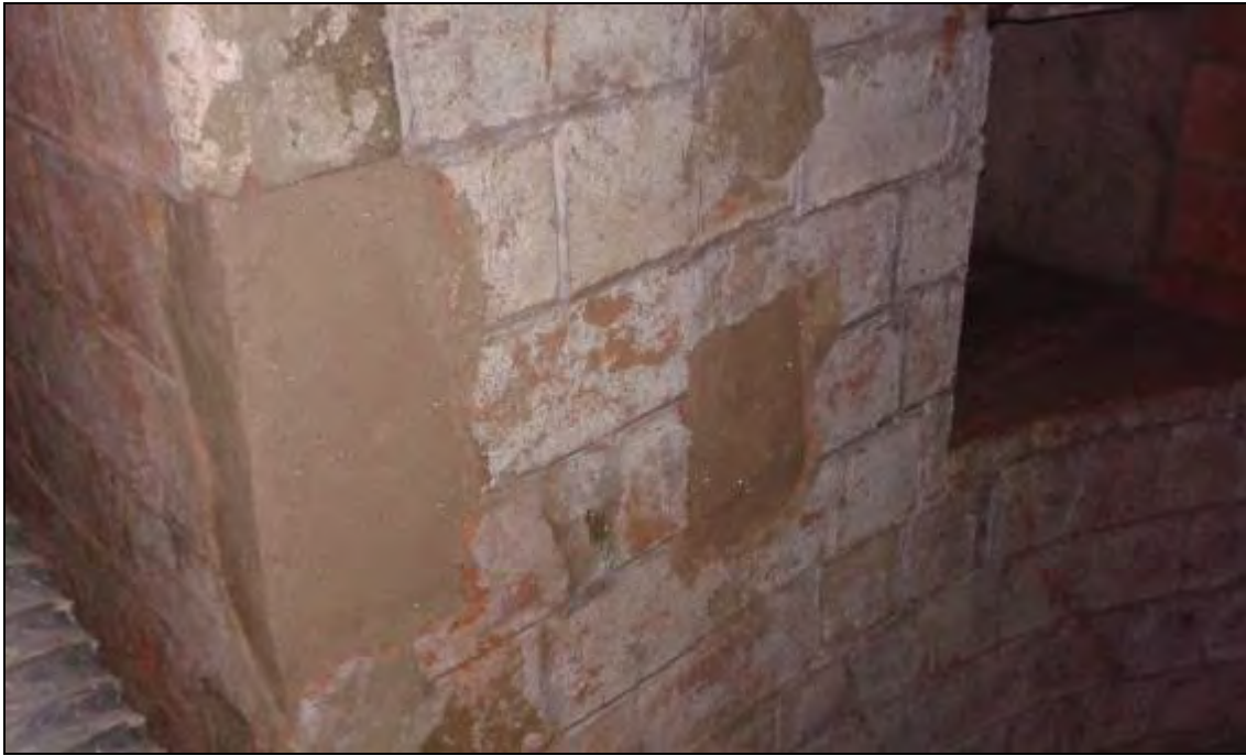
Foto 386: Restauració dels forats de l'accés del refugi a la zona que es trobava tapiat.
