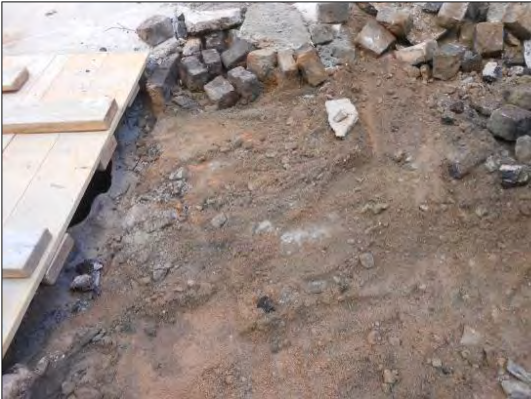
Foto 68: Tram 1. Rebaix del carrer al costat del refugi.
