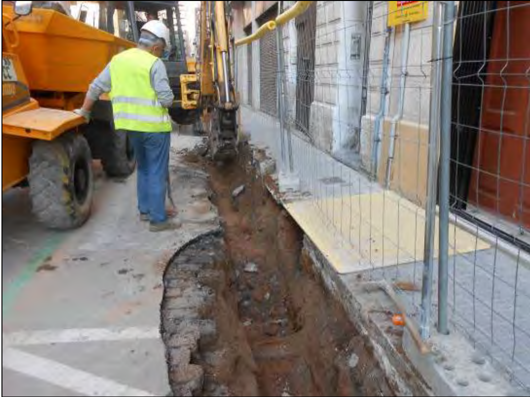
Foto 215: Tram 4. Rasa per a cablejat elèctric entre els carrers Sospir i Trinxant.
