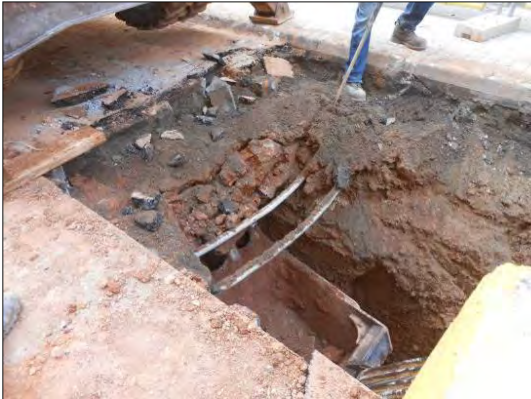
Foto 28: Tram 1. Rasa per al col·lector.
