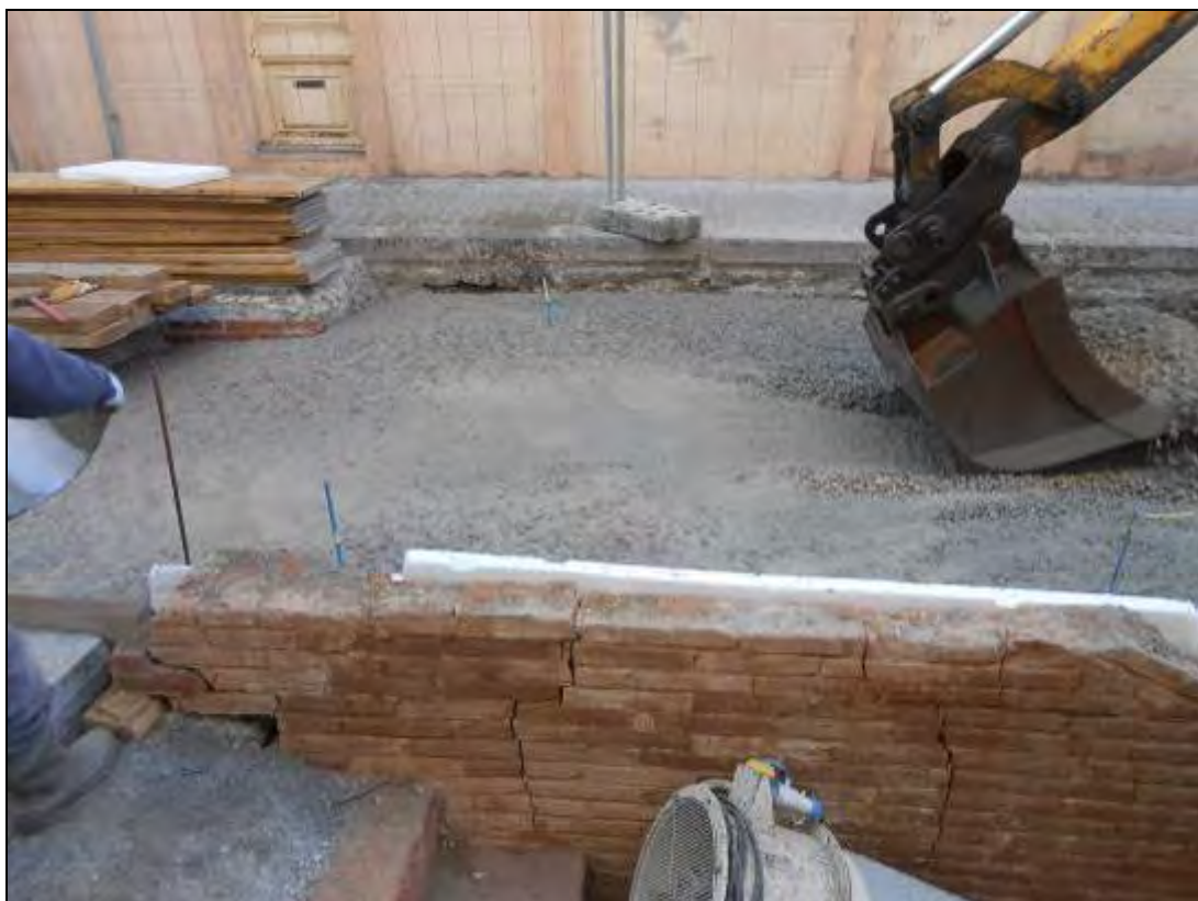
Foto 85: Tram 1. Procés del treball.
