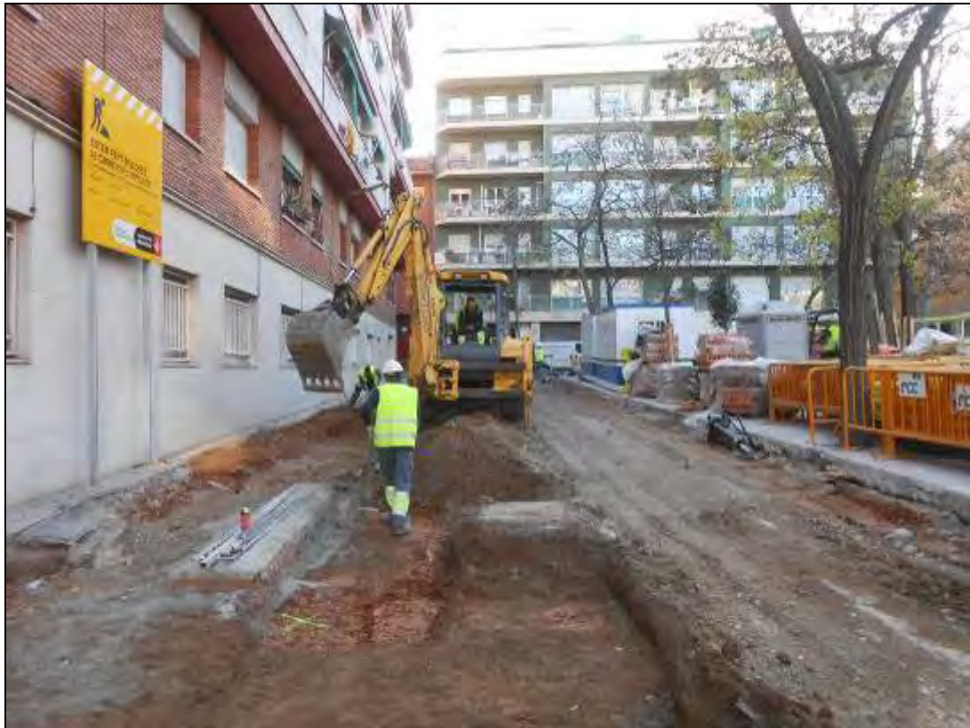
Foto 173: Tram 3. Procés de l'obra.
