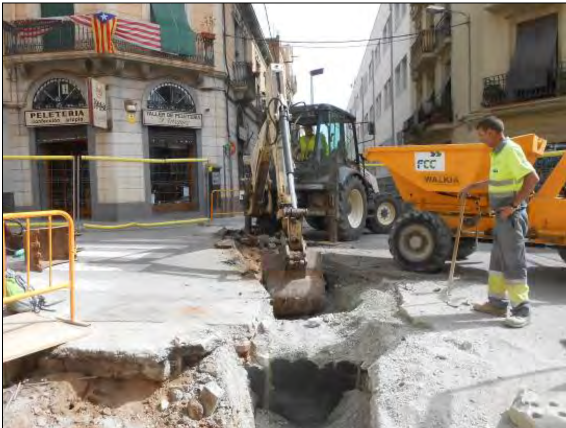
Foto 117: Tram 1. Rasa per a col·lector al carrer Muntanya.
