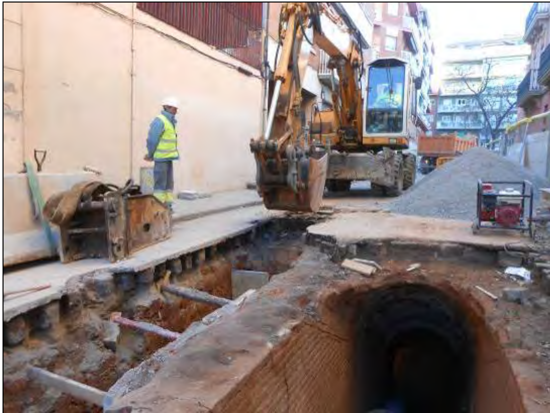
Foto 52: Tram 1. Vista del procés de l'obra.
