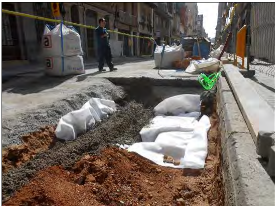
Foto 210: Tram 4. Procés de cobriment de l'estructura indeterminada (UE: 200).
