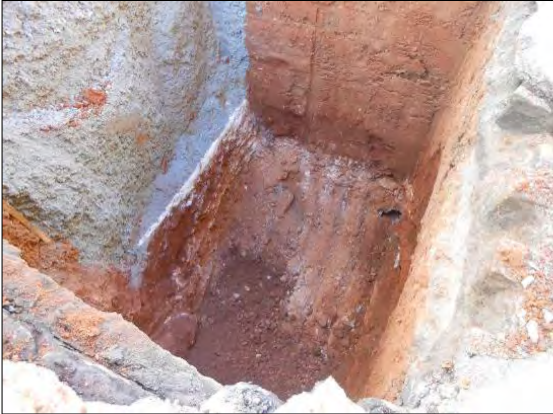
Foto 44: Tram 1. Ampliació del col·lector al costat del refugi.
