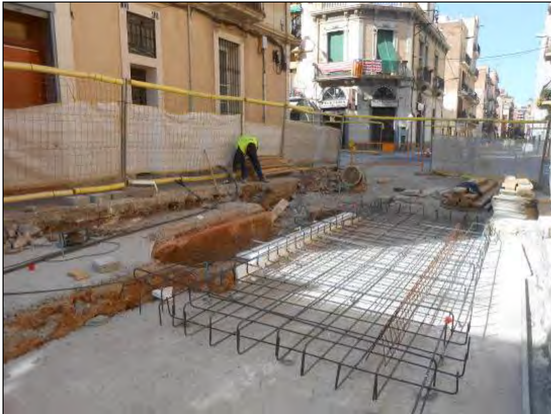
Foto 94: Tram 1. Procés de l'obra.
