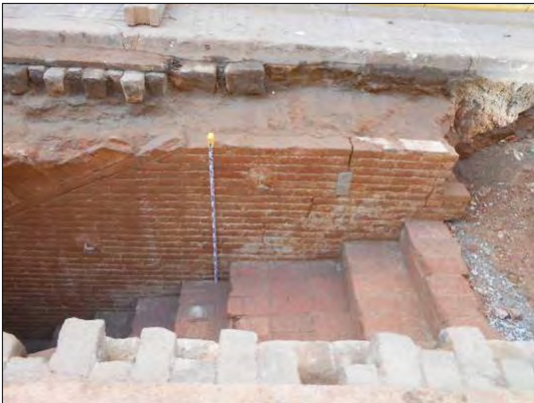
Foto 261: Accés al refugi.
