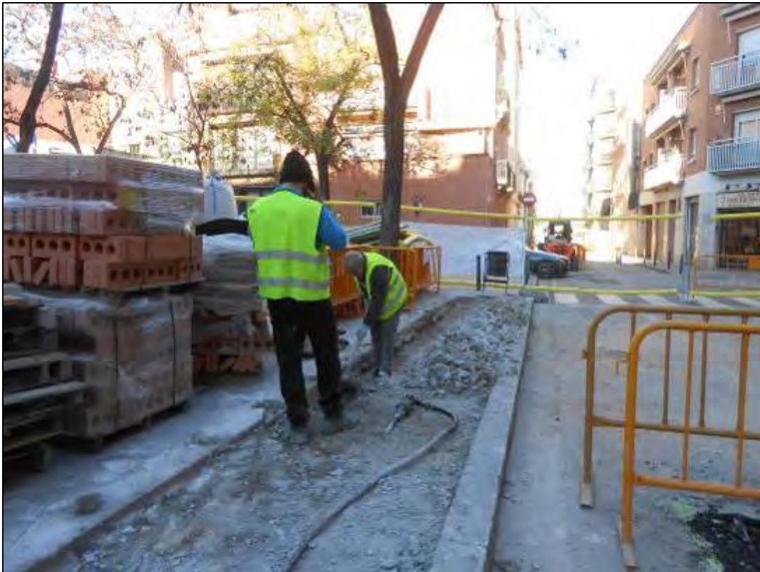
Foto 170: Tram 3. Aixecament de la vorera de la Plaça de can Robacols.
