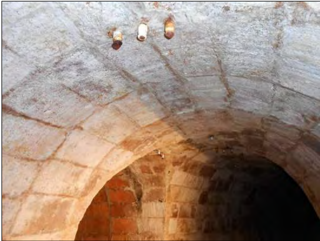
Foto 342: Ramal 4. Detall del sostre. Es poden veure els aïllants de porcellana.
