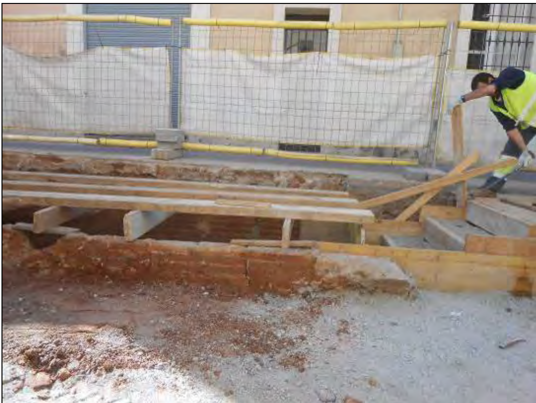
Foto 79: Tram 1. Procés de l'obra. Vista del refugi.
