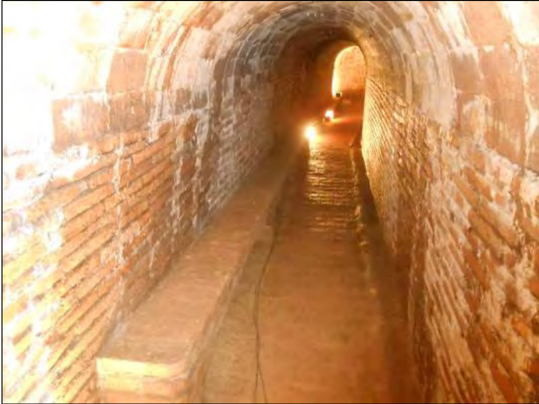
Foto 374: Tram de passadís del banc 10 després d'haver estat netejat. Es pot veure un canaló de morter prop de la paret dreta, segurament per a reconduir l'aigua de les pluges.
