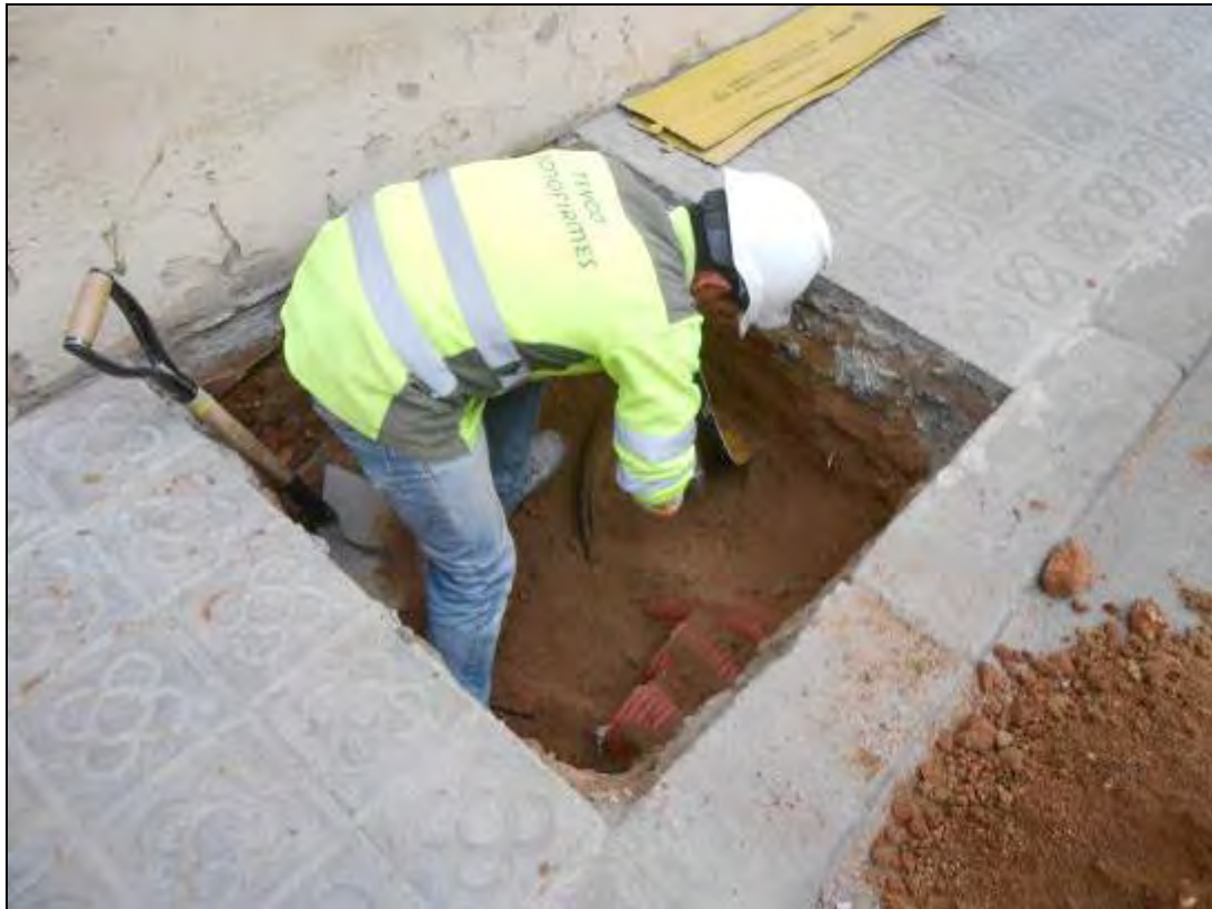
Foto 177: Tram 4. Vista d'un dels sondejos efectuats per a trobar serveis.
