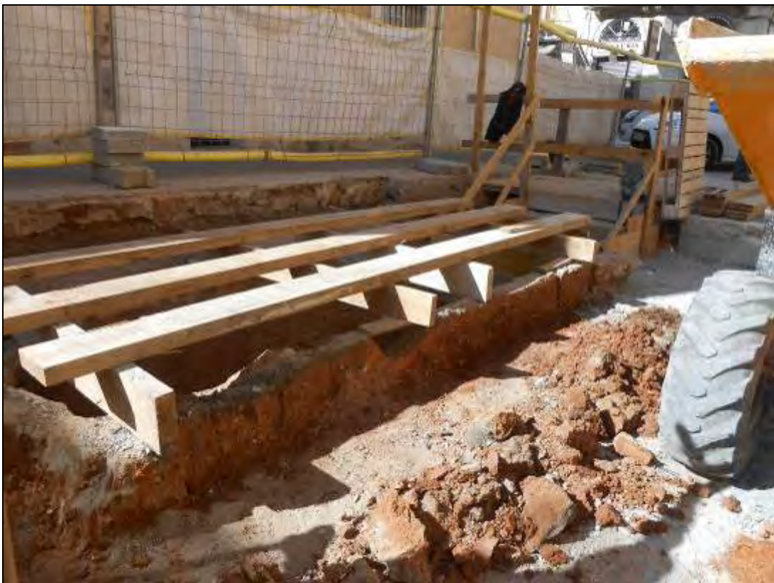
Foto 77: Tram 1. Rebaix del carrer al costat del refugi.
