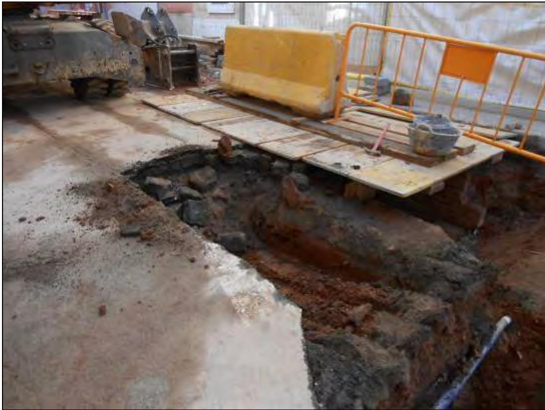
Foto 46: Tram 1. Ampliació del col·lector al costat del refugi.
