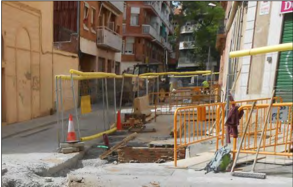
Foto 110: Tram 1. Vista de la zona del refugi després d'haver estat formigonat.
