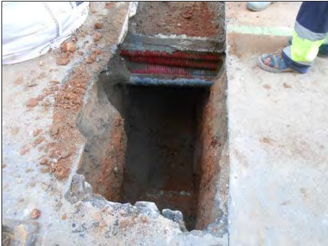
Foto 26: Tram 1. Rasa per al col·lector.
