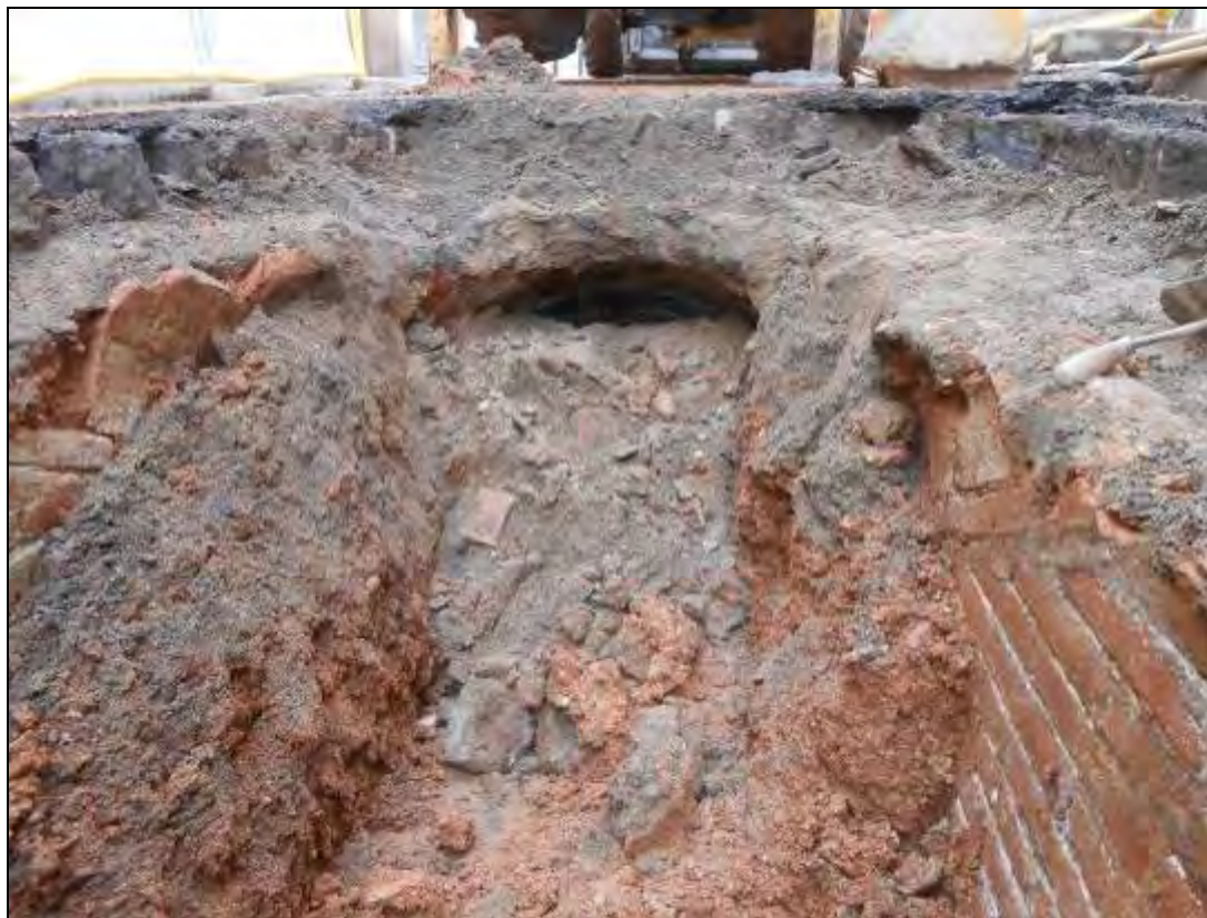
Foto 229: Vista de les escales amb l'inici de la volta tot cobert de runa.
