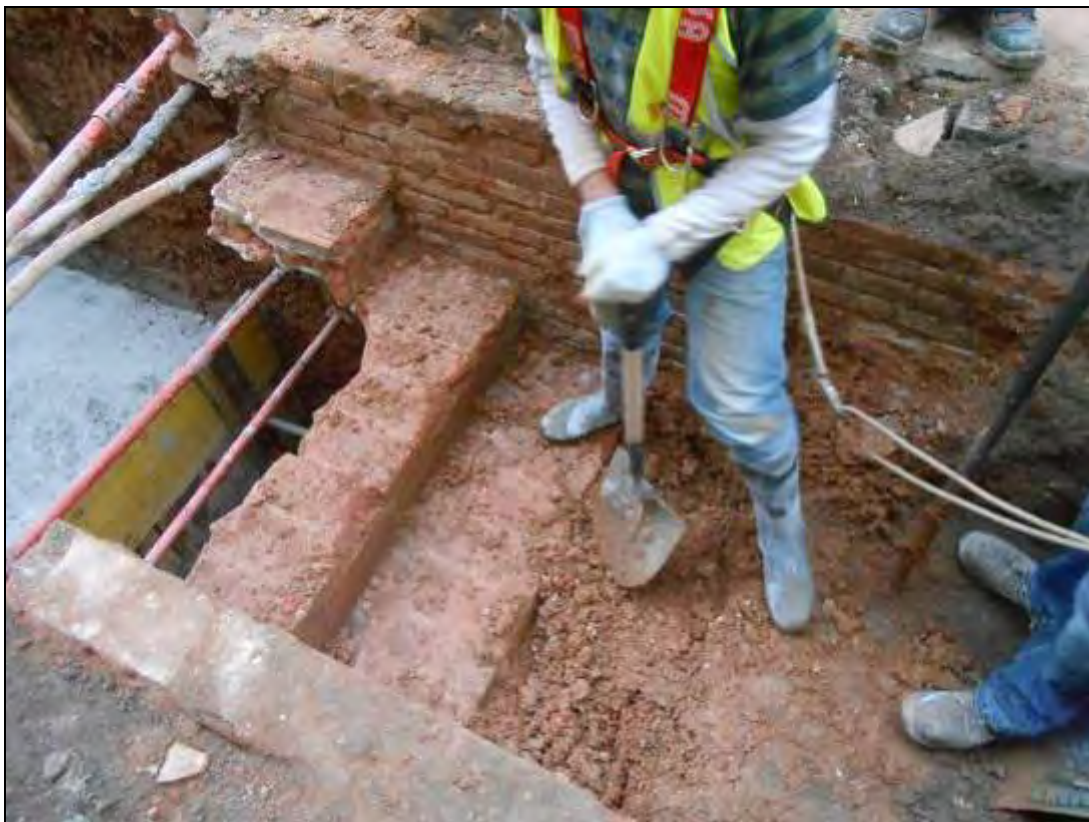
Foto: 225: Treballs d'extreure la terra que cobreix tot l'accés del refugi.
