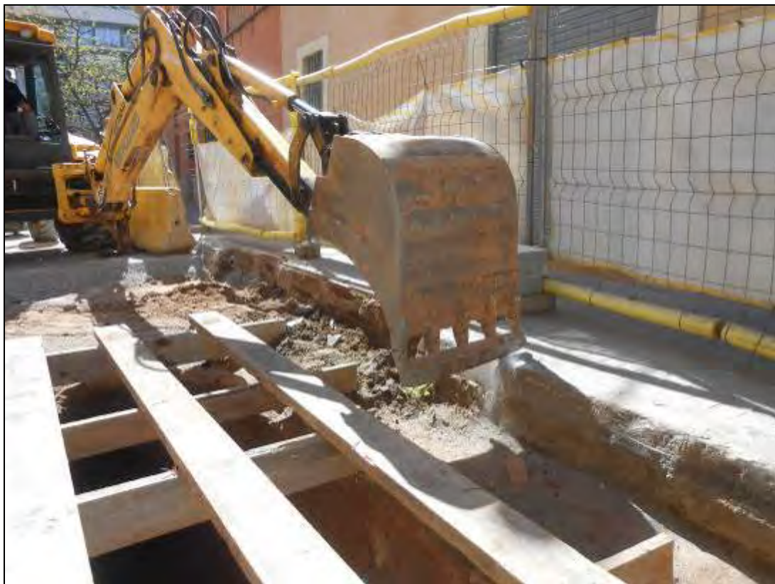
Foto 73: Tram 1. Rebaix del carrer al costat del refugi.
