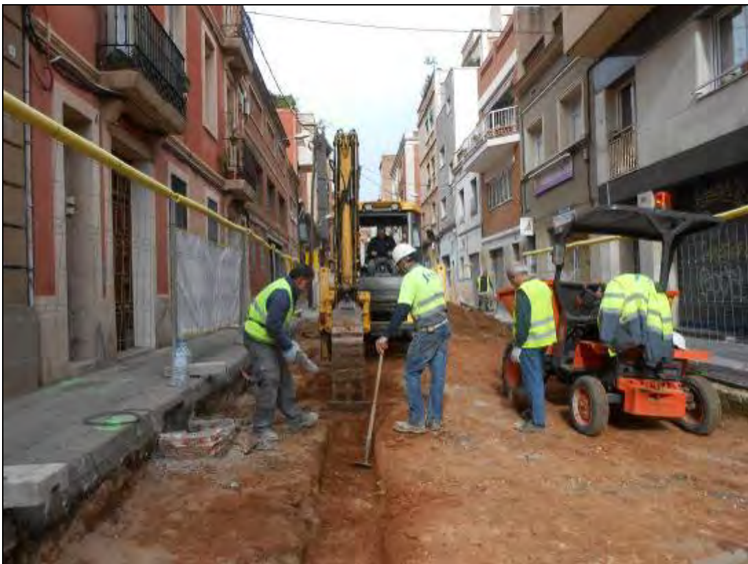
Foto 190: Tram 4. Procés de les obres.
