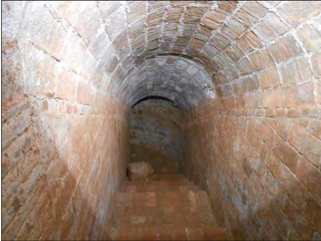
Foto 240: Vista de l'accés al refugi.
