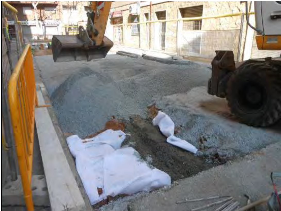
Foto 211: Tram 4. Procés de cobriment de l'estructura indeterminada (UE: 200).
