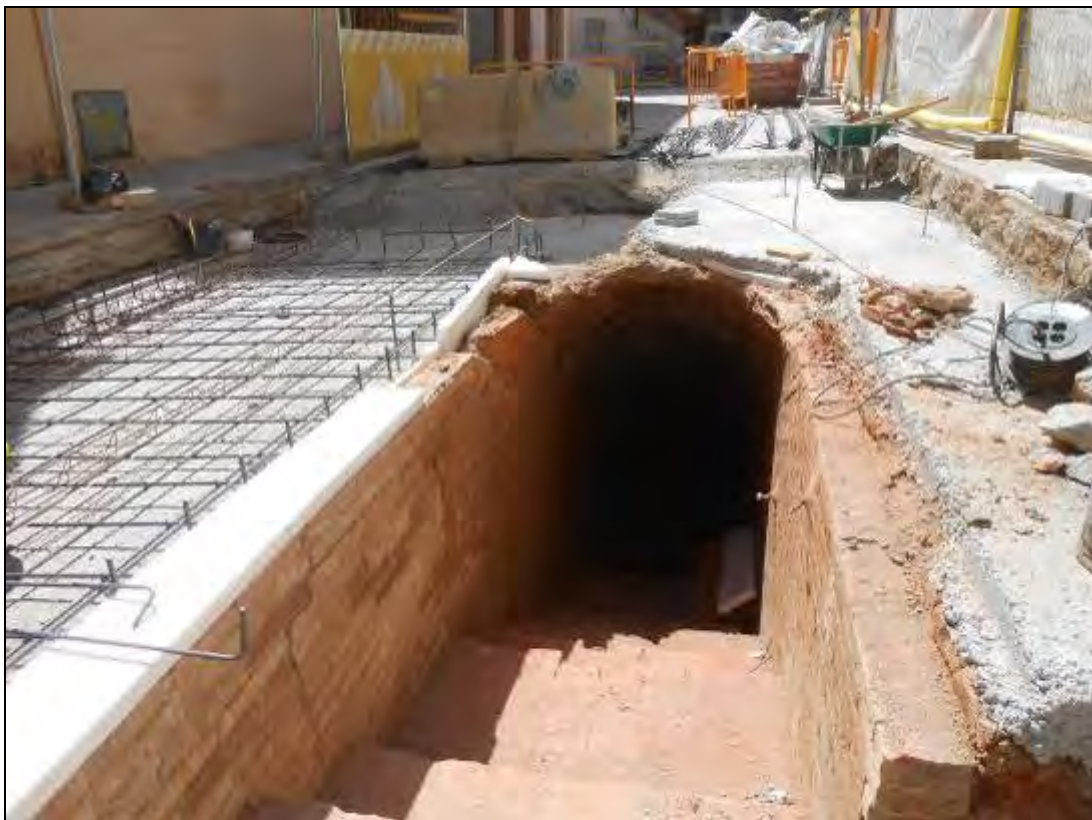
Foto 93: Tram 1. Procés de l'obra amb la col·locació de la malla de ferro i el porexpan.
